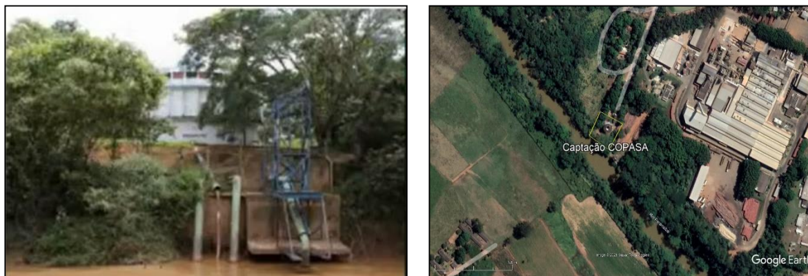
Figura 3 - Mosaico de fotos da captação superficial no rio Paranaíba, em Patos de Minas
