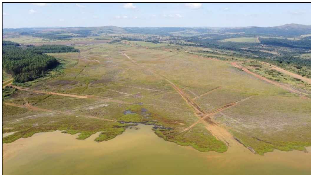
Figura 7.6 - Construção da drenagem de espinha peixe no reservatório da Barragem B5 (16/05/2022).
