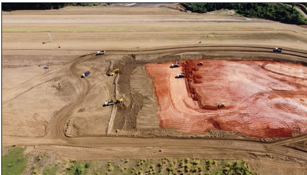
Figura 7.4 – Escavação de underflow da praia da Barragem B5 com recomposição em material siltoso - Foto 03 (16/05/2022).
