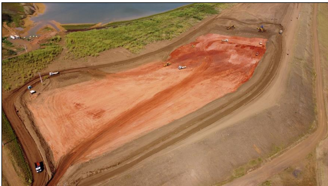
Figura 7.3 – Escavação de underflow da praia da Barragem B5 com recomposição em material siltoso - Foto 02 (16/05/2022).
