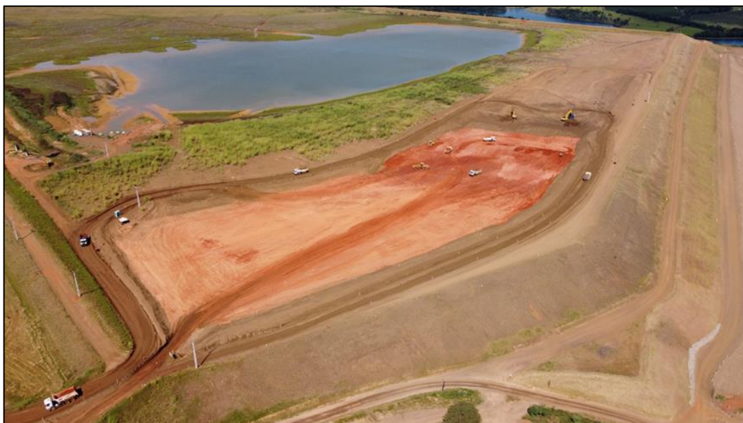
Figura 7.2 – Escavação de underflow da praia da Barragem B5 com recomposição em material siltoso - Foto 01 (16/05/2022).
