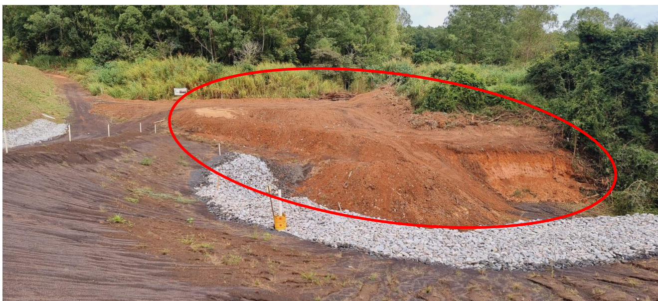
Figura 7.7 – Supressão vegetal da área de interface com a região de implantação do reforço da Barragem B5 (23/05/2022).
