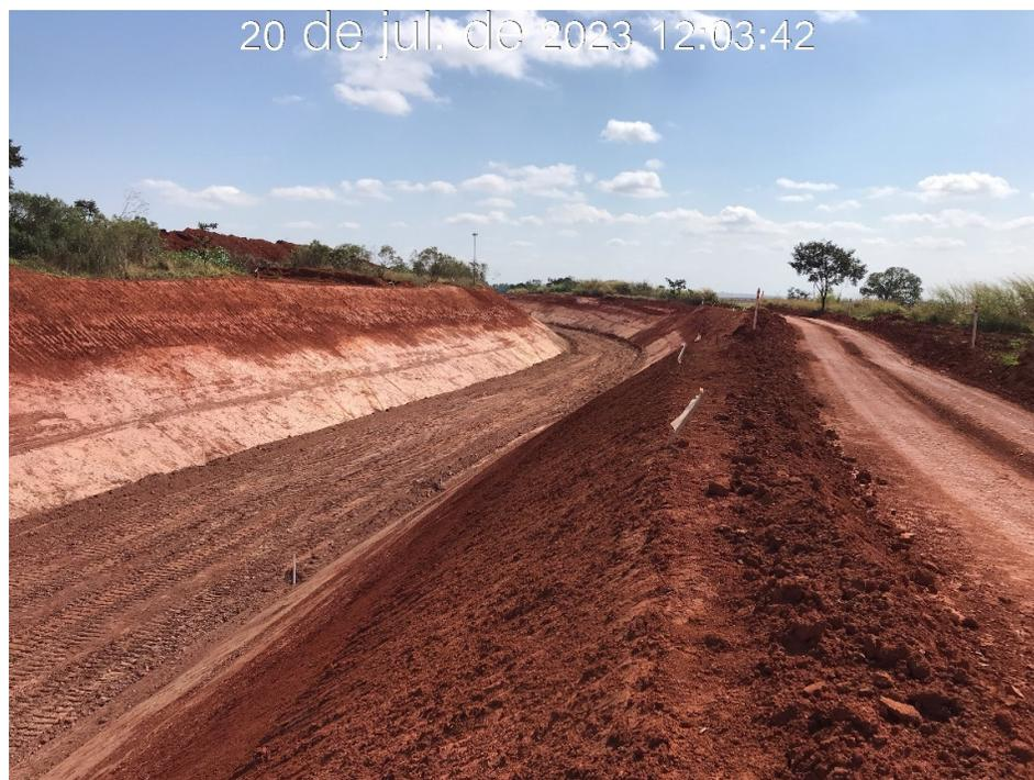
Figura 7.10 – Escavação do canal periférico na estaca 115, com vista para jusante (20/07/2023).
