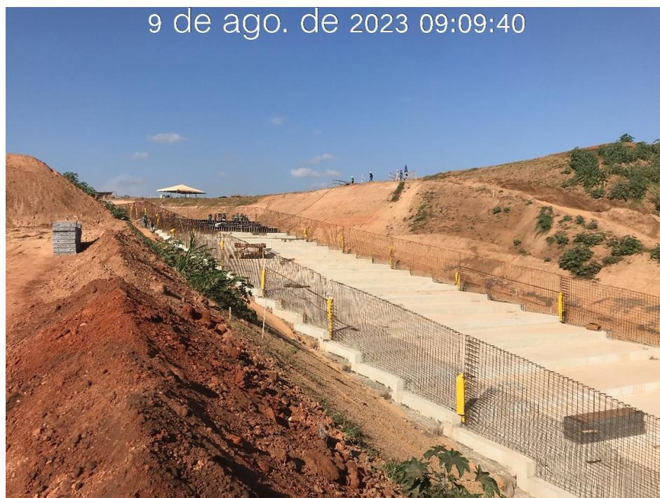
Figura 7.36 – Concretagem dos módulos do canal rápido, com vista para montante (09/08/2023).
