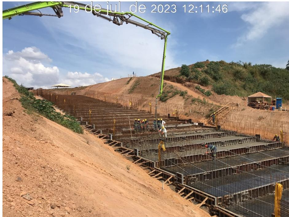
Figura 7.33 – Concretagem do módulo 39 do canal rápido (19/07/2023).
