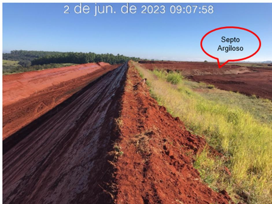
Figura 7.6 – Vista de jusante do canal periférico, com detalhe do septo argiloso (02/06/2023).
