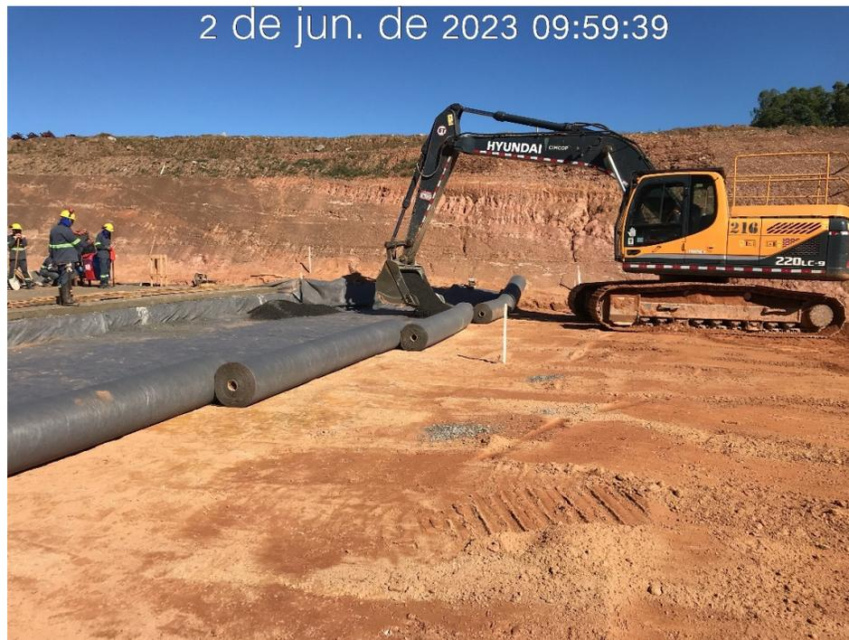
Figura 7.26 – Detalhe da escavação e aplicação da camada drenante, nos degraus do canal rápido (02/06/2023).
