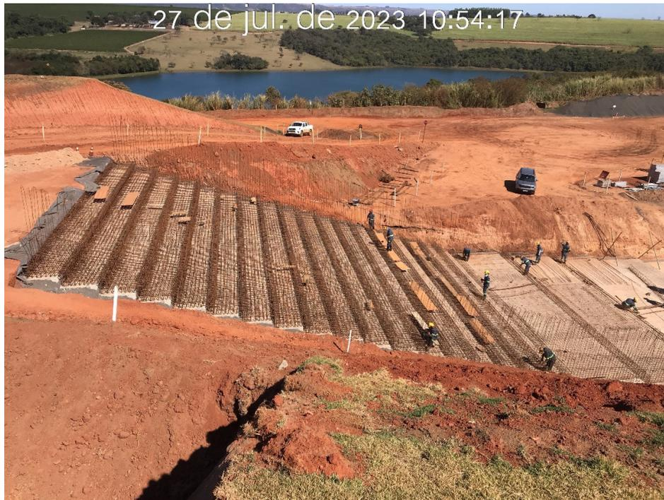
Figura 7.30 – Montagem da armação nos módulos 65 e 64 (27/07/2023).
