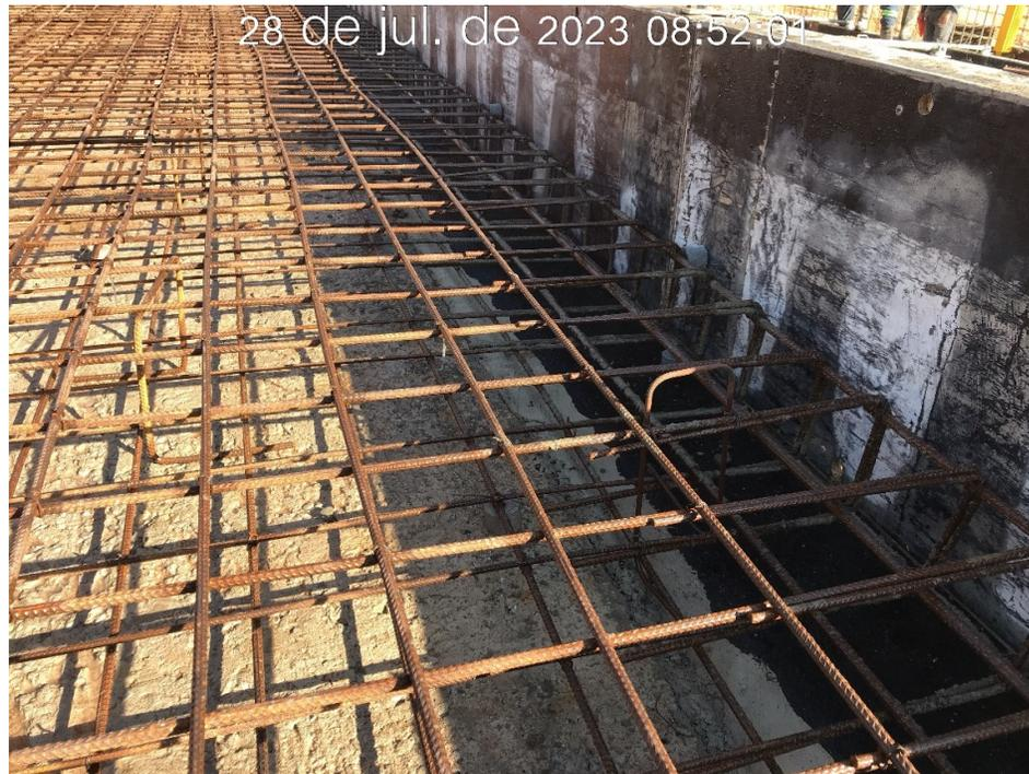
Figura 7.35 – Detalhe da pintura asfáltica aplicada na junta de dilatação entre os módulos (28/07/2023).
