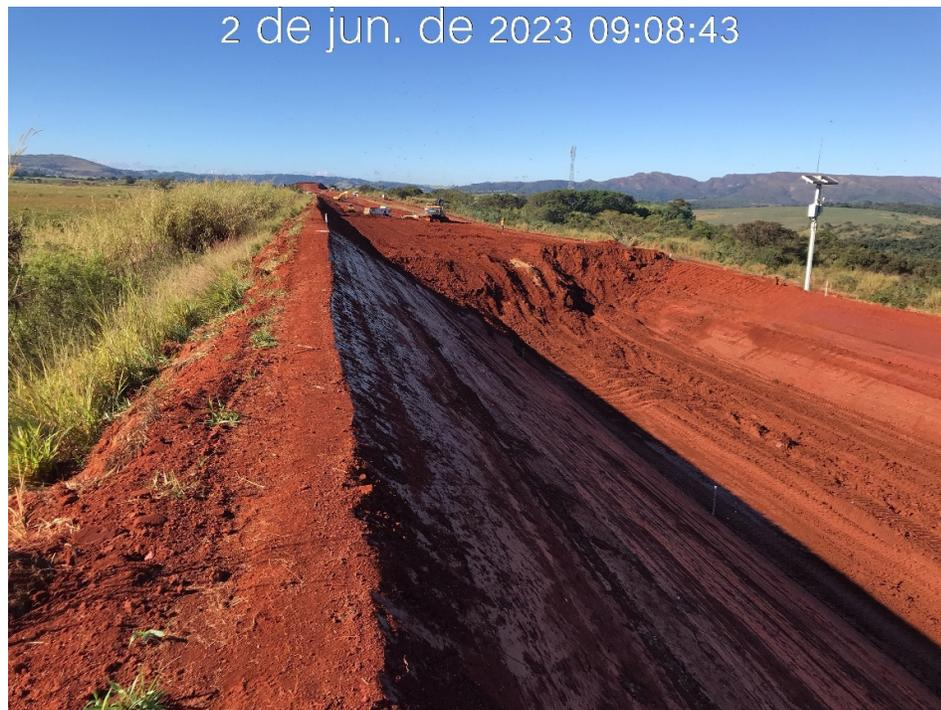
Figura 7.7 – Escavação do canal periférico na região da estaca 145 (02/06/2023).
