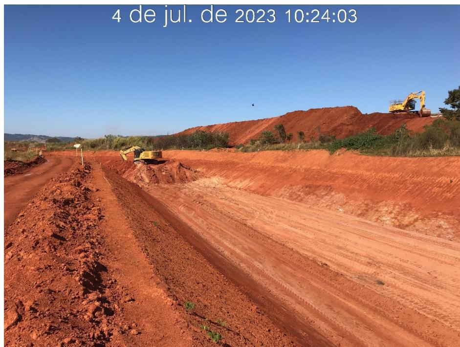
Figura 7.8 – Escavação do canal periférico na estaca 110, com vista para montante (04/07/2023).
