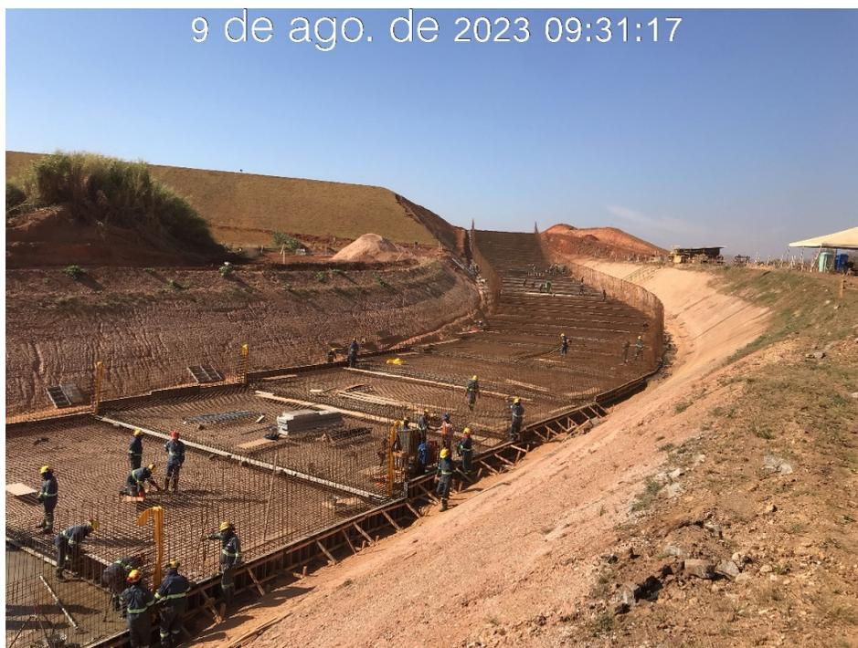
Figura 7.31 – Montagem da armação do piso e parede do canal do canal rápido, com vista para montante (09/08/2023).
