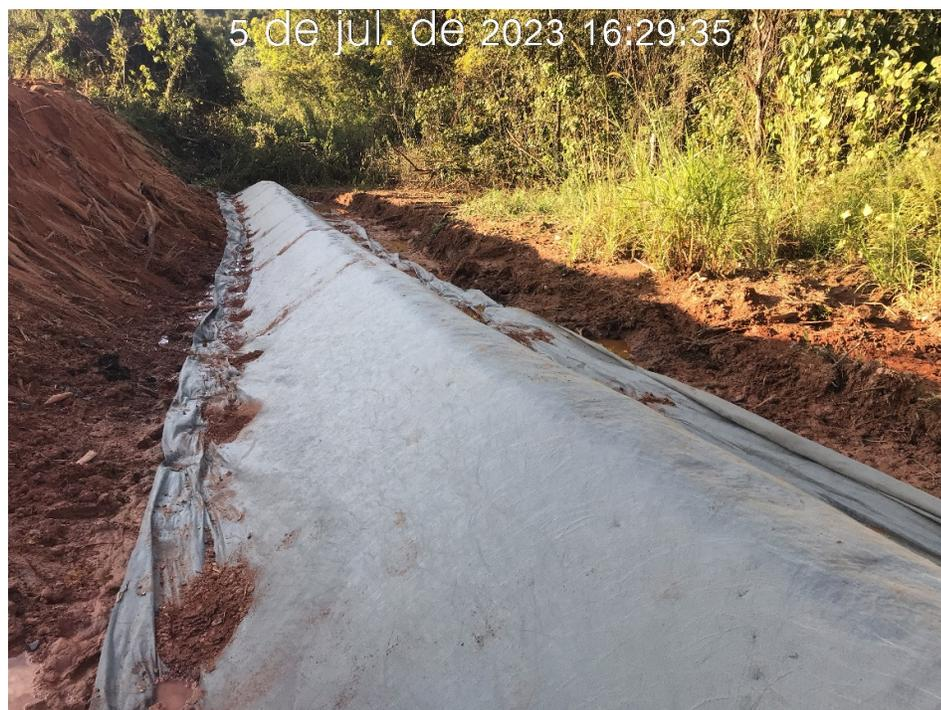
Figura 7.22 – Detalhe do dreno executado na região da estaca 194 (05/07/2023).
