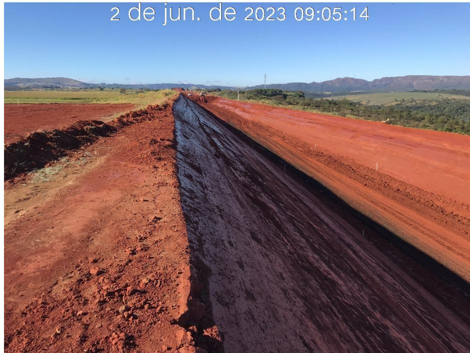
Figura 7.5 – Vista do dique argiloso da ombreira esquerda, após escavação do canal periférico (02/06/2023).
