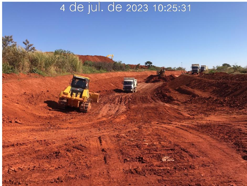
Figura 7.9 – Escavação do canal periférico na estaca 110, com vista para jusante (04/07/2023).
