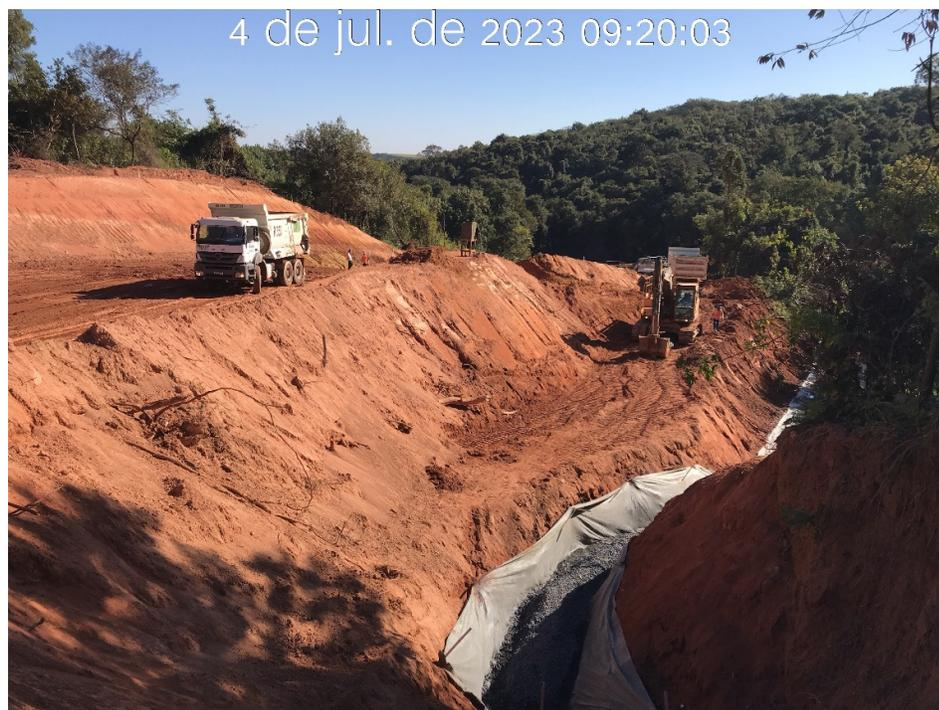
Figura 7.20 – Execução do dreno na região da estaca 194, com vista para jusante (04/07/20230).
