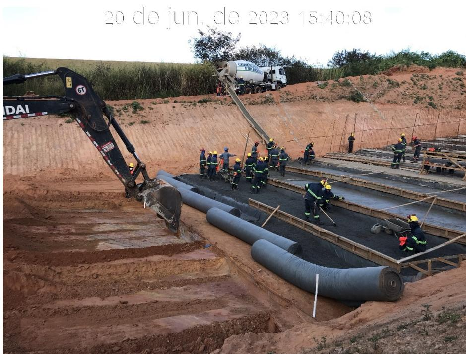
Figura 7.29 – Detalhe das etapas de execução dos degraus do canal rápido, escavação, execução da camada drenante e aplicação do concreto magro (20/06/2023).
