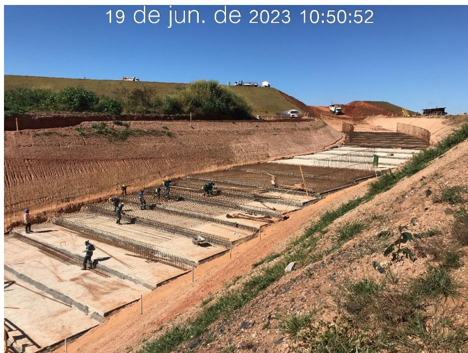
Figura 7.27 – Montagem da armação nos degraus do canal rápido, entre os módulos 57 e 49 (19/06/2023).
