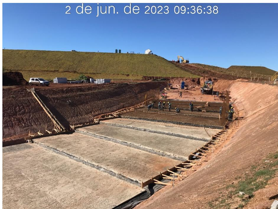
Figura 7.25 – Execução do concreto magro e montagem da armação dos módulos do canal rápido, com vista para montante (02/06/2023).
