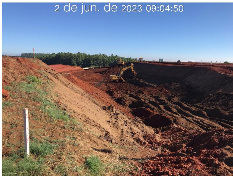
Figura 7.17 – Escavação do canal do reservatório na estaca 12, com vista para jusante (02/06/2023).
