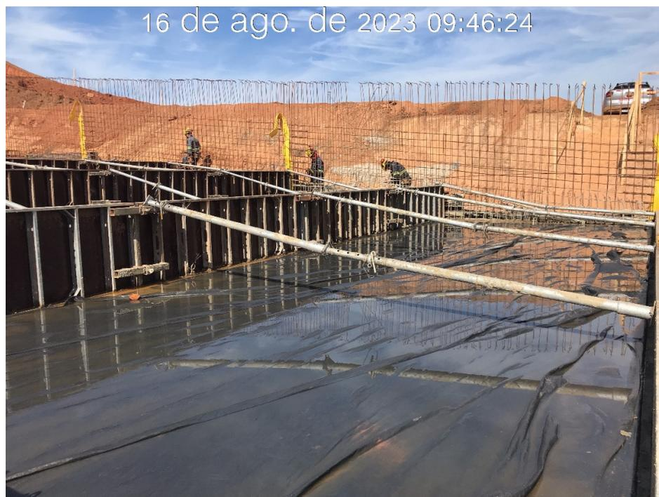
Figura 7.38 – Detalhe da cura do concreto, em conformidade com a especificação técnica (16/08/2023).
