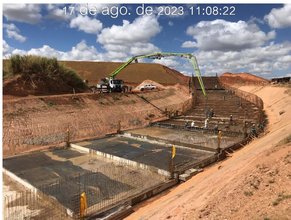
Figura 7.40 – Concretagem do módulo 53 do canal rápido, com vista para montante (17/08/20230).
