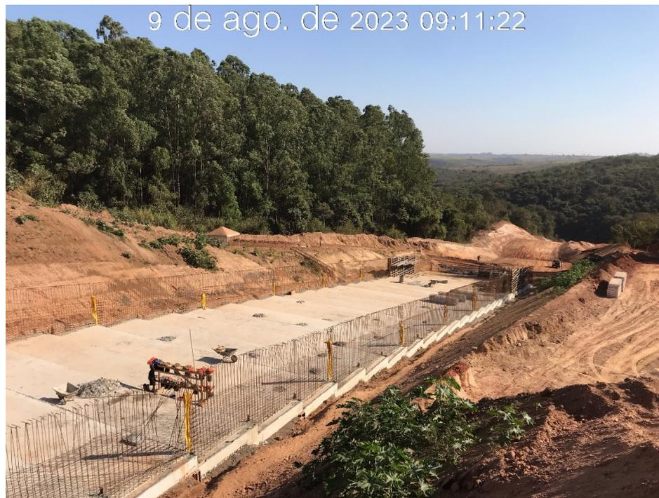
Figura 7.37 – Concretagem dos módulos do canal rápido, com vista para jusante (09/08/2023).
