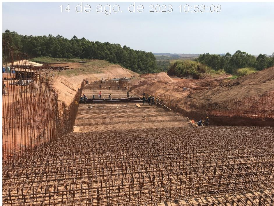
Figura 7.32 – Detalhe da armação do canal rápido, com vista para jusante (14/08/2023).
