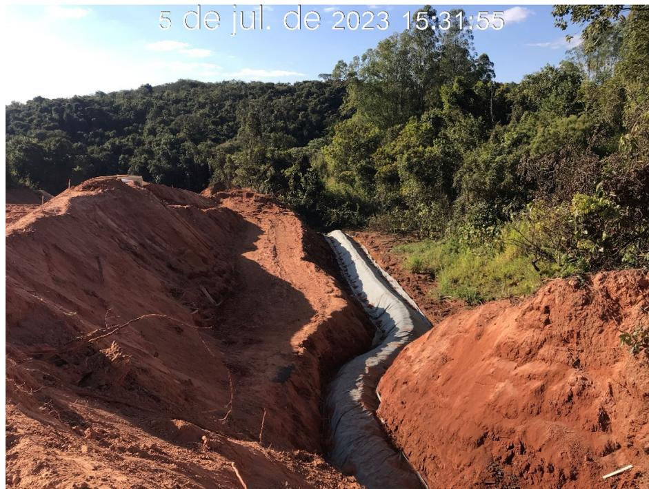
Figura 7.21 – Vista geral do dreno, na região da estaca 194 (05/07/20230).
