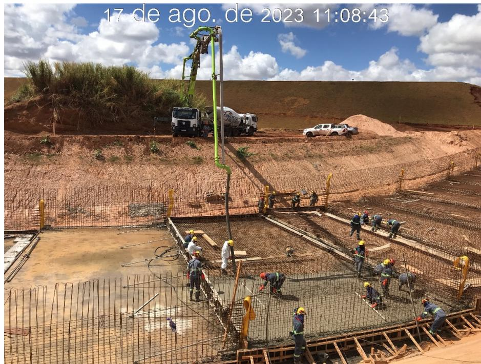
Figura 7.39 – Concretagem do módulo 53 do canal rápido (17/08/20230).
