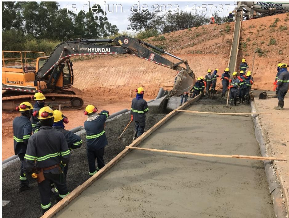
Figura 7.28 – Aplicação do concreto magro nos degraus do canal rápido, para permitir a montagem de forma e armação (15/06/2023).
