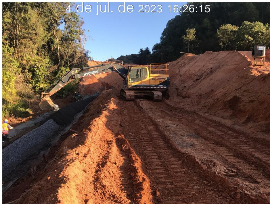
Figura 7.19 – Execução do dreno na região da estaca 194 (04/07/20230).
