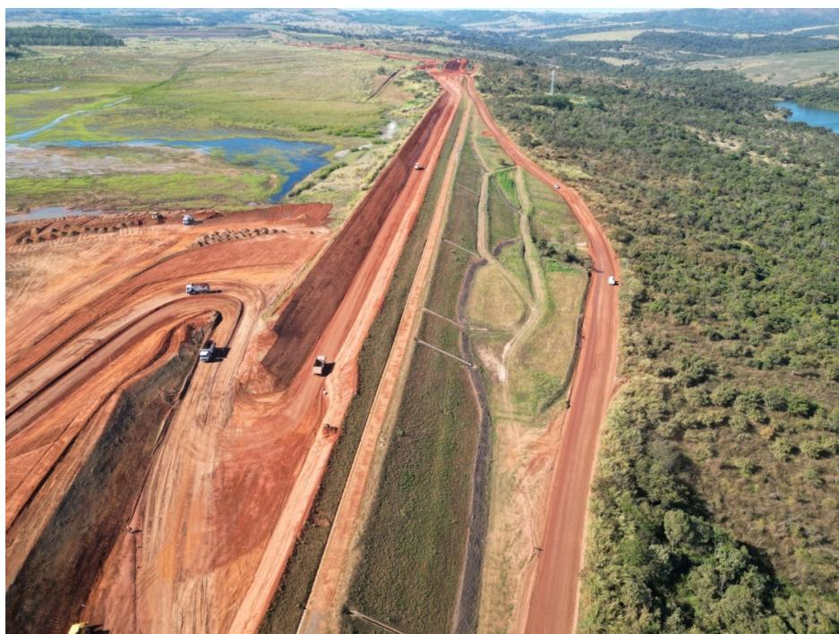
Figura 7.14 – Vista panorâmica do canal Periférico com detalhe da escavação no dique argiloso da ombreira esquerda (30/06/2023).
