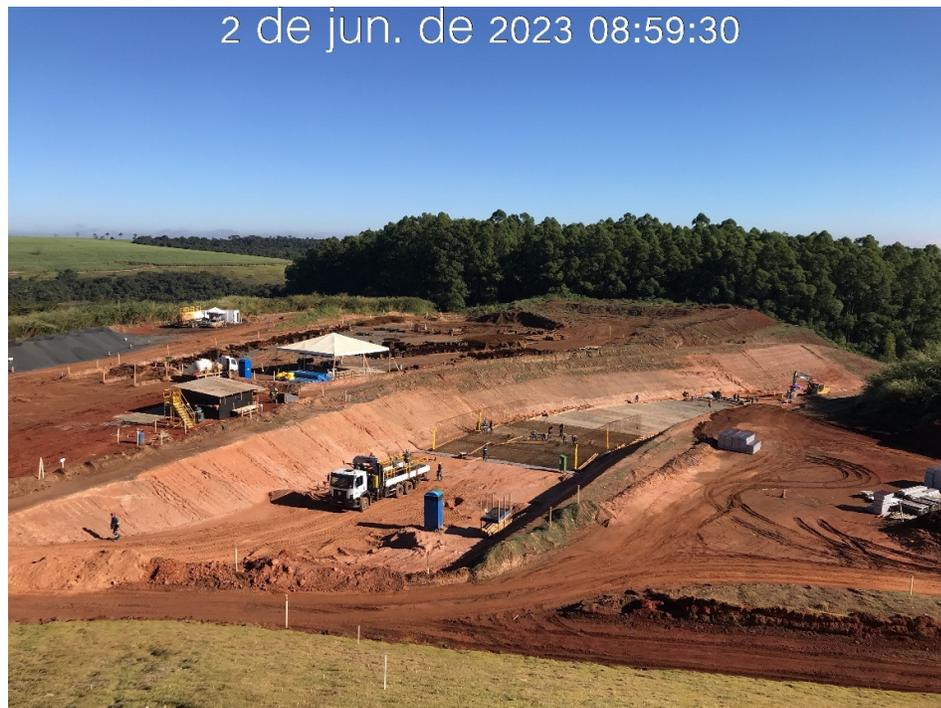
Figura 7.24 – Vista do canal rápido, com detalhe da execução da camada drenante e montagem da armação (02/06/2023).
