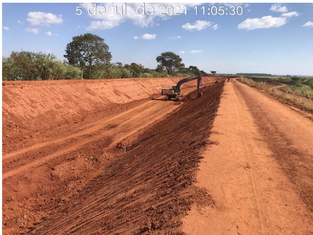
Figura 7.7 – Regularização do greide de escavação, entre as estacas 22 e 44 do canal periférico, com vista para jusante (05/07/2024).
