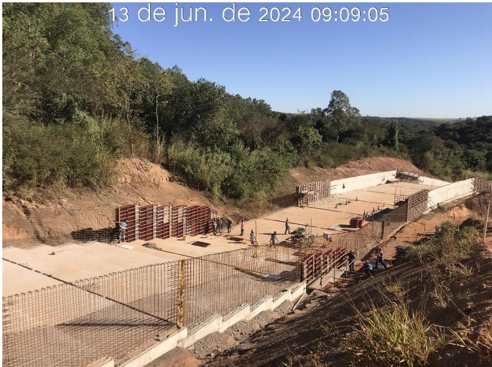
Figura 7.21 – Montagem das formas nas paredes dos módulos 23 e 26 do canal rápido, com vista para jusante (13/06/2024).
