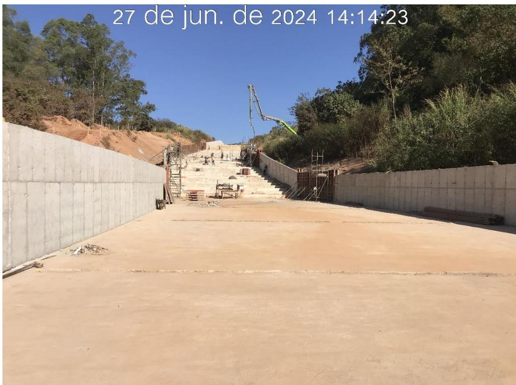
Figura 7.26 – Vista para montante do canal rápido, com detalhe da concretagem das paredes do módulo 28 (27/06/2024).
