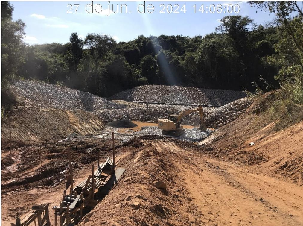
Figura 7.25 – Aplicação da camada drenante, no piso do módulo 07 do canal rápido (27/06/2024).
