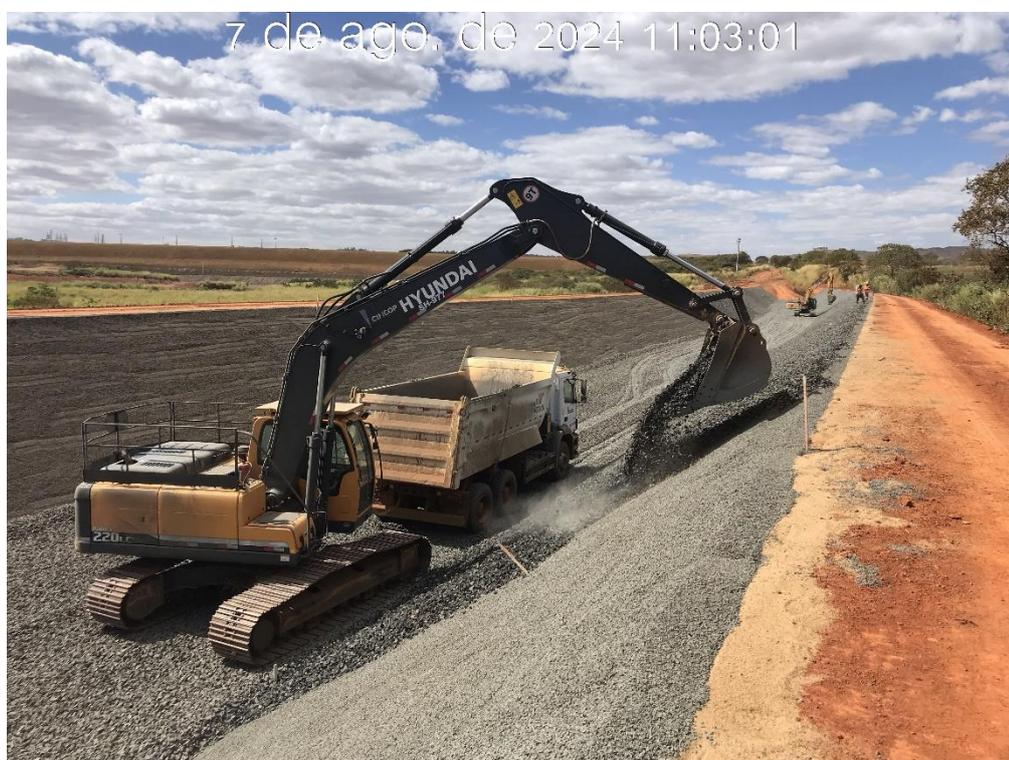
Figura 7.11 – Detalhe da aplicação da transição 3, entre as estacas 22 e 44 do canal periférico, com vista para montante (07/08/2024).
