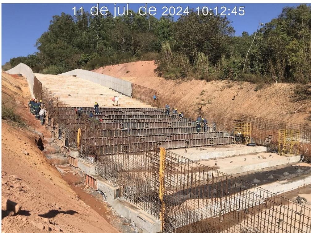
Figura 7.28 – Montagem das formas no piso do módulo 14 do canal rápido, com vista para montante (11/07/2024).
