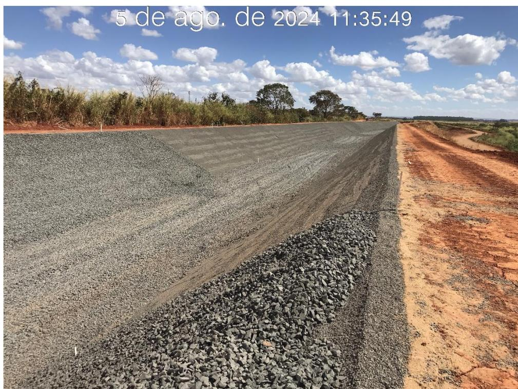
Figura 7.10 – Aplicação da transição 3, entre as estacas 22 e 44 do canal periférico, com vista para jusante (05/08/2024).
