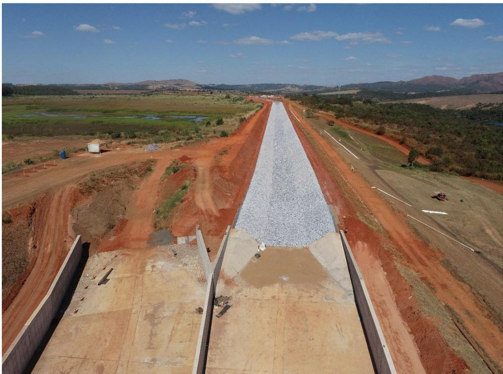
Figura 7.14 – Vista panorâmica do canal periférico, com detalhe da região de transição com o canal rápido (18/07/2024).
