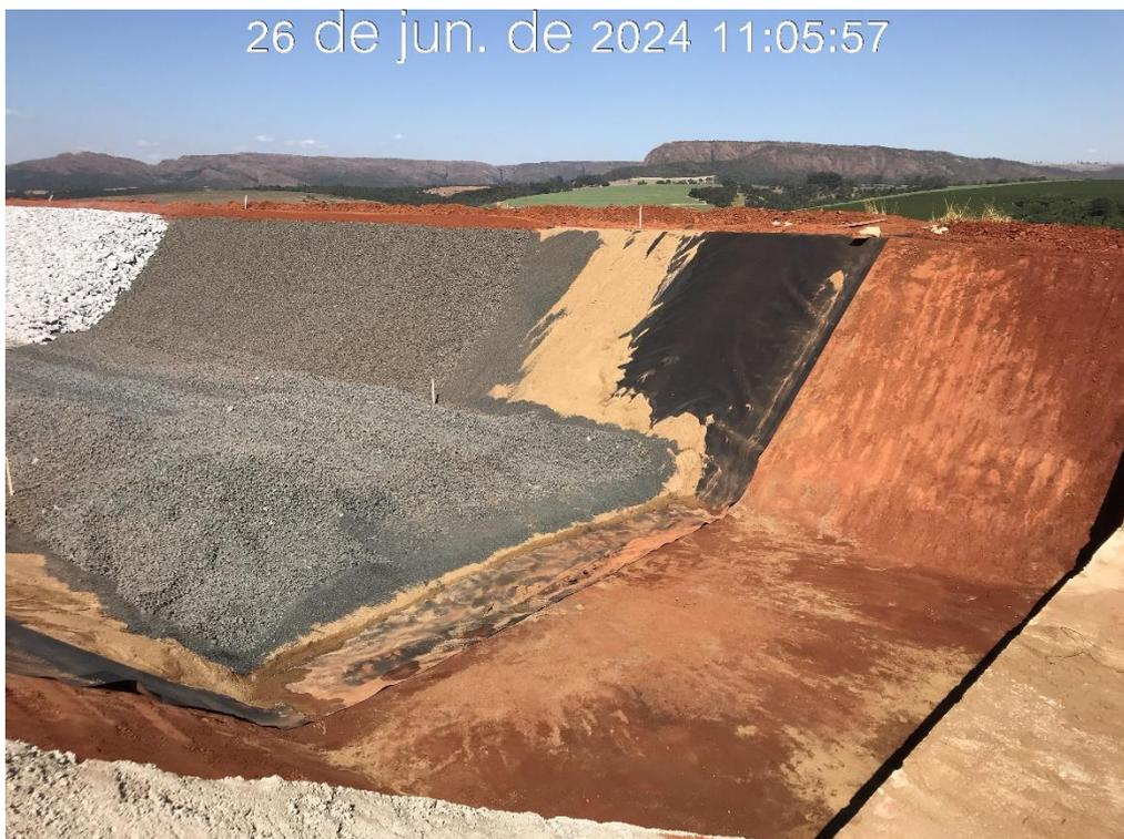
Figura 7.4 – Regularização do greide de escavação, na região do encaixe do canal periférico com o canal rápido (26/06/2024).
