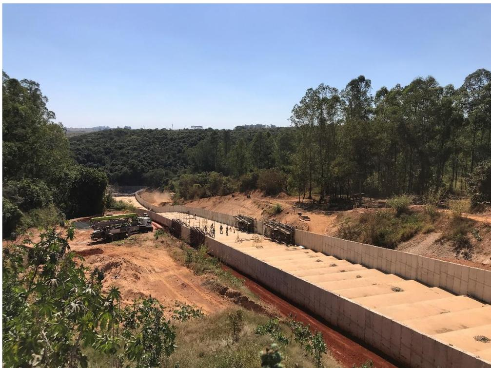
Figura 7.33 – Concretagem das paredes do módulo 37 do canal rápido, com vista para jusante (22/07/2024).
