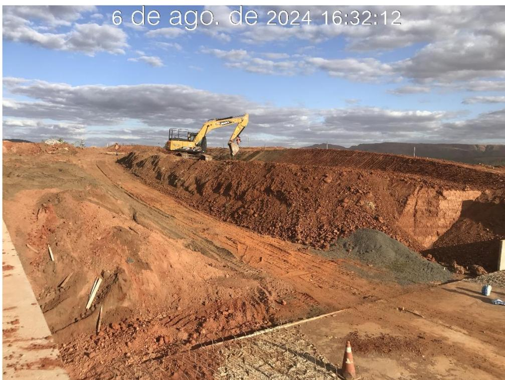
Figura 7.17 – Escavação do canal do reservatório, entre as estacas 01 e 04, com vista para montante (06/08/2024).
