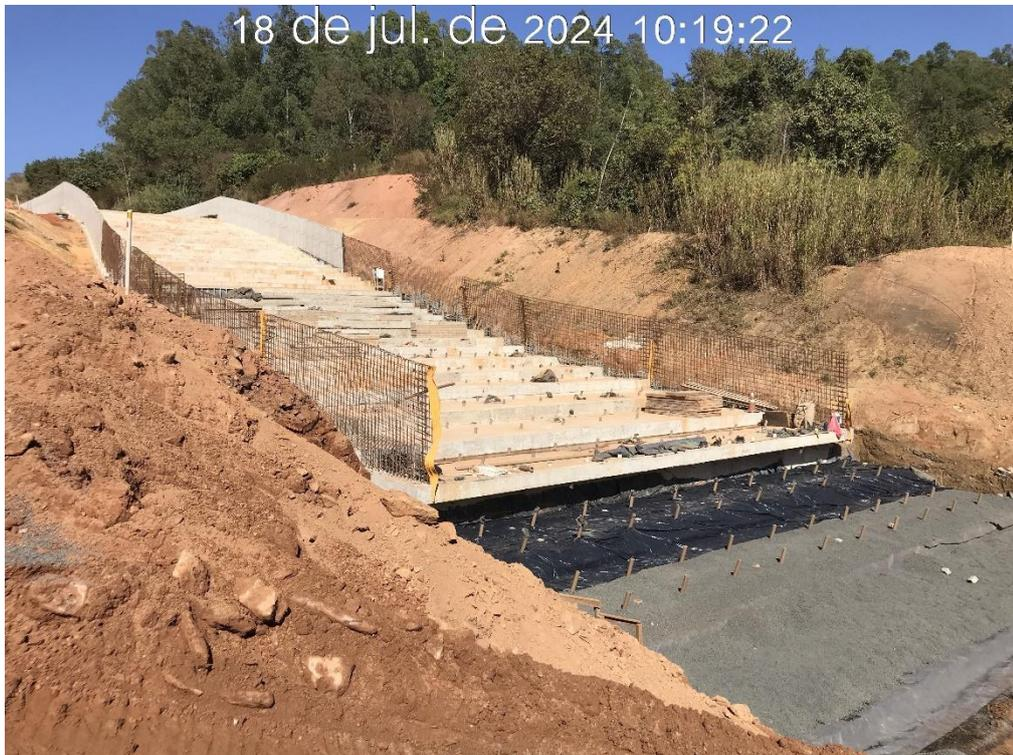
Figura 7.31 – Aplicação do dreno de fundo no piso do módulo 10 do cana rápido, com vista para montante (18/07/2024).
