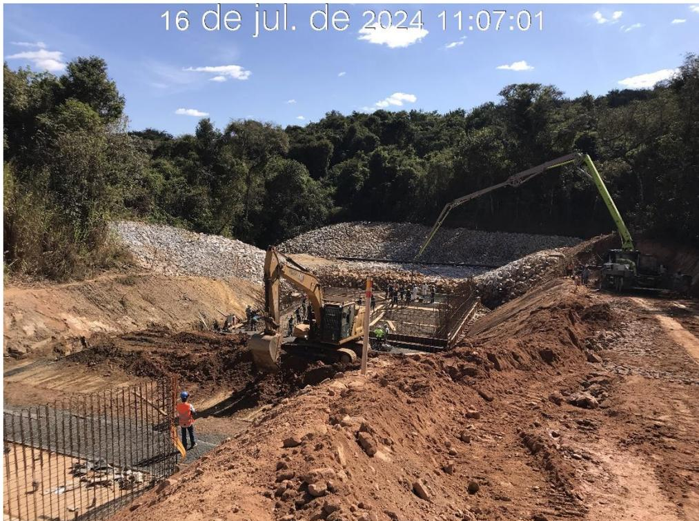
Figura 7.29 – Concretagem da primeira junta do piso do módulo 07 do canal rápido, com vista para jusante (16/07/2024).
