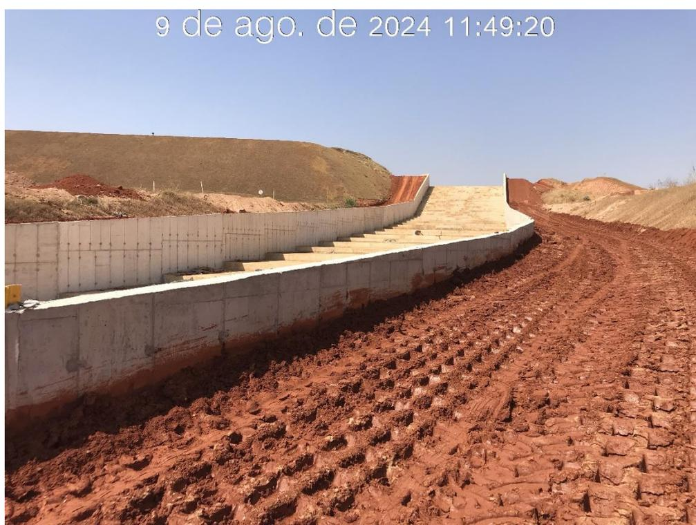
Figura 7.34 – Execução do aterro adjacente a parede do lado esquerdo do canal rápido, com vista para montante (09/08/2024).
