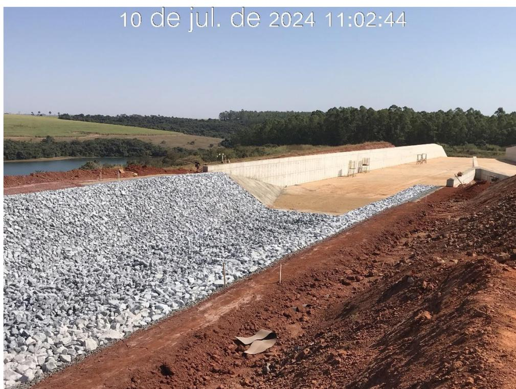
Figura 7.6 – Execução das transições 1, 2, 3 e da camada de proteção (enrocamento), na região do encaixe do canal periférico com o canal rápido (18/06/2024).
