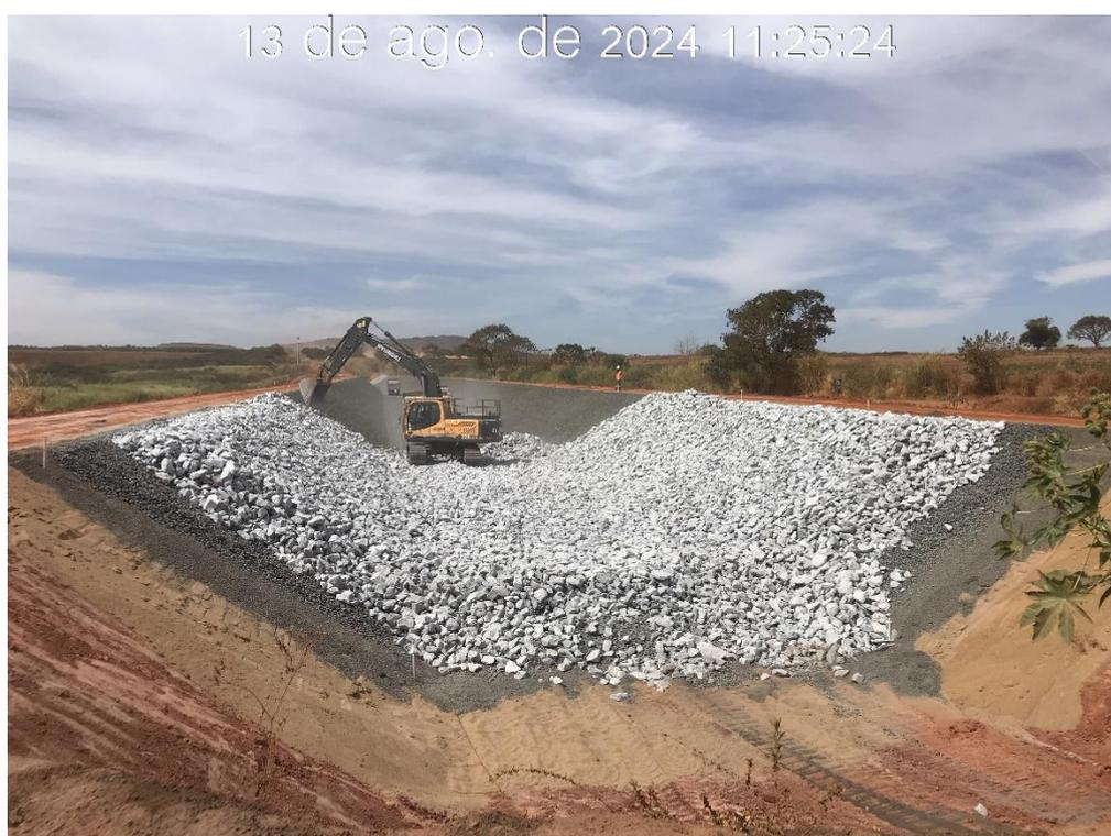
Figura 7.12 – Aplicação da camada de proteção (enrocamento), entre as estacas 22 e 44 do canal periférico, com vista para montante (13/08/2024).
