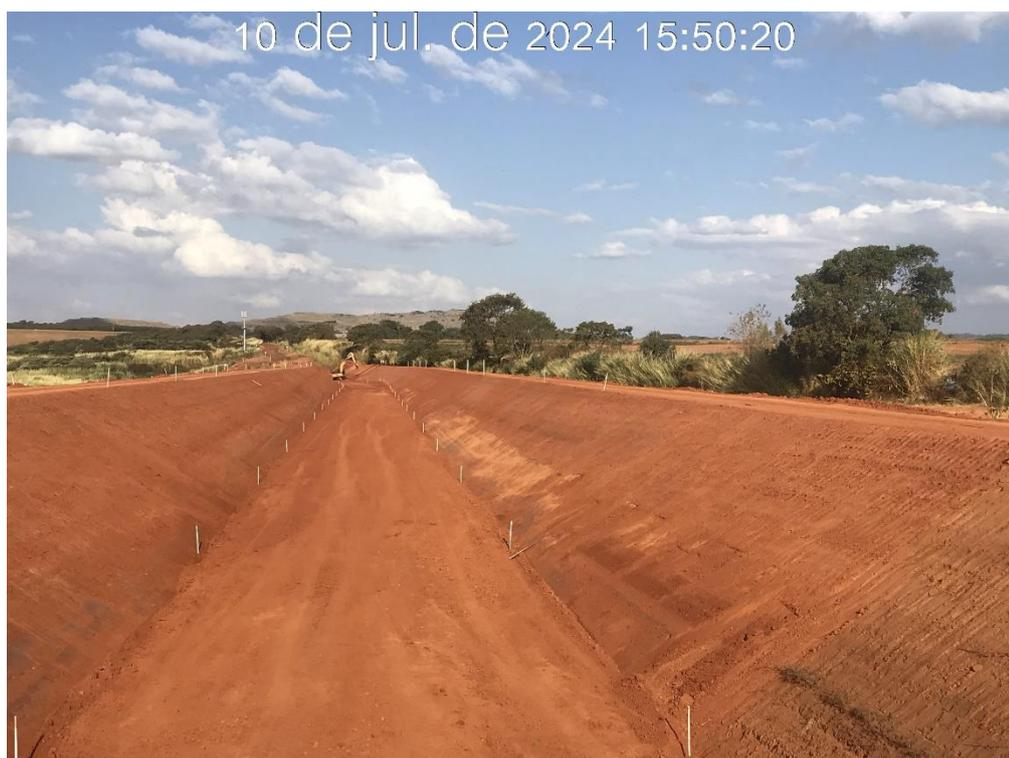
Figura 7.8 – Regularização do greide de escavação, entre as estacas 22 e 44 do canal periférico, com vista para montante (10/07/2024).
