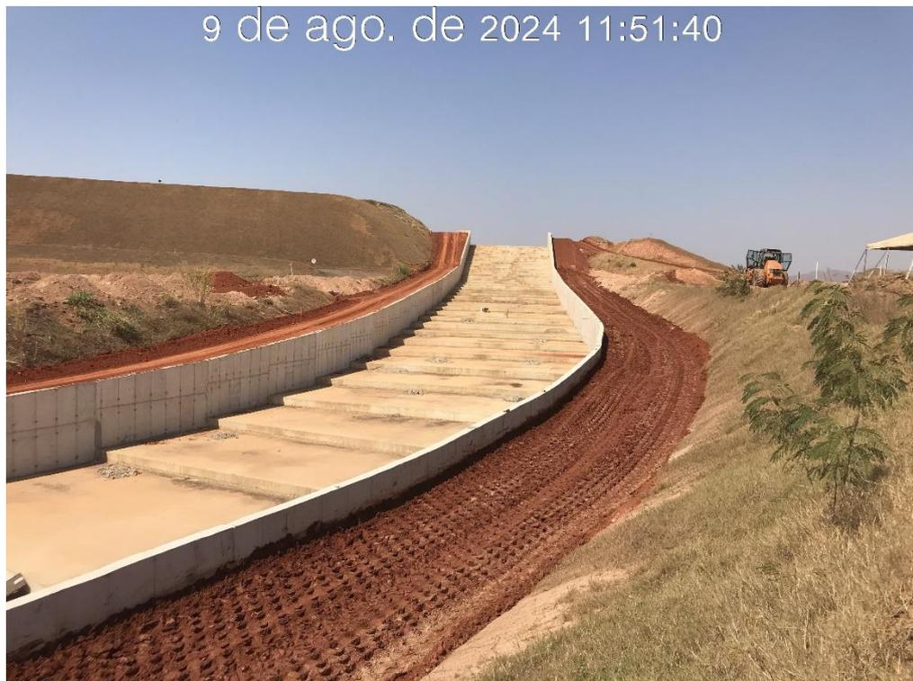
Figura 7.35 – Vista para montante do canal rápido, com detalhe da execução do reaterro das paredes (09/08/2024).
