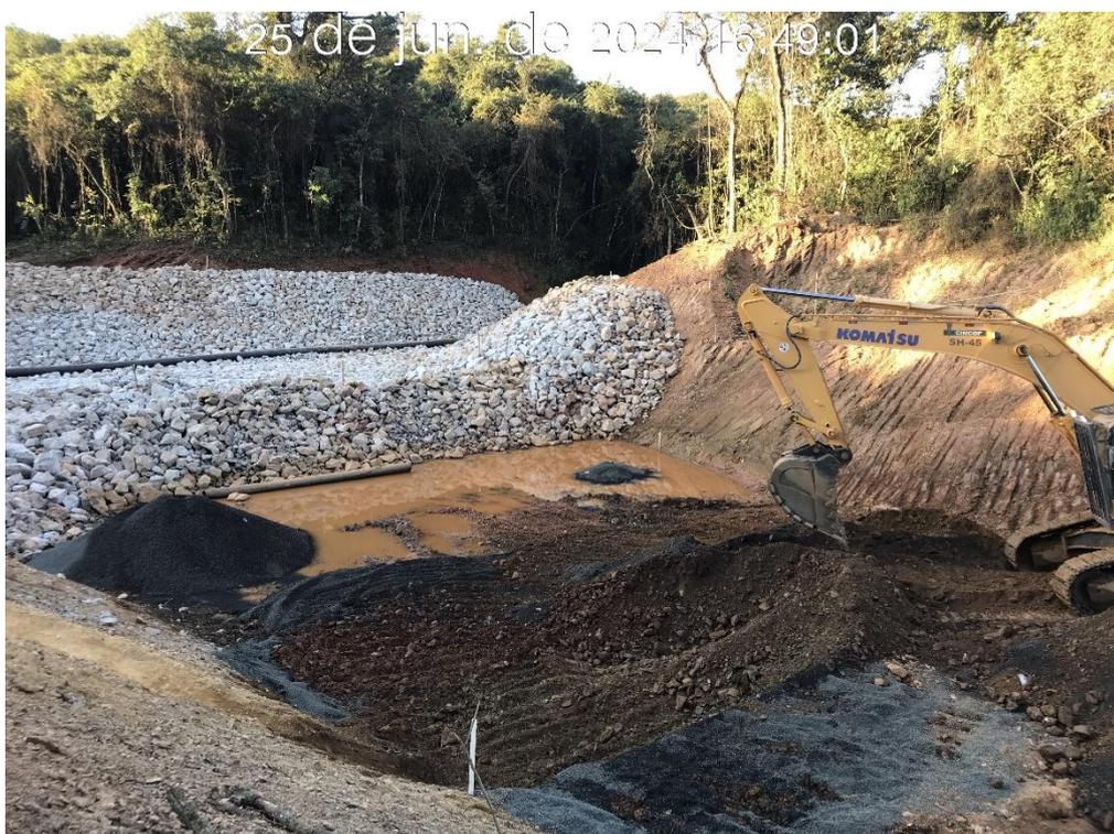
Figura 7.24 – Escavação do módulo 07 do canal rápido, com vista para jusante (25/06/2024).
