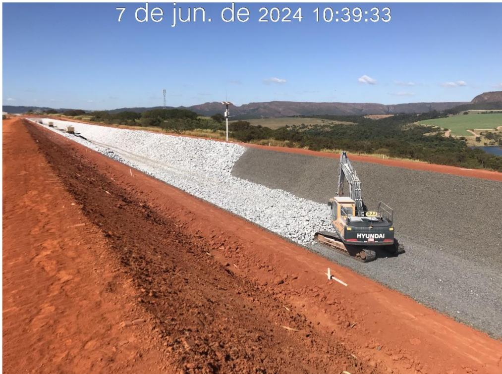
Figura 7.3 – Aplicação da camada de proteção (enrocamento), entre as estacas 135 e 170 do canal periférico (07/06/2024).
