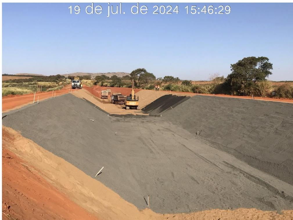
Figura 7.9 – Aplicação das transições 1 e 2, entre as estacas 22 e 44 do canal periférico, com vista para montante (19/07/2024).
