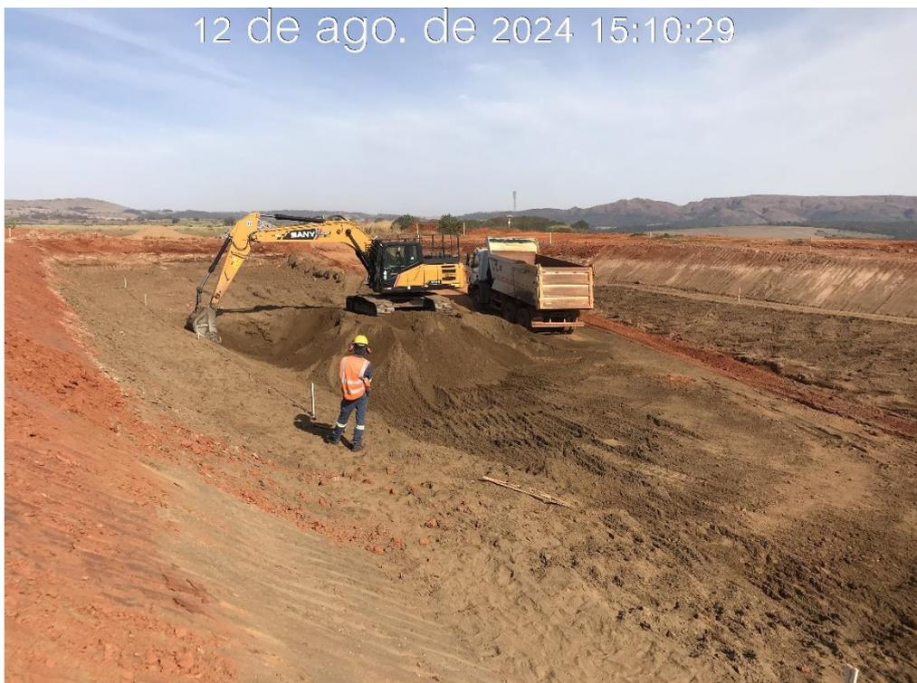
Figura 7.19 – Detalhe da escavação do canal do reservatório, na região da estaca 04 (12/08/2024).
