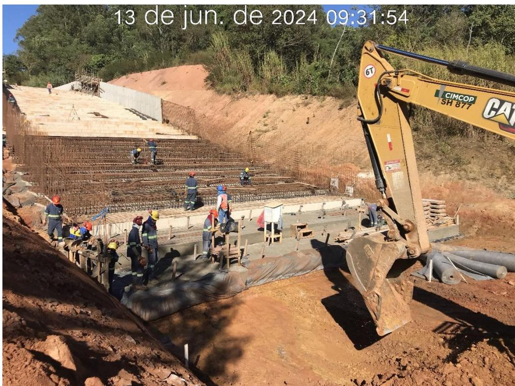
Figura 7.23 – Escavação do módulo 11 do canal rápido (13/06/2024).
