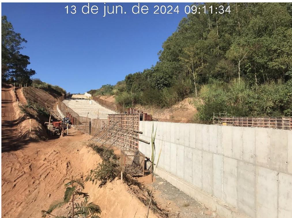
Figura 7.22 – Montagem das formas nas paredes dos módulos 23 e 26 do canal rápido, com vista para montante (13/06/2024).
