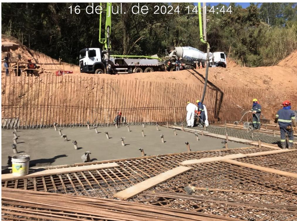
Figura 7.30 – Concretagem da primeira junta do piso do módulo 07 do canal rápido, com detalhe da instalação dos drenos de fundo (barbacãs) (16/07/2024)
