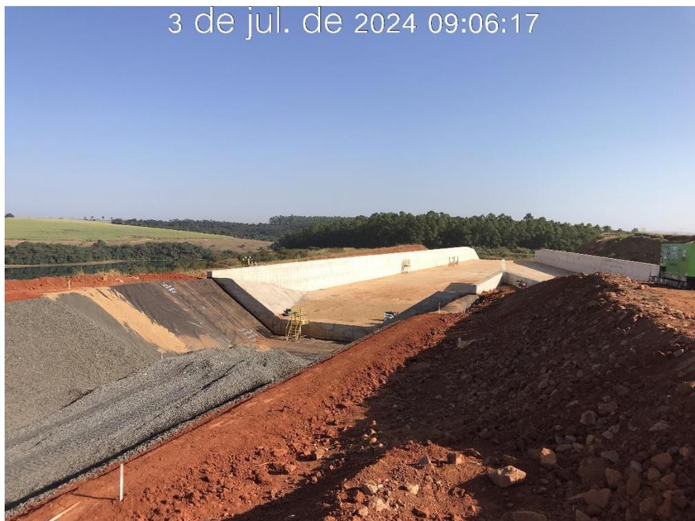
Figura 7.5 – Aplicação da geomembrana no encaixe do canal periférico com o canal rápido (03/07/2024).
