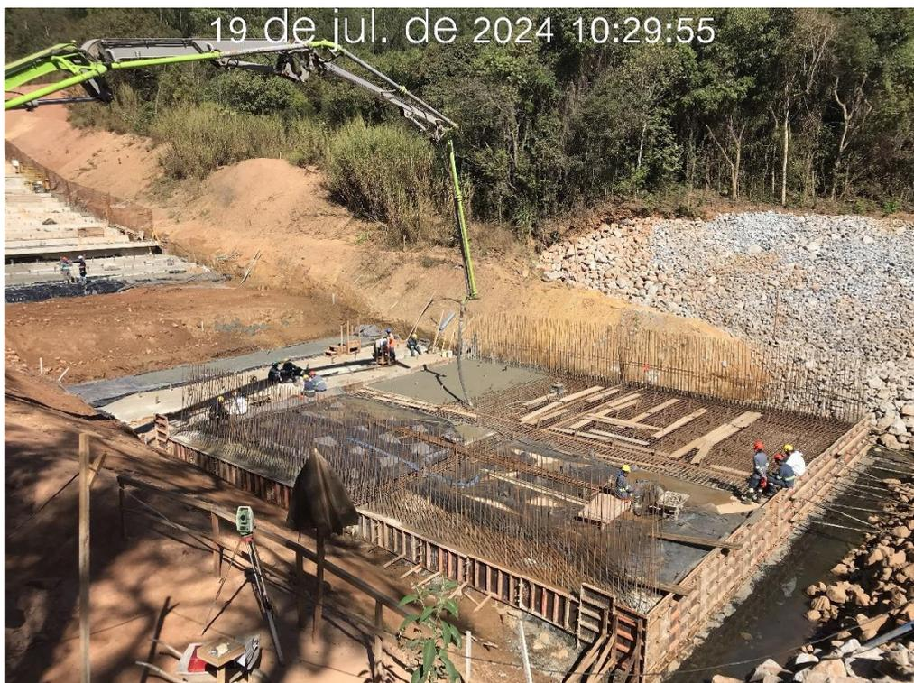
Figura 7.32 – Concretagem da segunda junta do piso do módulo 07 do canal rápido (19/07/2024).
