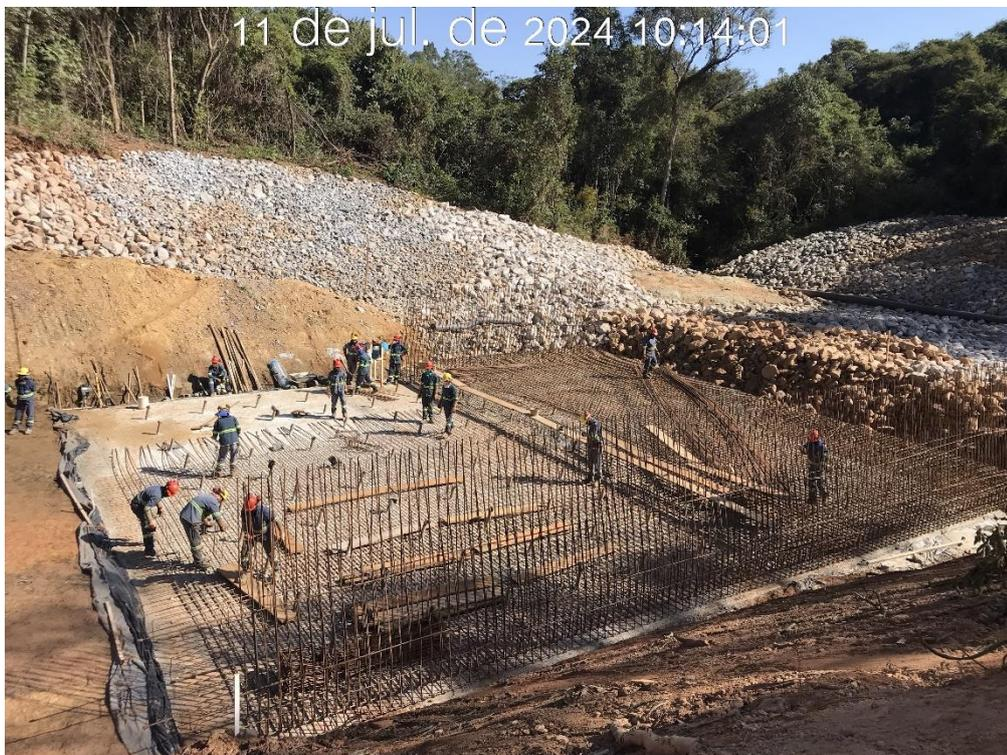
Figura 7.27 – Montagem da armação no módulo 07 do canal rápido (11/07/2024).
