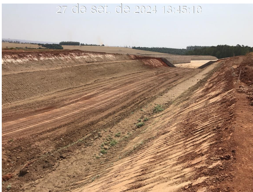
Figura 8.30 – Vista para jusante do canal do reservatório, após regularização (27/09/2024).
