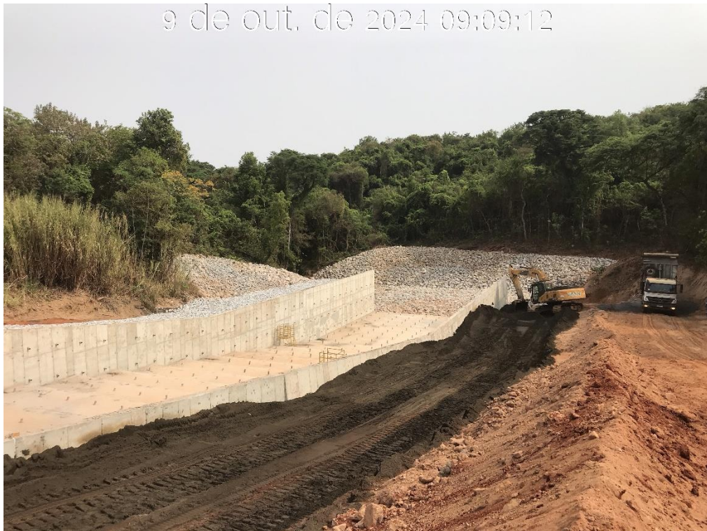
Figura 8.38 – Execução do aterro adjacente às paredes do canal rápido em magnetita, entre os módulos 07 e 12, com vista para jusante (09/10/2024).
