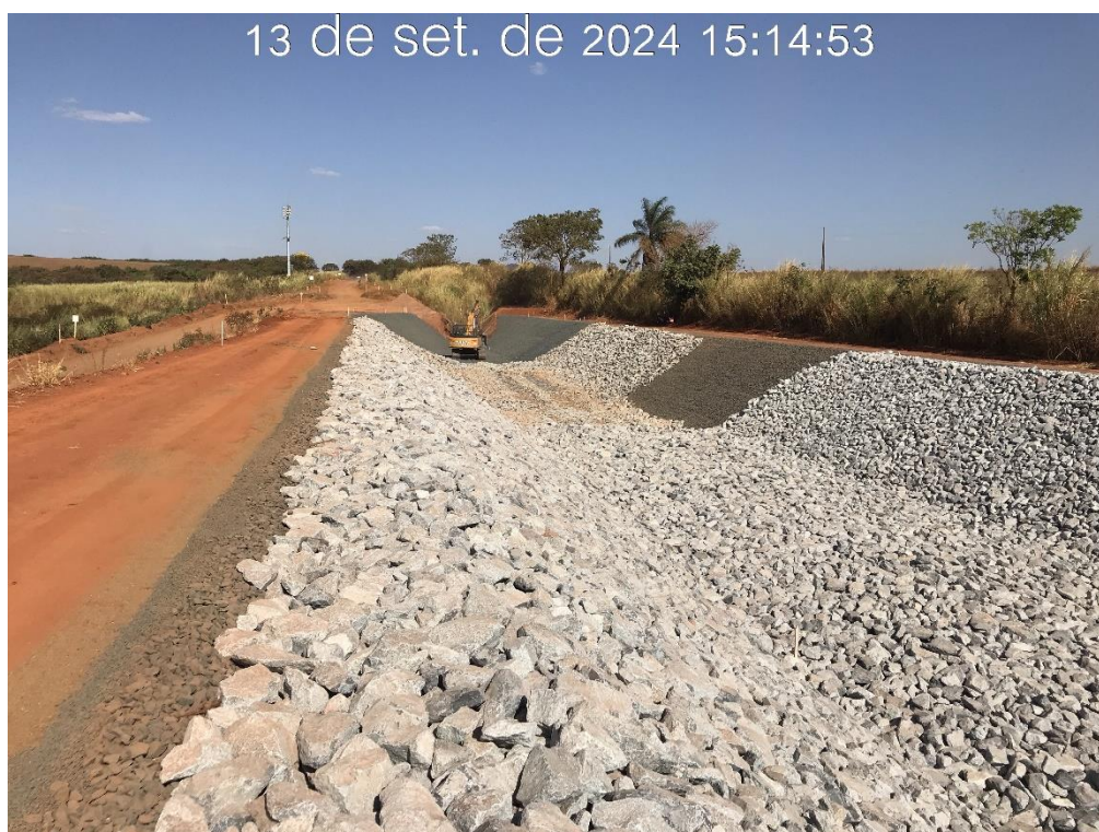
Figura 8.7 – Vista para montante do canal periférico (13/09/2024).
