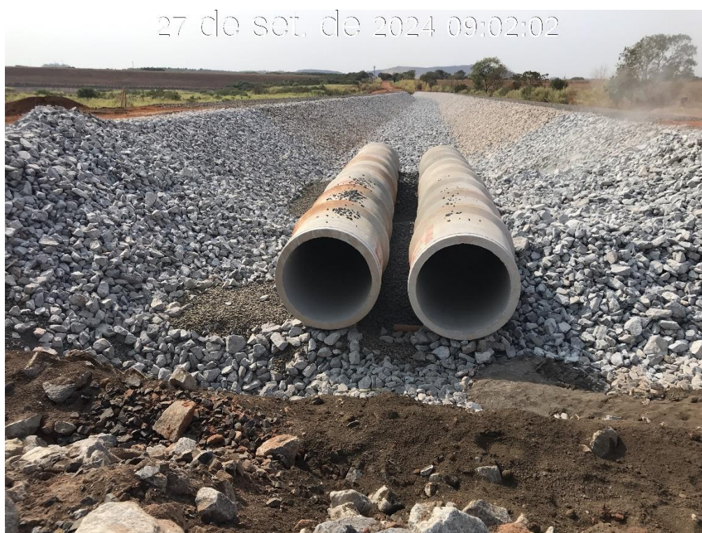
Figura 8.20 – Execução da transposição do canal periférico, na região da estaca 45, com vista para montante (27/09/2024).
