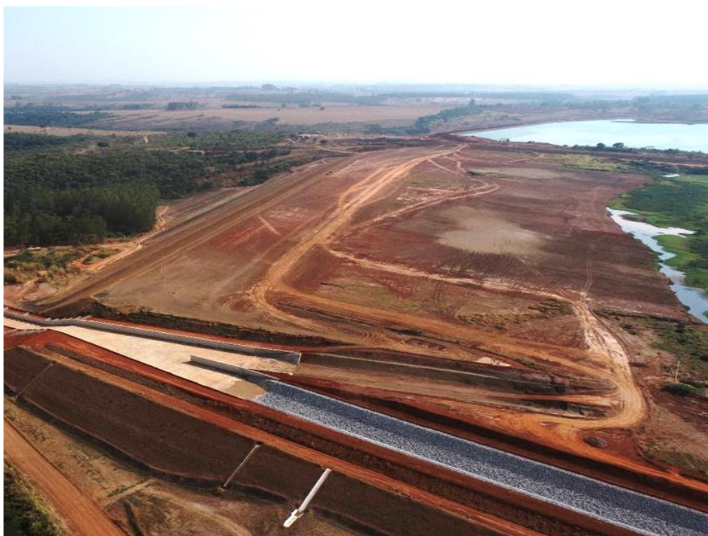
Figura 8.49 – Vista panorâmica da praia da Barragem B5, após regularização da retomada do rejeito (25/10/2024).
