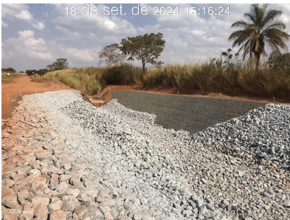
Figura 8.9 – Aplicação da camada de proteção (enrocamento), entre as estacas 22 e 23 do canal periférico, com vista para montante (18/09/2024).
