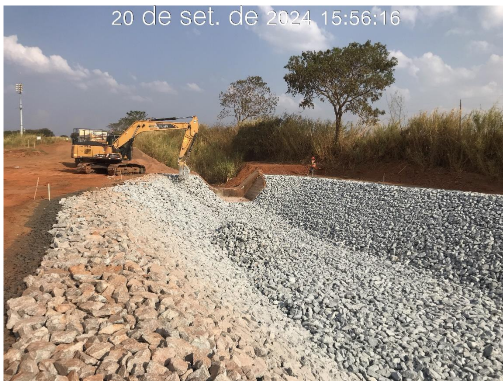
Figura 8.12 – Acabamento da camada de proteção no encaixe com o canal existente (20/09/2024).
