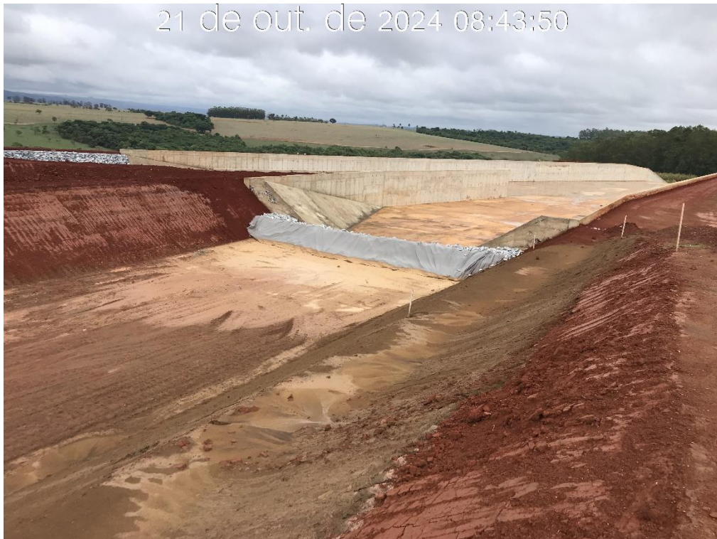
Figura 8.31 – Execução de leira para contenção de sedimento durante período chuvoso (21/10/2024).
