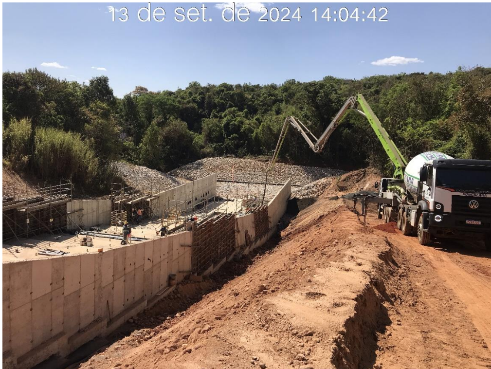
Figura 8.36 – Concretagem das paredes dos módulos 09 e 11 do canal rápido, com vista para jusante (13/09/2024).
