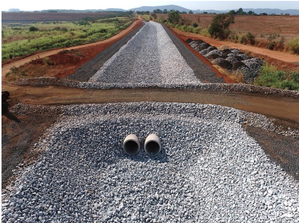
Figura 8.22 – Detalhe da transposição do canal periférico, executada na região da estaca 45, com vista para montante (25/10/2024).
