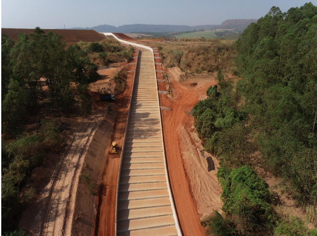
Figura 8.42 – Vista panorâmica para montante do canal rápido, entre os módulos 27 e 65 (25/10/2024).
