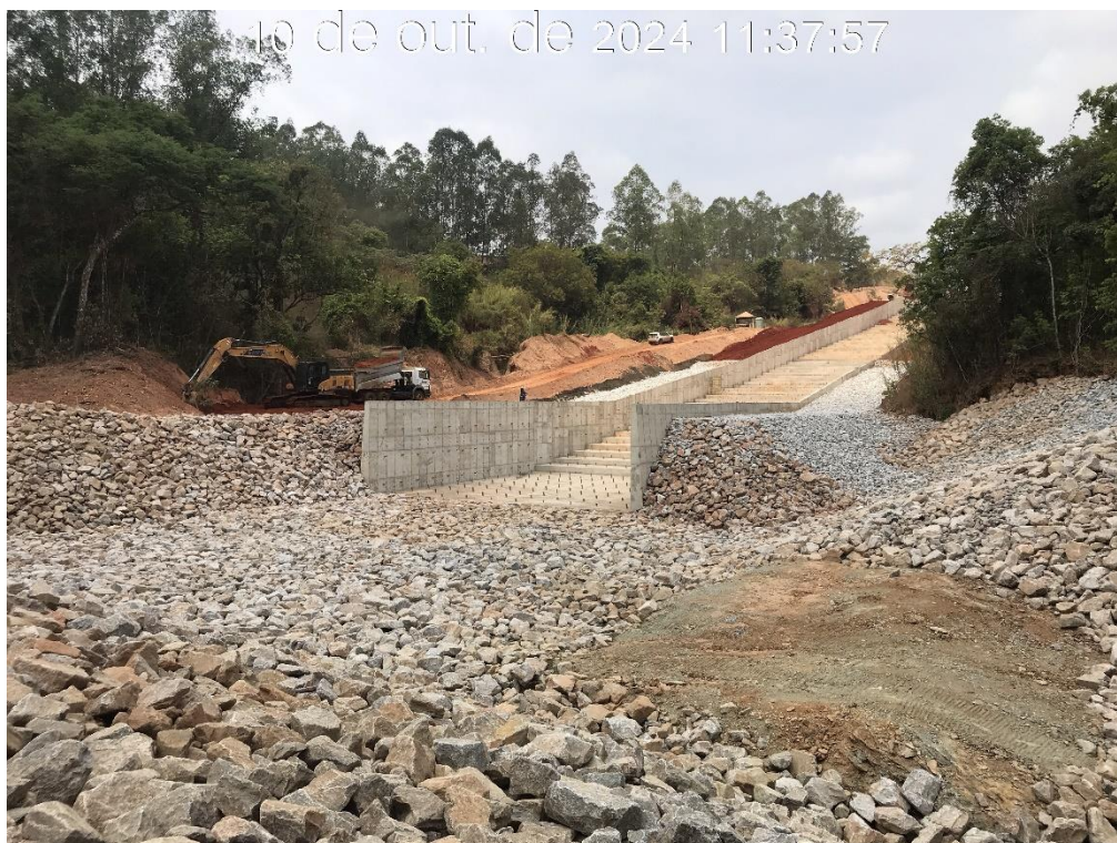
Figura 8.40 – Região da bacia de dissipação, com vista para montante (10/10/2024).
