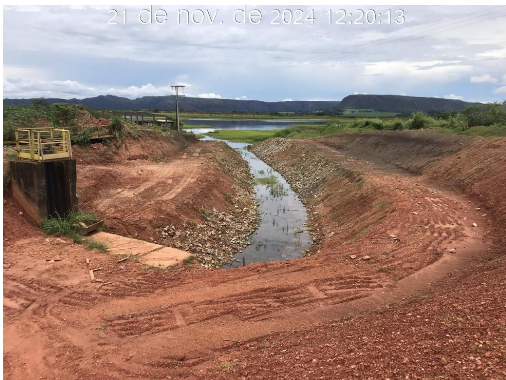
Figura 8.48 – Limpeza do canal de aproximação da Barragem B5 (21/11/2024).
