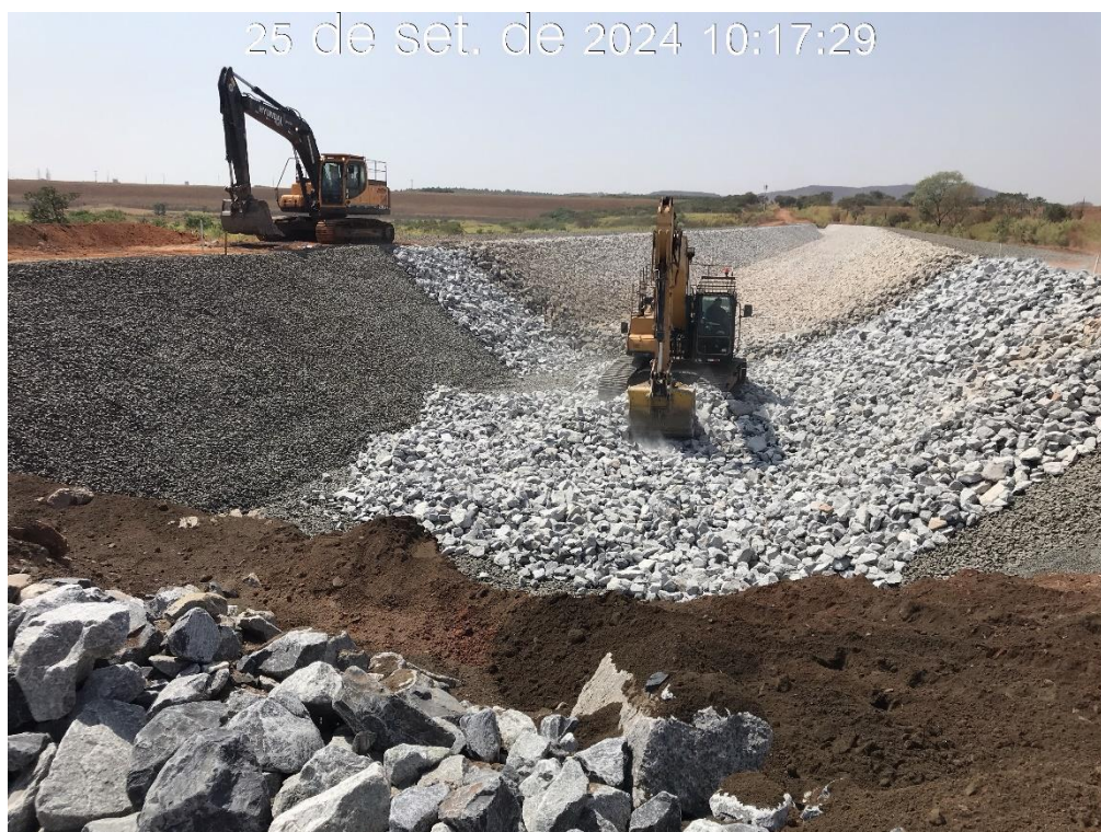
Figura 8.18 – Execução da transposição do canal periférico, na região da estaca 45 (25/09/2024).
