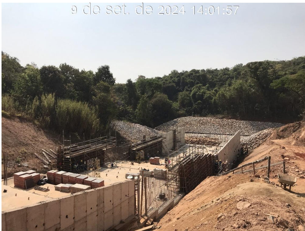
Figura 8.34 – Montagem das formas nos módulos 09 e 10 do canal rápido, com vista para jusante (09/09/2024).
