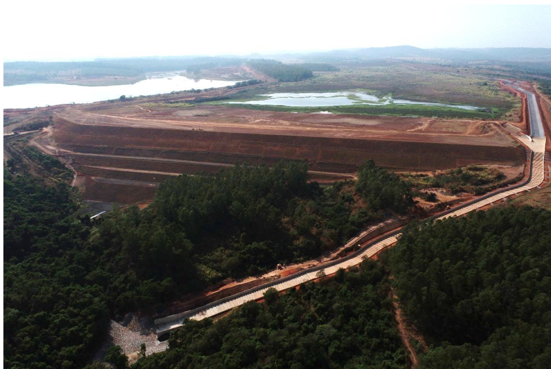
Figura 8.45 – Vista panorâmica para montante canal extravasor, implantação da 2ª fase (25/10/2024).
