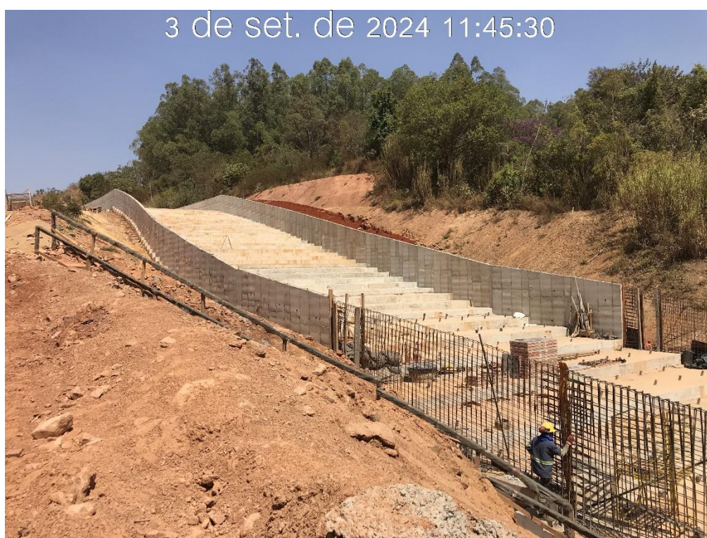
Figura 8.33 – Montagem da armadura no módulo 11 do canal rápido, com vista para montante (03/09/2024).
