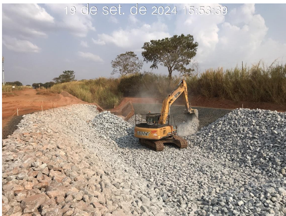
Figura 8.11 - – Aplicação da camada de proteção (enrocamento), entre as estacas 22 e 23 do canal periférico, com vista para montante (19/09/2024).
