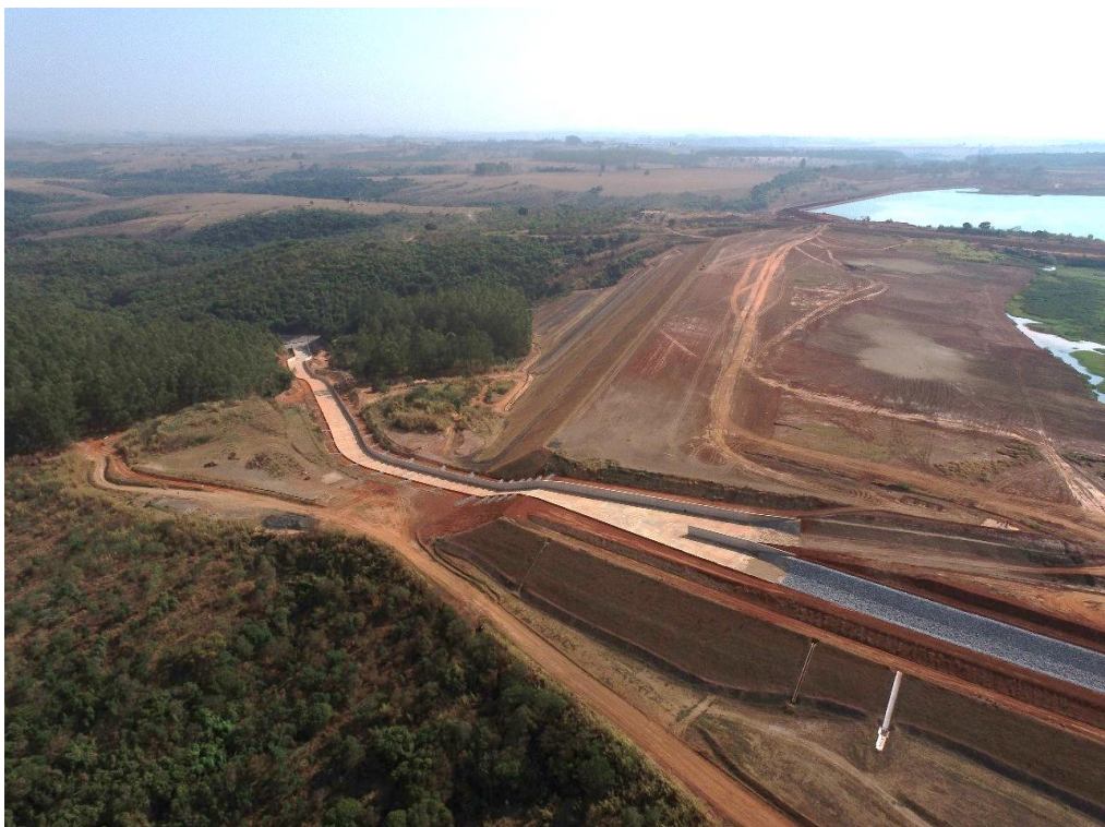
Figura 8.43 – Vista panorâmica para jusante do canal rápido (25/10/2024).
