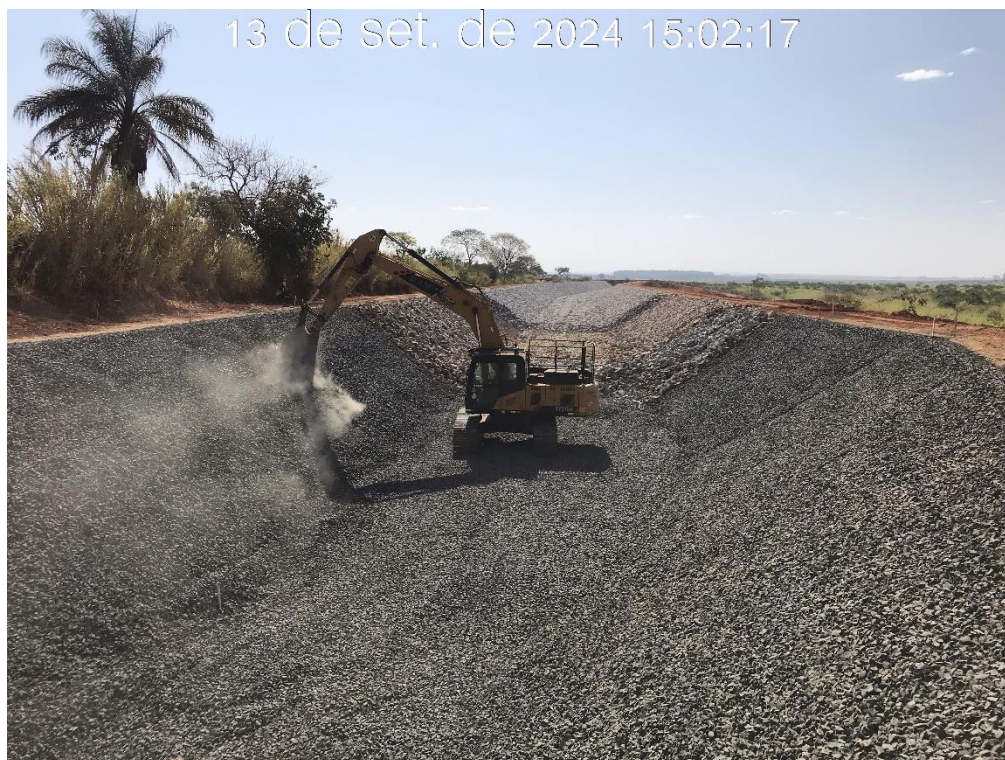
Figura 8.6 – Aplicação da transição 2 (brita 0), entre as estacas 22 e 23 do canal periférico, com vista para jusante (13/09/2024).
