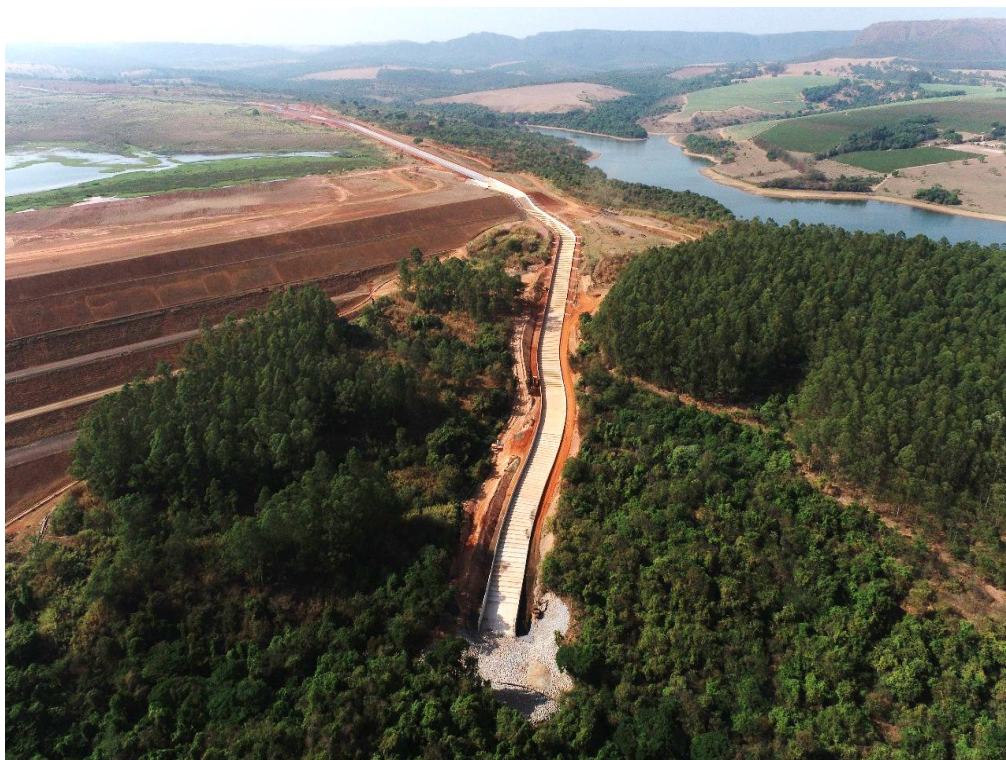
Figura 8.44 – Vista panorâmica para montante do canal rápido (25/10/2024).
