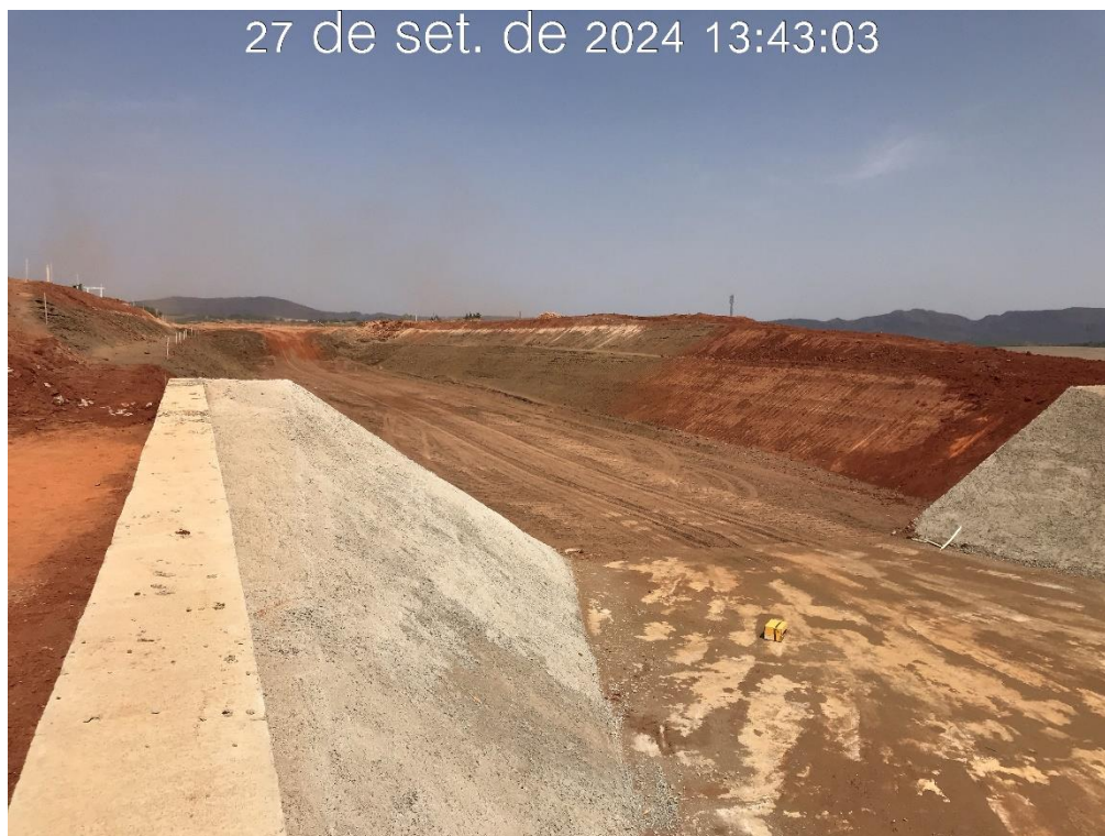
Figura 8.29 – Regularização do canal do reservatório, para a condição normal, com vista para montante (27/09/2024).
