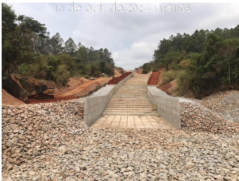
Figura 8.41 – Detalhe do desemboque do canal rápido na bacia de dissipação, com vista para montante (10/10/2024).
