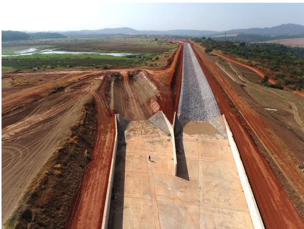
Figura 8.32 – Vista panorâmica para jusante do canal do reservatório (25/10/2024).
