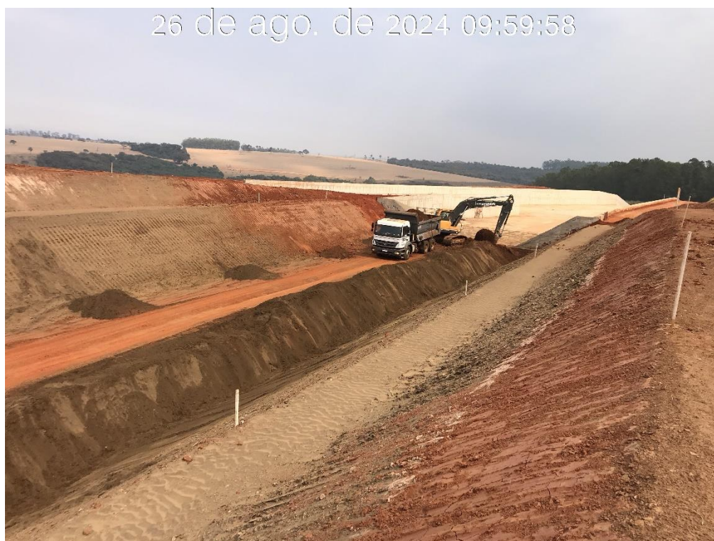
Figura 8.26 – Escavação do canal do reservatório, entre as estacas 01 e 05 (26/08/2024).
