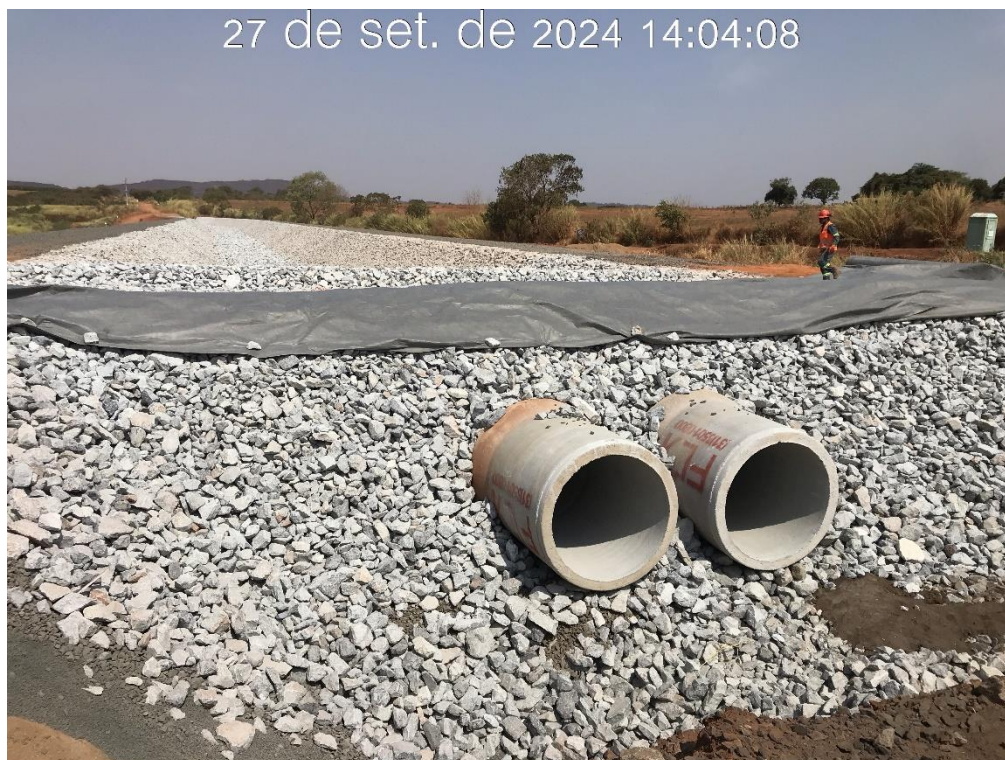
Figura 8.21 – Execução da transposição do canal periférico, na região da estaca 45, com vista para jusante (27/09/2024).
