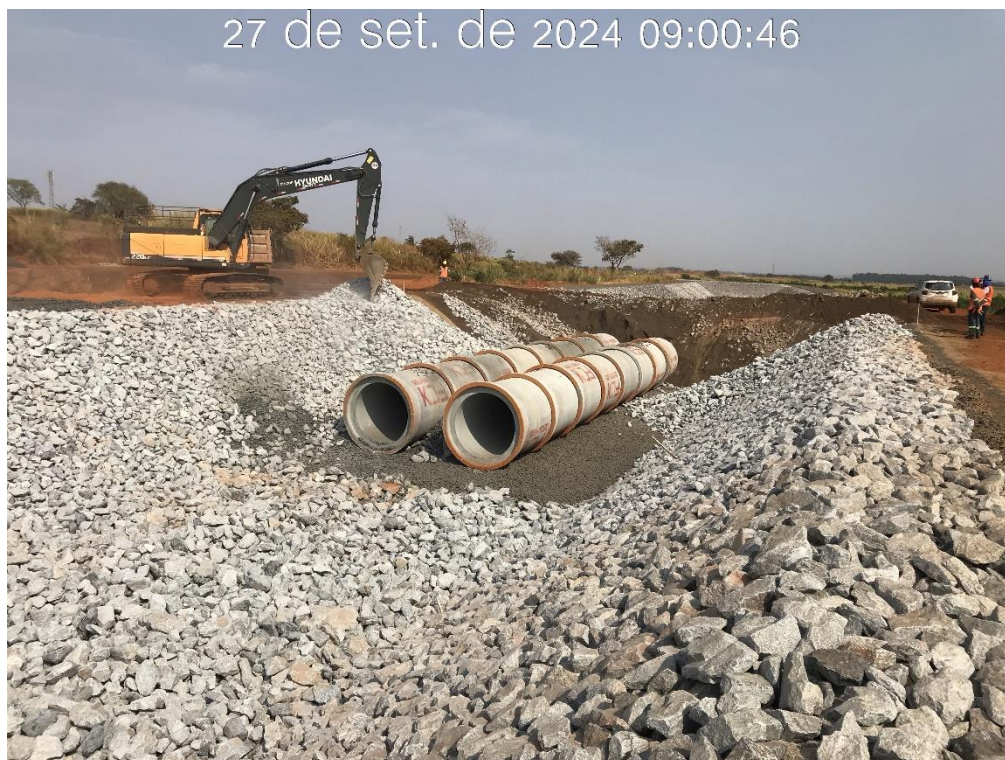
Figura 8.19 – Execução da transposição do canal periférico, na região da estaca 45, com vista para jusante (27/09/2024).
