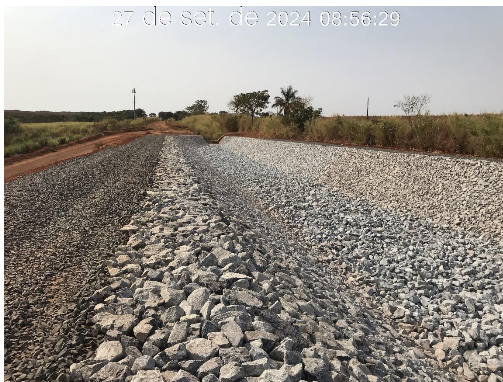
Figura 8.14 – Vista para montante do canal periférico, com detalhe da região de transição com o canal existente (27/09/2024).
