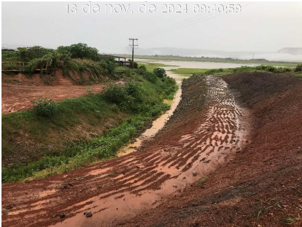
Figura 8.47 - – Limpeza do canal de aproximação da Barragem B5 (13/11/2024).
