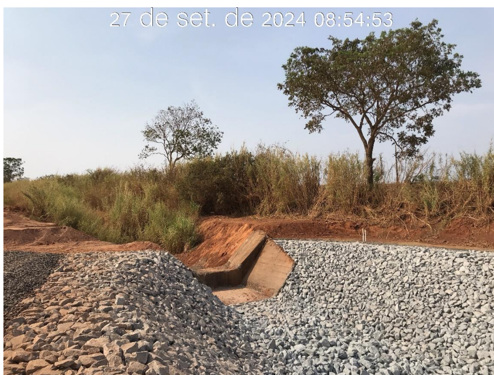
Figura 8.13 – Detalhe da área de transição entre o canal existente e o canal periférico (27/09/2024).
