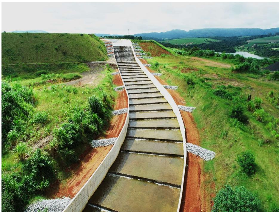
Figura 8.17 – Detalhe do canal rápido, na região do maciço da Barragem B5 (09/01/2025).
