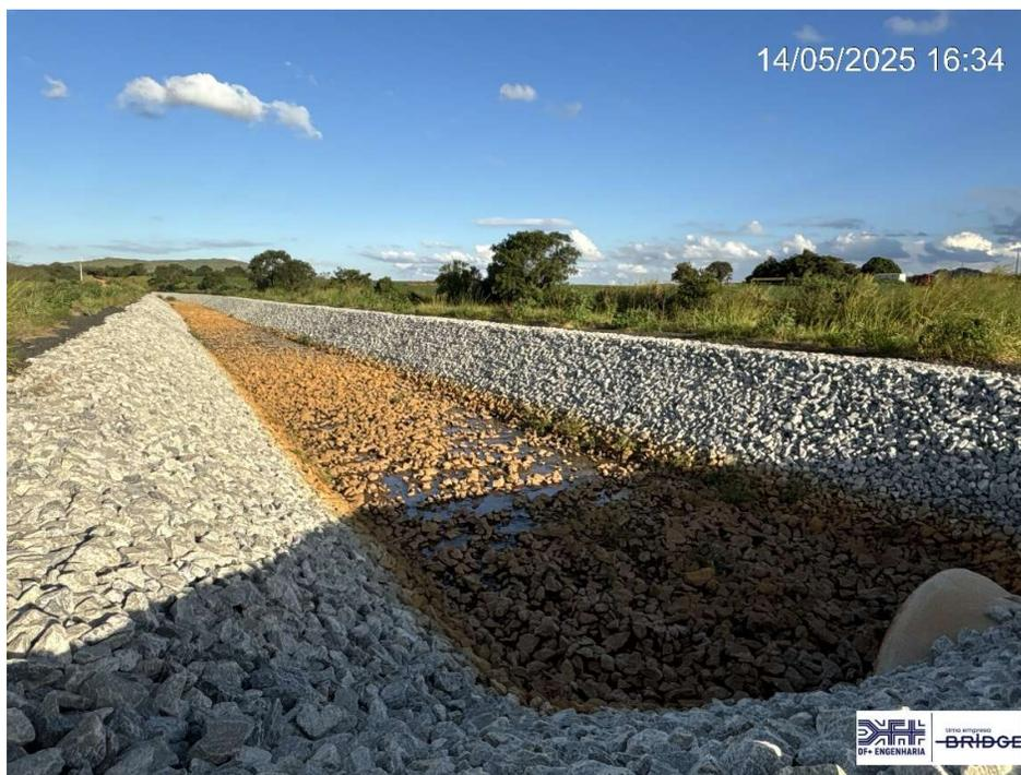
Figura 8.5 – Vista para montante do canal periférico na região da transposição provisória (14/05/2025).
