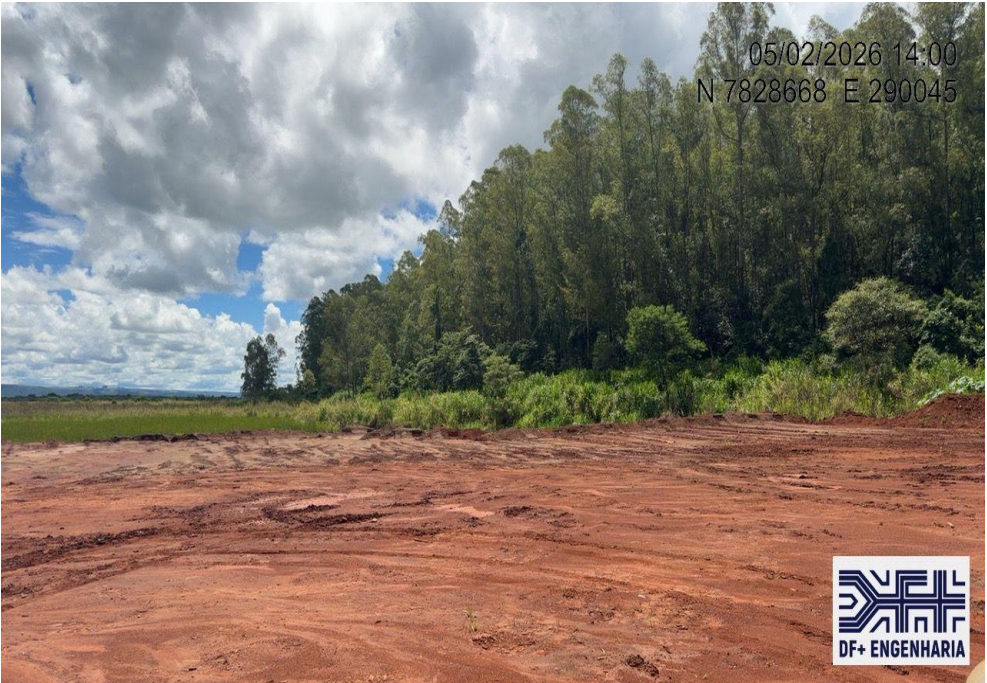
Figura 24 – Regularização do reservatório, vista para montante da Barragem B5 (05/02/2026).
