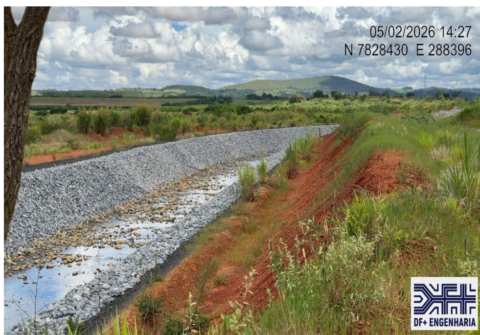
Figura 14 – Vista para montante do canal periférico, na região da estaca 180 (05/02/2026).
