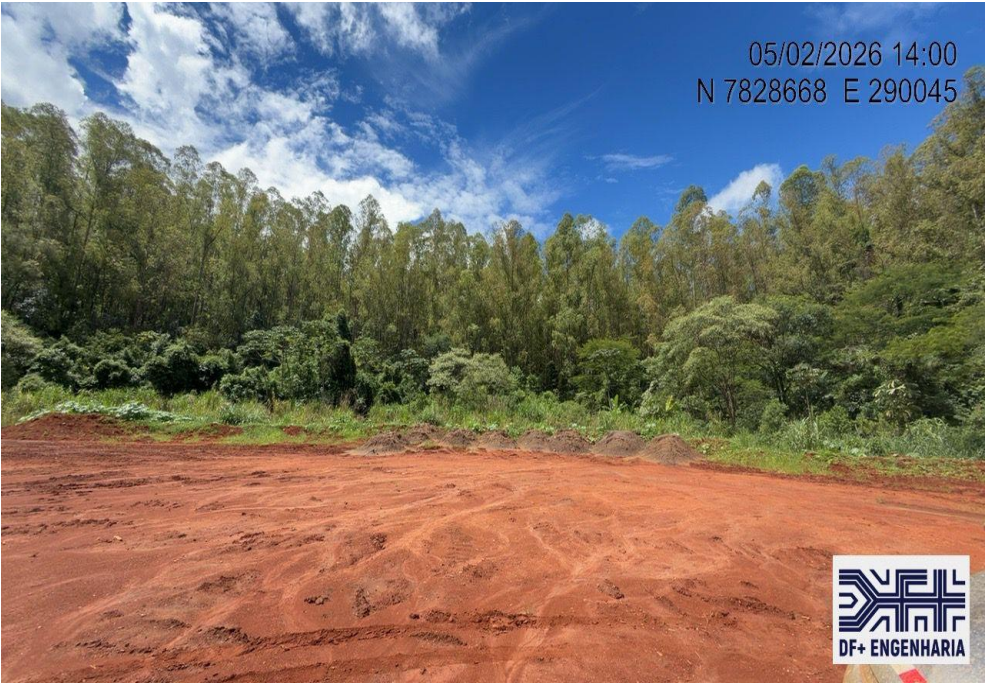
Figura 25 – Regularização do reservatório, vista para montante da Barragem B5 (05/02/2026).
