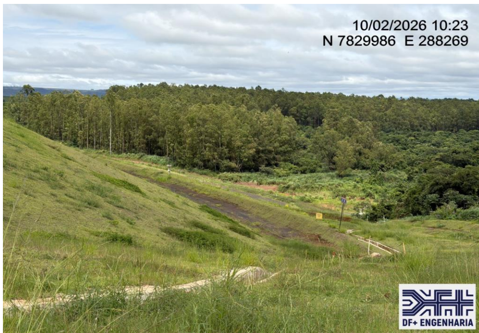
Figura 27 – Detalhe da grama e da drenagem superficial na região da ombreira direita Barragem B5 (10/02/2026).
