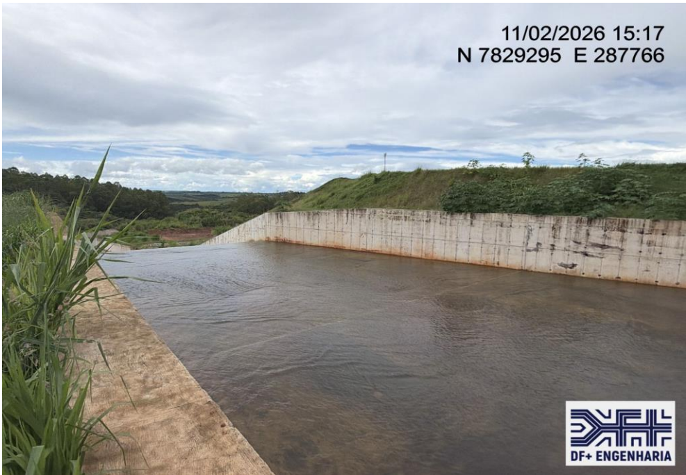
Figura 20 – Vista interna para jusante do canal rápido (11/02/2026).
