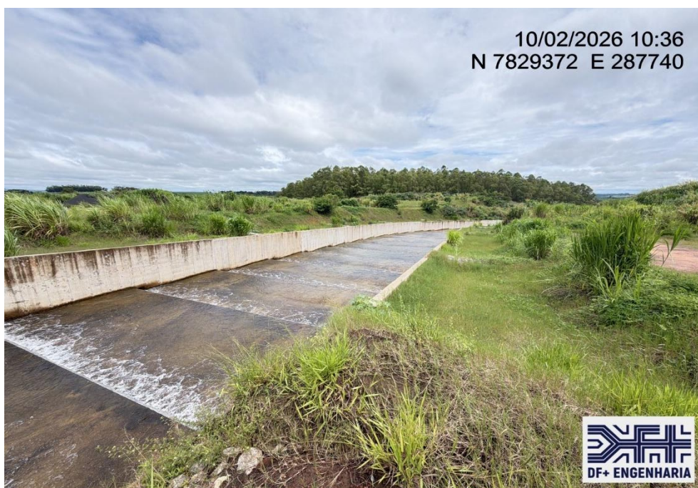
Figura 22 – Vista para jusante do canal rápido (10/02/2026).
