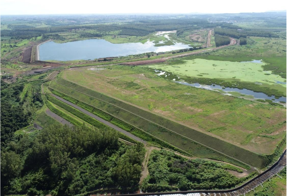
Figura 16 – Vista panorâmica da Barragem B5 (28/01/2026).
