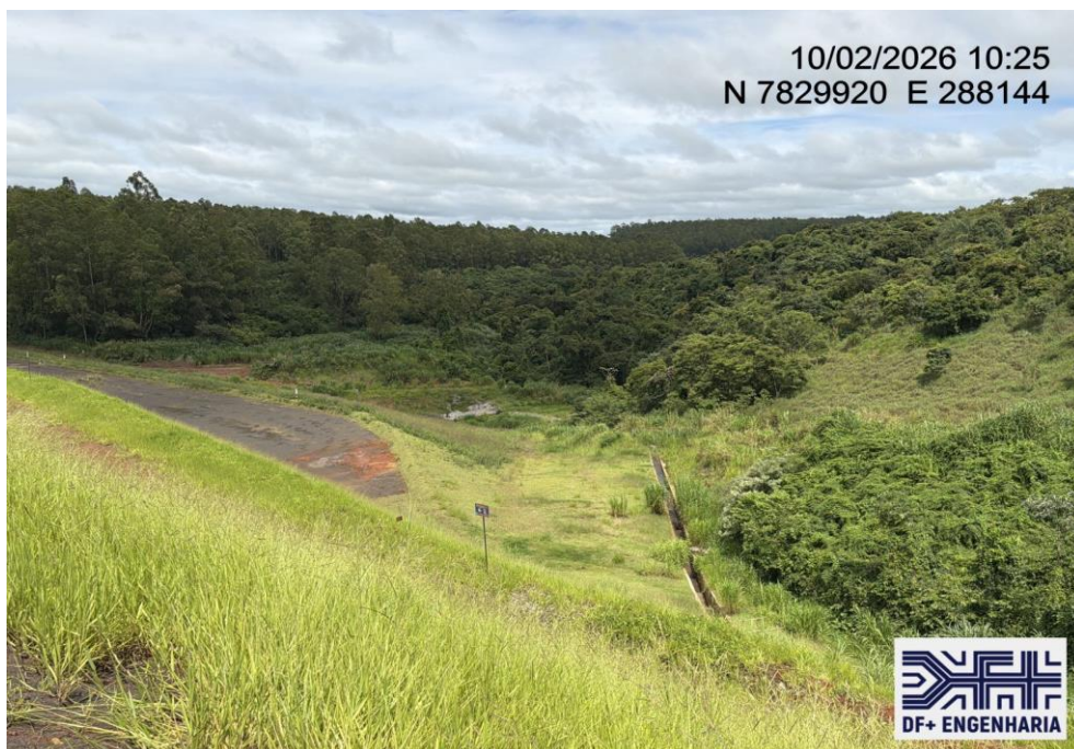
Figura 28 – Vista para jusante da Barragem B5 (10/02/2026).
