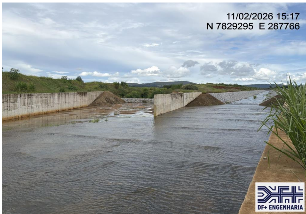
Figura 18 – Detalhe da região de transição do canal do reservatório para o canal rápido, com vista para montante (11/02/2026).
