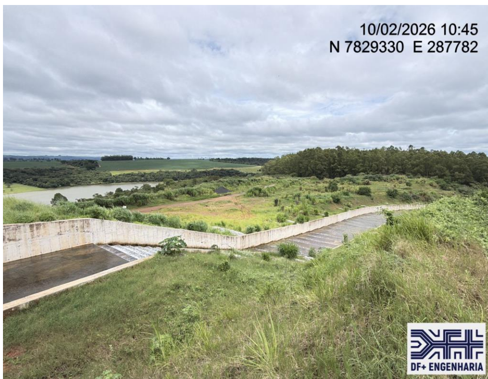
Figura 19 – Detalhe do canal rápido, vista para jusante do canal. (10/02/2026).
