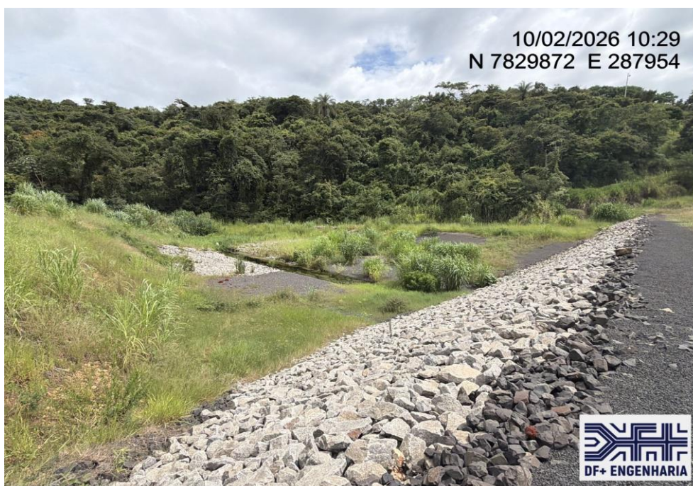
Figura 29 – Vista para jusante da Barragem B5, com detalhe da região do MV-01 (10/02/2026).
