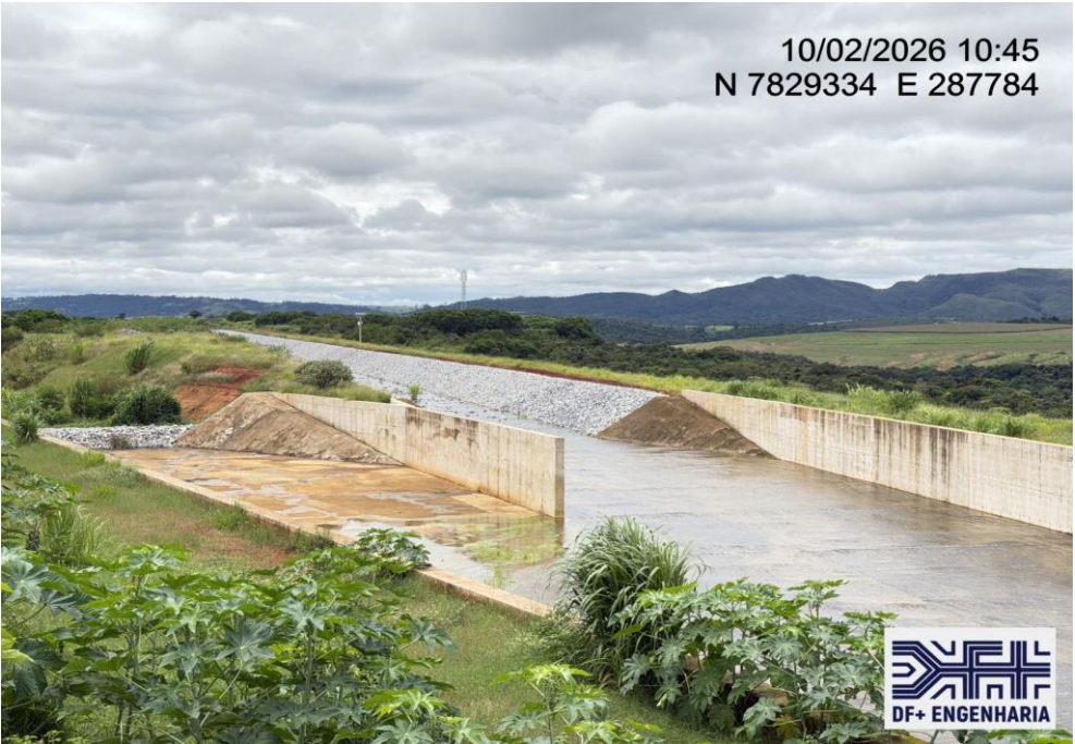
Figura 15 – Detalhe da região de transição do canal periférico para o canal rápido, com vista para montante (10/02/2026).
