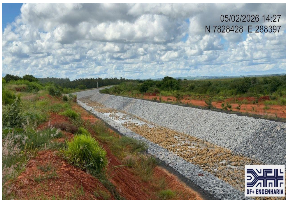
Figura 13 – Vista para jusante do canal periférico, na região da estaca 180 (05/02/2026).
