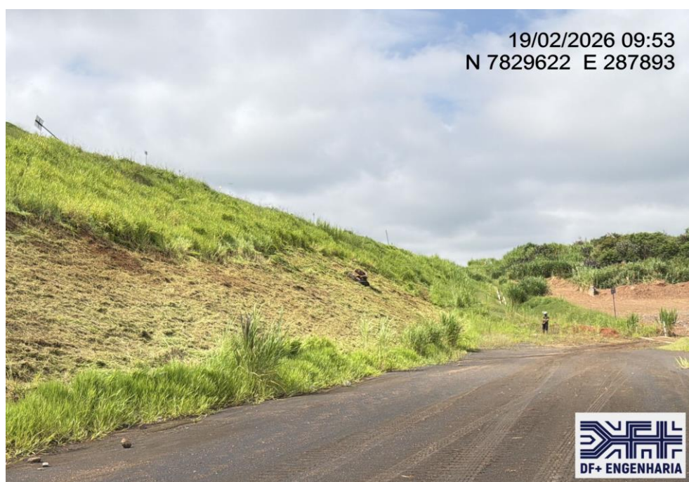
Figura 34 – Atividades em andamento (19/02/2026).
