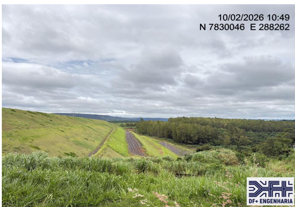
Figura 26 – Detalhe dos taludes de jusante da Barragem B5, com vista para ombreira esquerda (10/02/2026).
