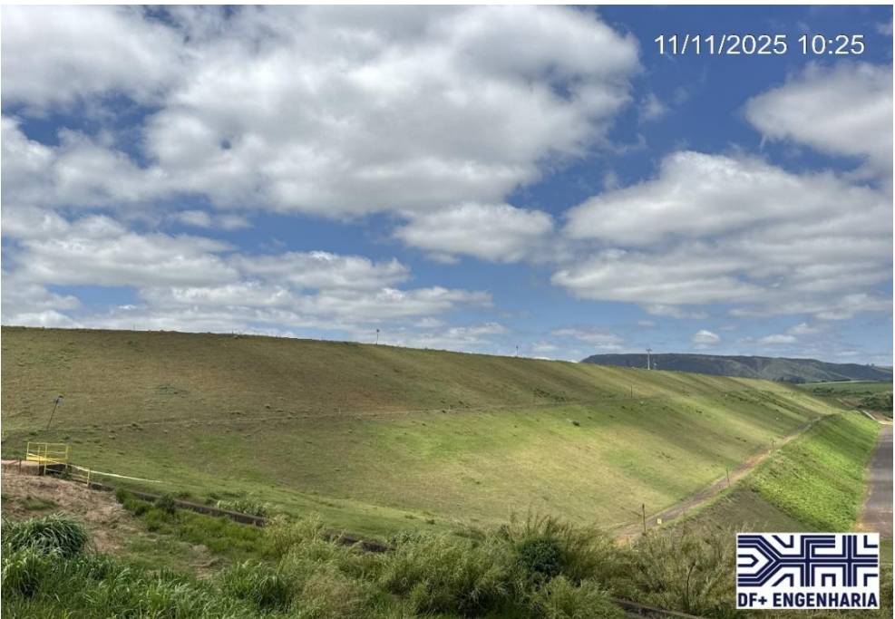
Figura 32 – Vista para ombreira esquerda da Barragem B5, com detalhe da roçada nos taludes de jusante (11/11/2025).
