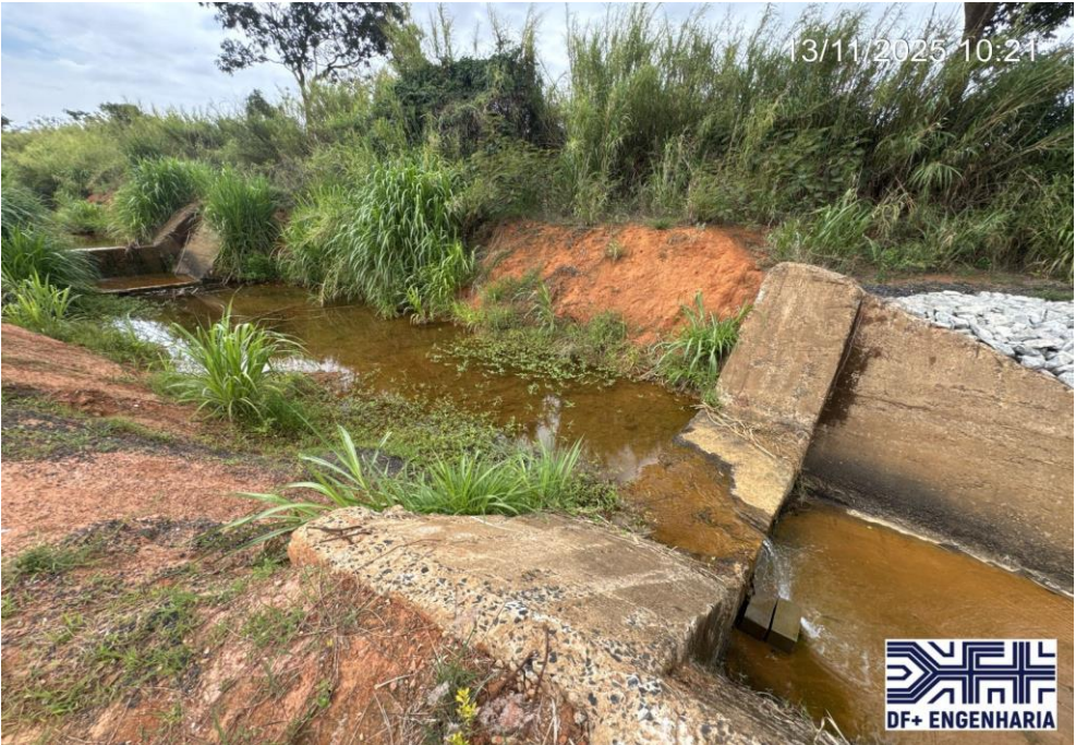
Figura 31 – Montante do canal periférico (13/11/2025).
