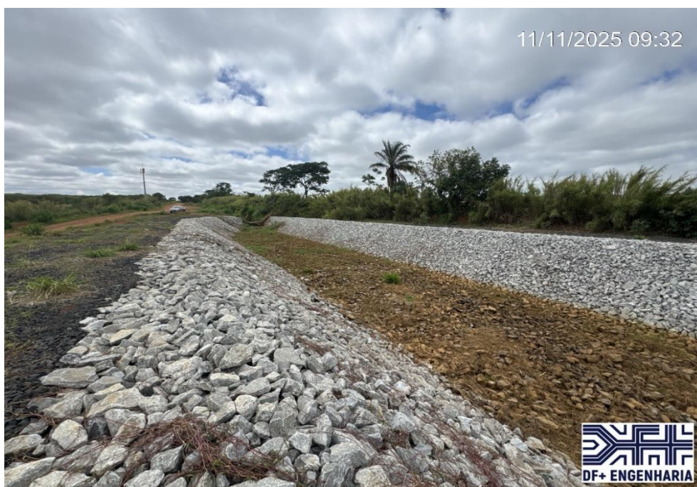
Figura 30 – Região de transição do canal existente para o canal periférico da Barragem B5 com vista para montante (11/11/2025).
