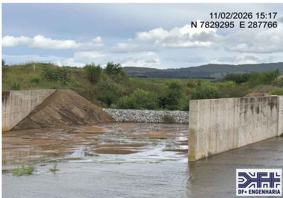
Figura 17 – Detalhe do canal do reservatório, com vista para montante (11/02/2026).
