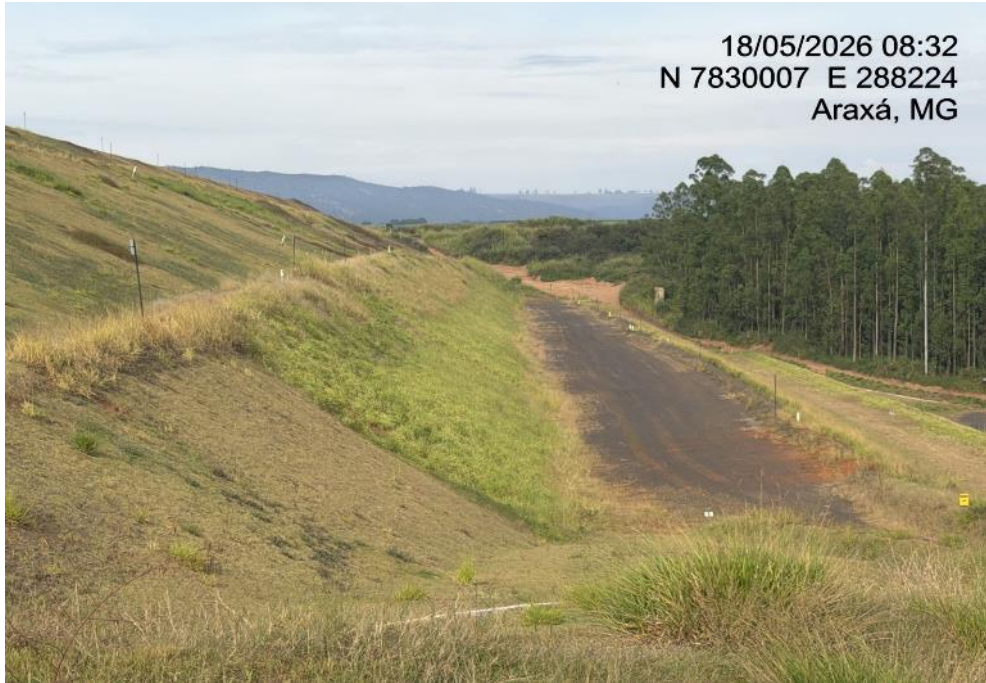
Figura 32 – Taludes com vista para a ombreira esquerda (18/05/2026).
