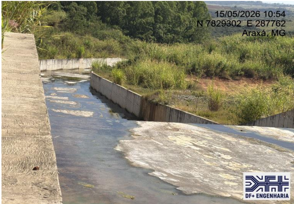
Figura 17 – Detalhe do canal rápido, vista para jusante do canal. (15/05/2026).
