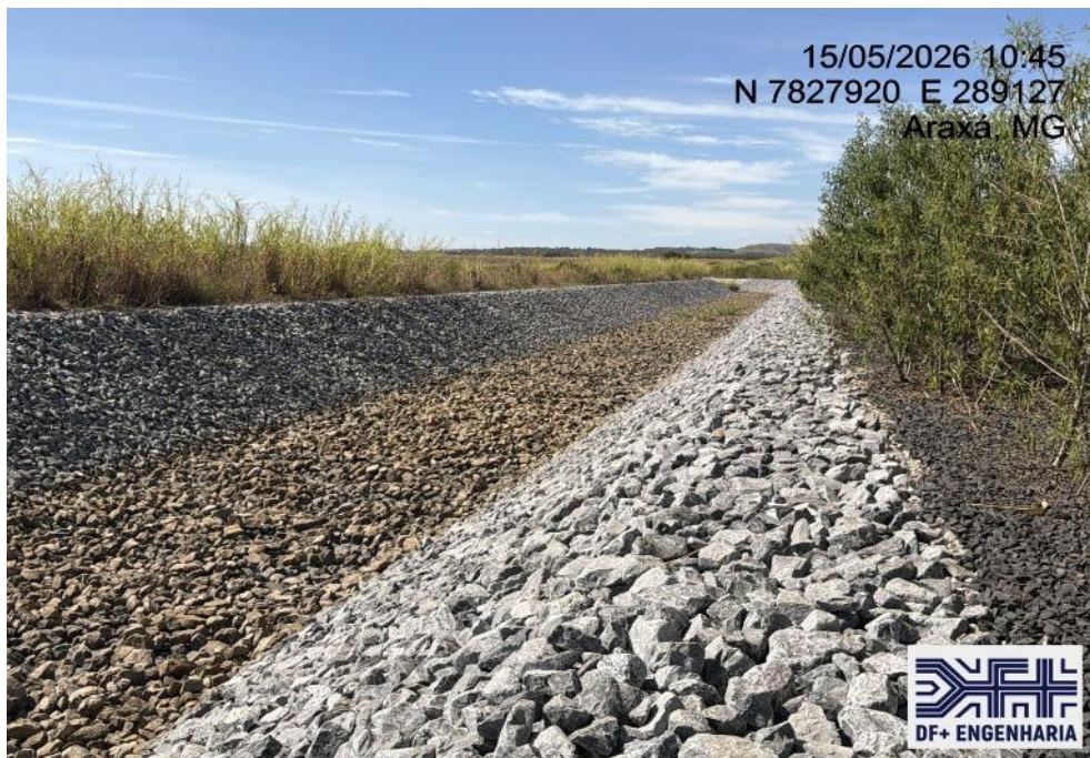
Figura 12 – Vista para montante do canal extravasor, na região da estaca 100 (15/05/2026).
