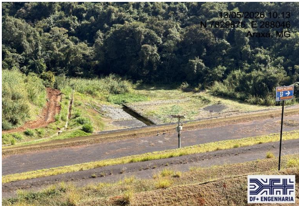
Figura 28 – Vista para jusante da Barragem B5, com detalhe da região do MV-01 (13/05/2026).
