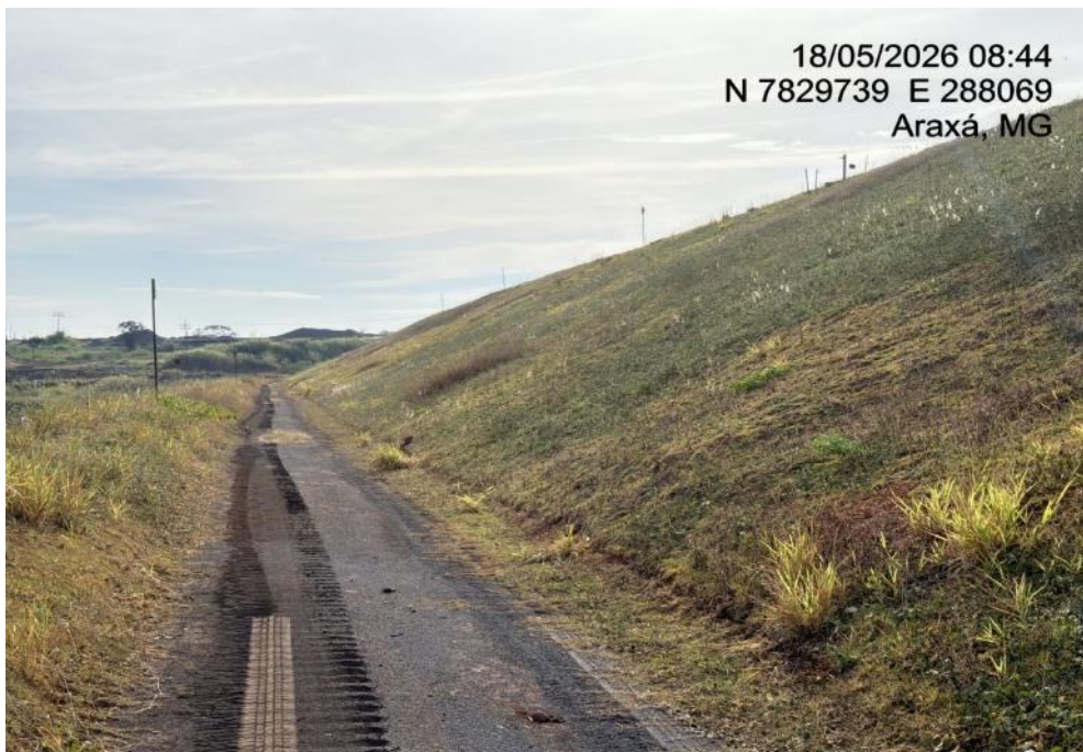
Figura 33 – Taludes com vista para a ombreira direita (18/05/2026).
