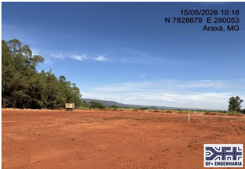
Figura 21 – Regularização do reservatório, vista para jusante da Barragem B5 (15/05/2026).
