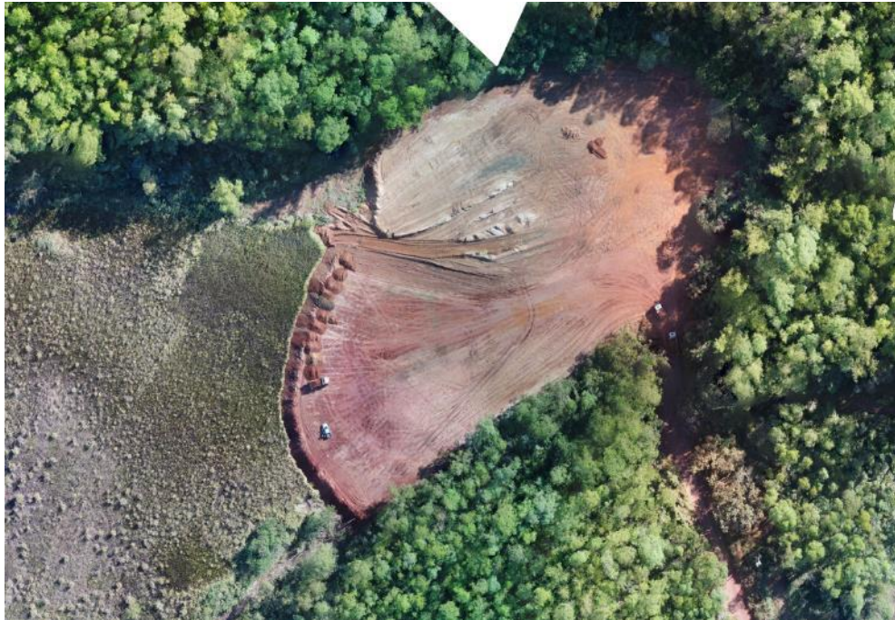
Figura 22 – Regularização do reservatório, vista aérea da Barragem B5 (08/05/2026).
