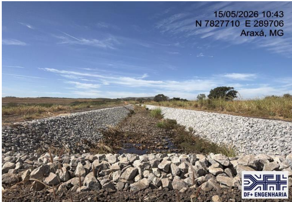
Figura 9 – Vista para montante do canal periférico na região da transposição provisória (15/05/2026).
