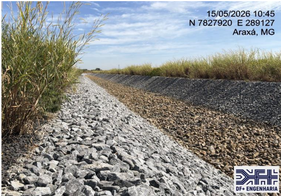
Figura 11 – Vista para jusante do canal periférico, na região da estaca 100 (15/05/2026).
