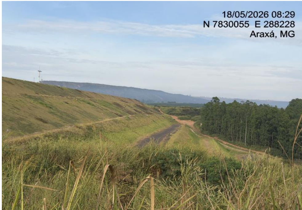
Figura 25 – Detalhe dos taludes de jusante da Barragem B5, com vista para ombreira esquerda (18/05/2026).
