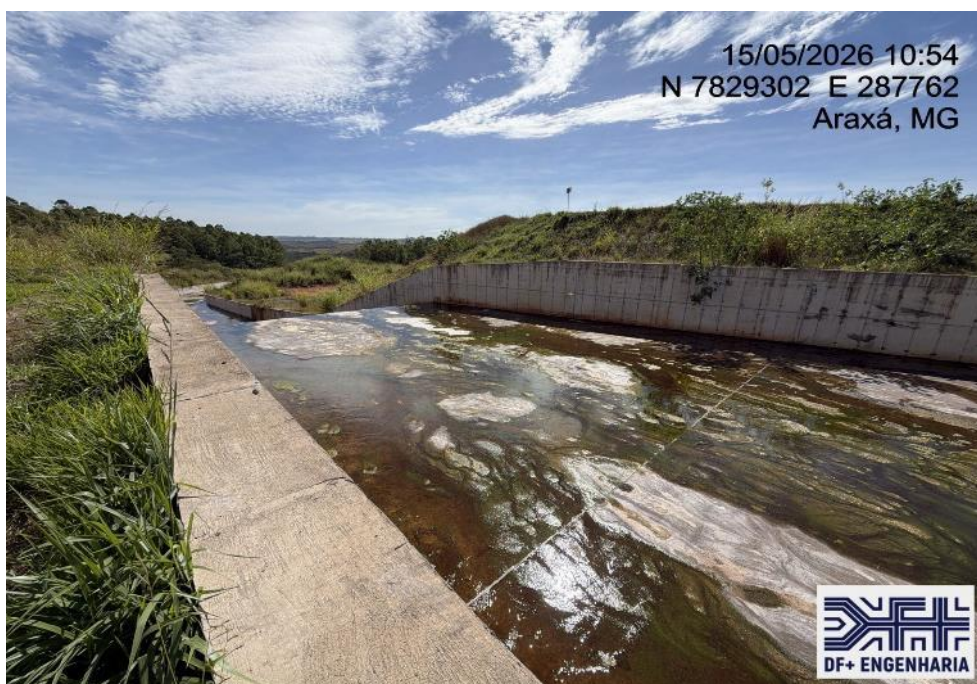
Figura 18 – Vista interna para jusante do canal rápido (15/05/2026).
