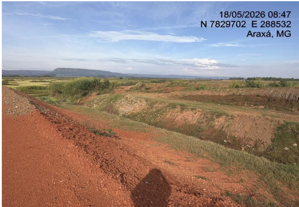
Figura 30 – Canal aproximação entrada da galeria Barragem B5, vista para o reservatório (13/05/2025).
