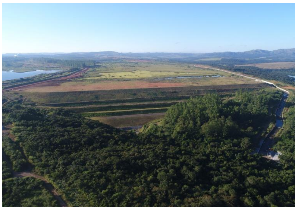
Figura 14 – Vista panorâmica da Barragem B5 (05/05/2026).
