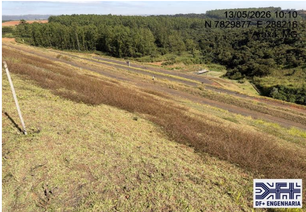
Figura 27 – Vista para jusante da Barragem B5 (13/05/2026).
