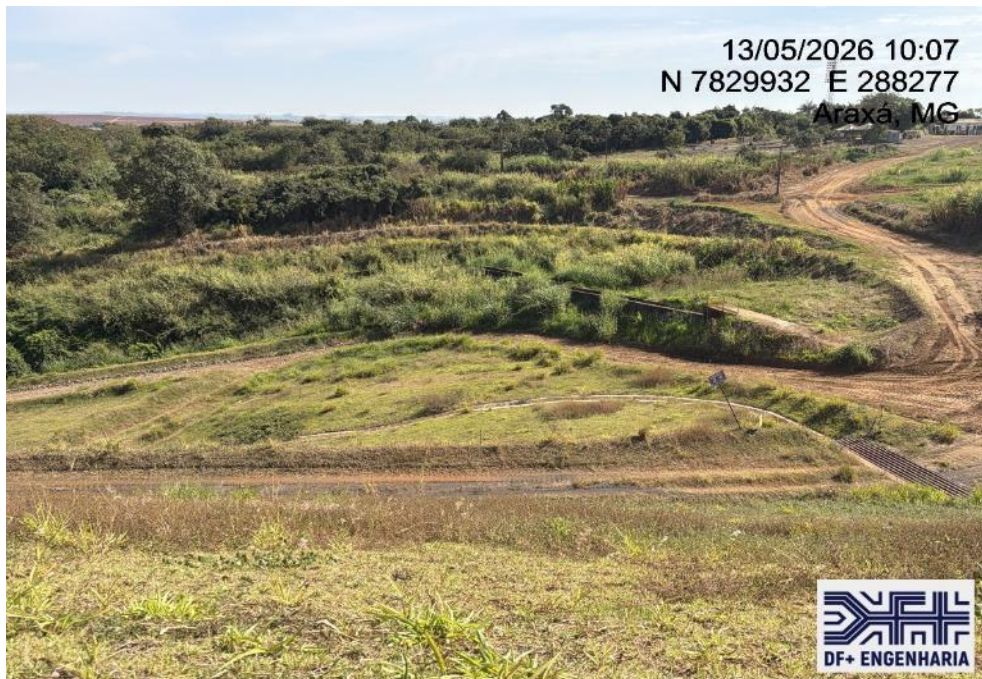
Figura 26 – Detalhe da grama e da drenagem superficial na região da ombreira direita Barragem B5 (13/05/2026).
