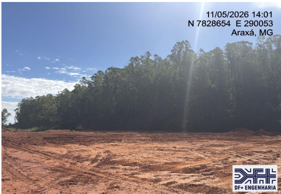
Figura 23 – Regularização do reservatório, vista para jusante da Barragem B5 (11/05/2026).
