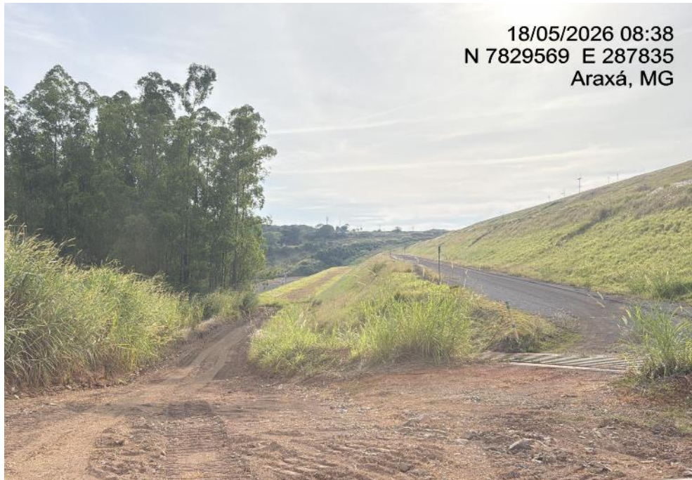
Figura 36 – Tratamento finalizado no dia 19/02/2026, na inspeção para elaboração do relatório o acesso segue tratado (18/05/2026).
