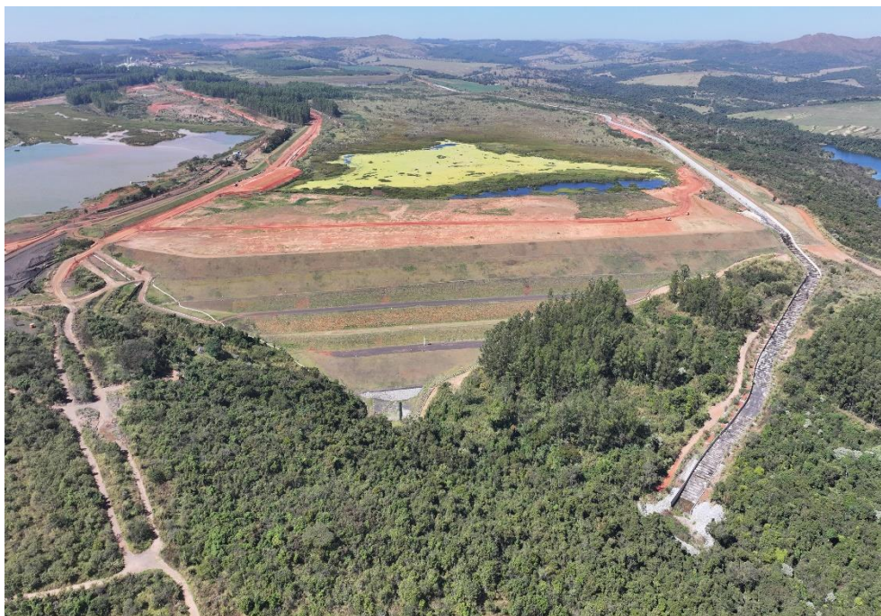
Figura 13 – Vista panorâmica da Barragem B5 (31/07/2026).
