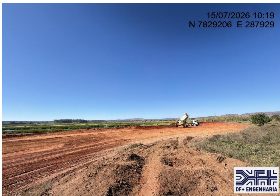
Figura 22 – Regularização do reservatório área lago, vista para montante da Barragem B5 (15/07/2026).
