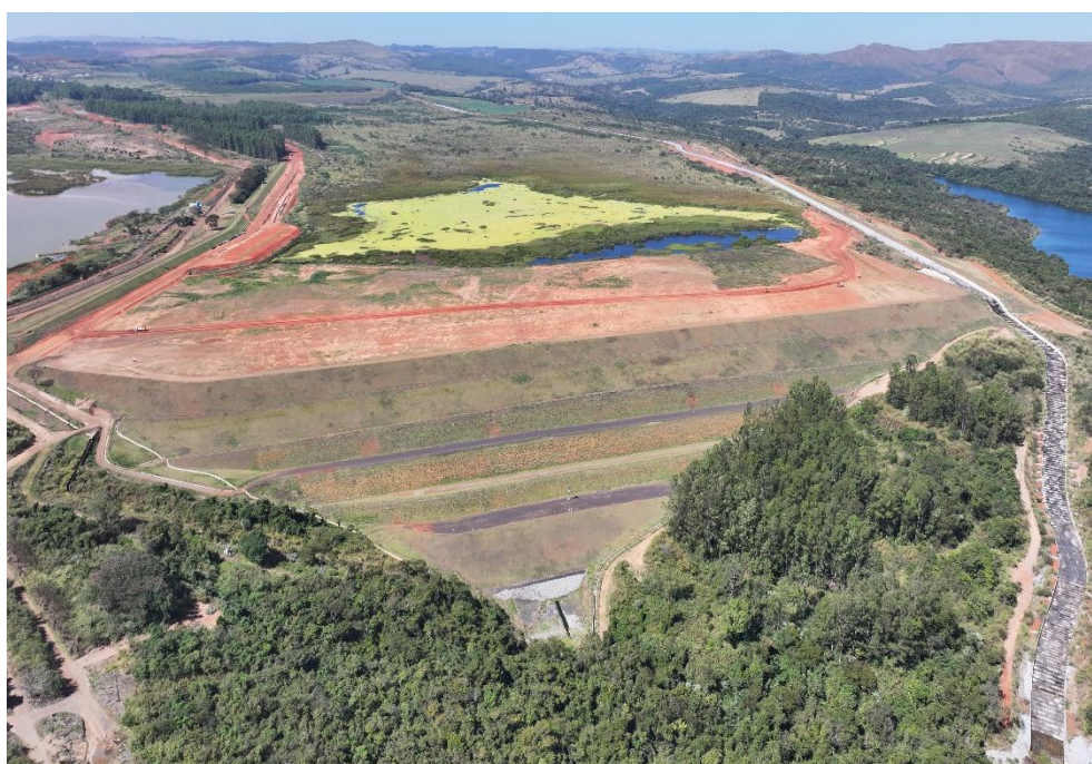
Figura 24 – Detalhe dos taludes de jusante da Barragem B5, com vista superior (31/07/2026).
