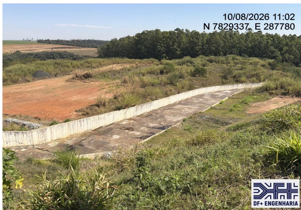
Figura 16 – Detalhe do canal rápido, vista para jusante do canal. (10/08/2026).
