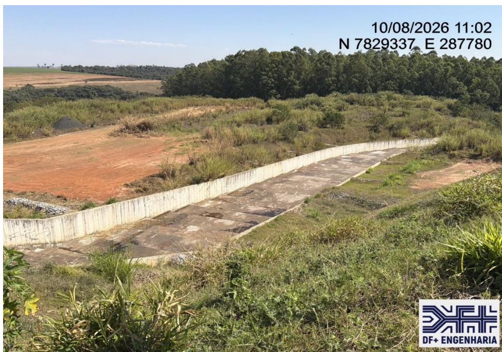
Figura 19 – Vista para jusante do canal rápido (10/08/2026).
