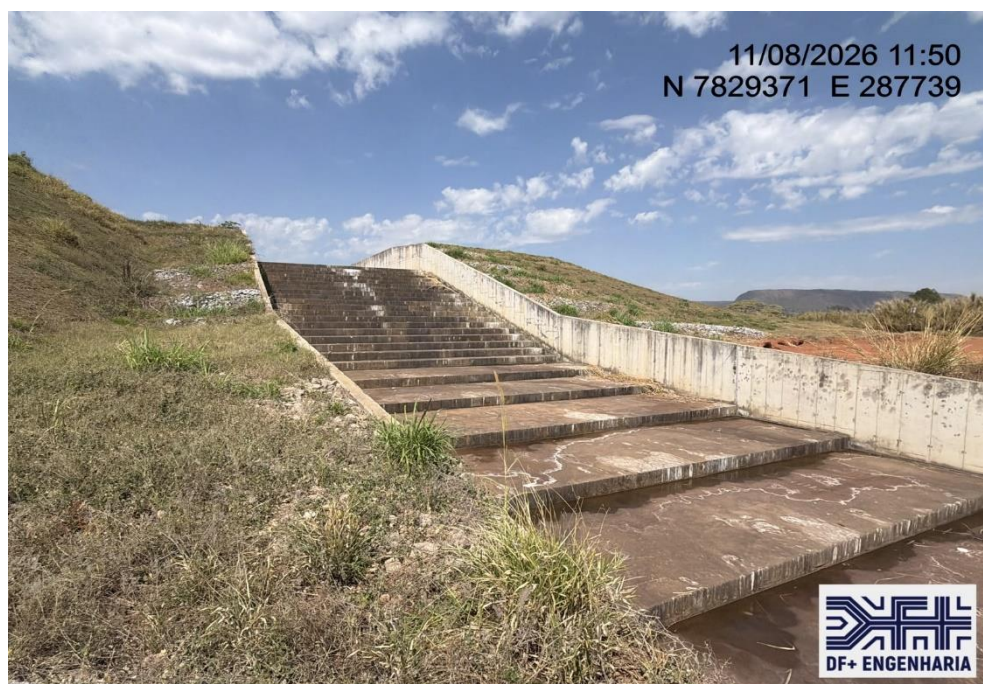
Figura 18 – Detalhe do canal rápido, na região do maciço da Barragem B5 (11/08/2025).
