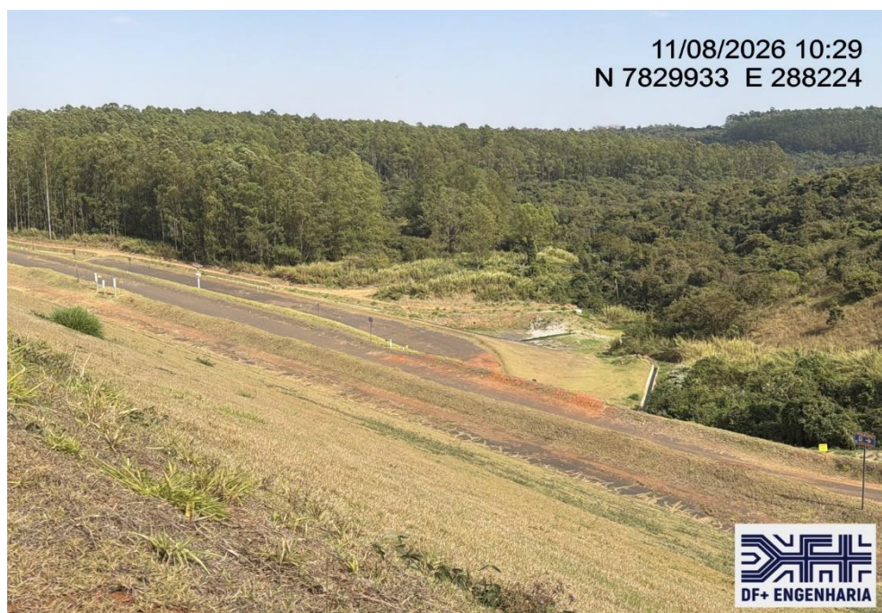
Figura 26 – Vista para jusante da Barragem B5 (11/08/2026).
