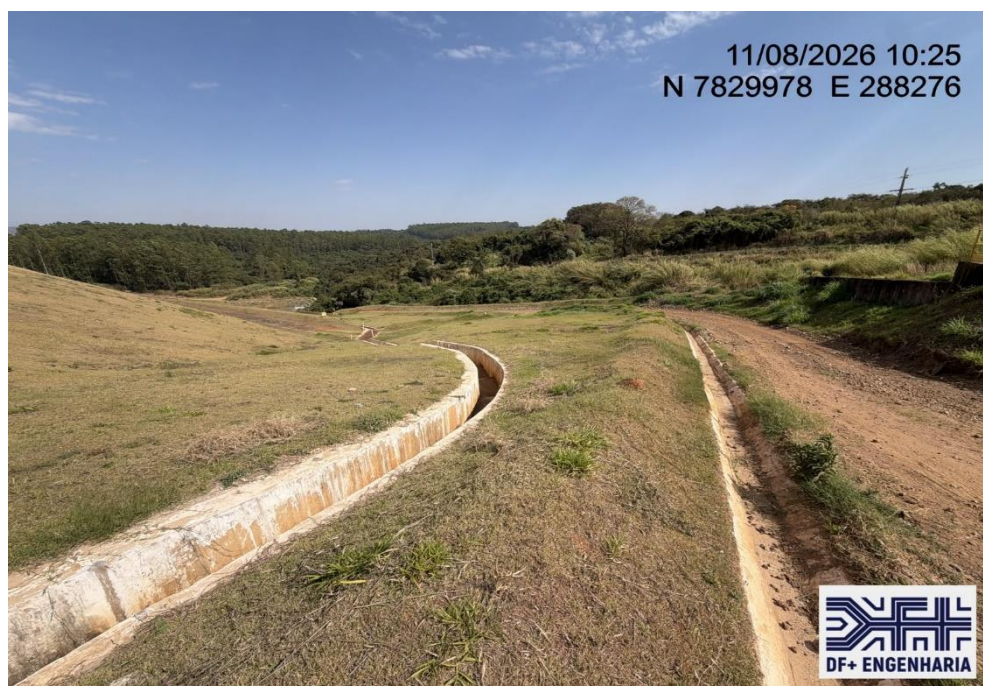
Figura 25 – Detalhe da grama e da drenagem superficial na região da ombreira direita Barragem B5 (11/08/2026).
