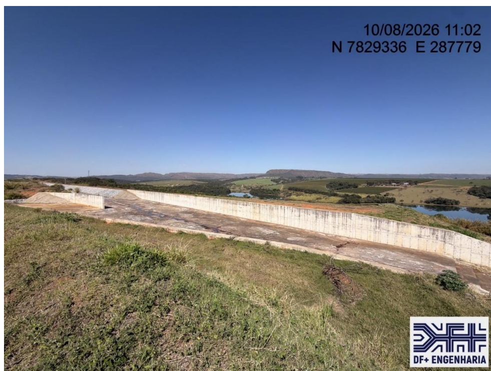
Figura 12 – Detalhe da região de transição do canal periférico para o canal rápido, com vista para montante (10/08/2026).
