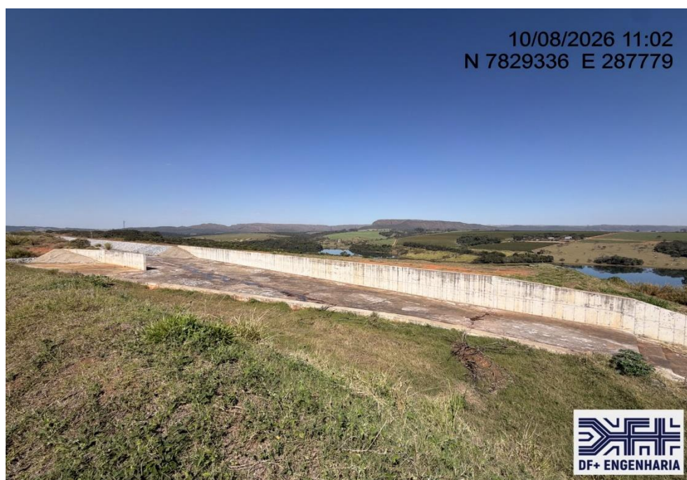
Figura 15 – Detalhe da região de transição do canal do reservatório para o canal rápido, com vista para montante (10/08/2026).
