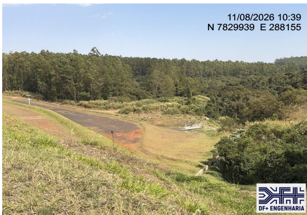
Figura 27 – Vista para jusante da Barragem B5, com detalhe da região do MV-01 (11/08/2026).
