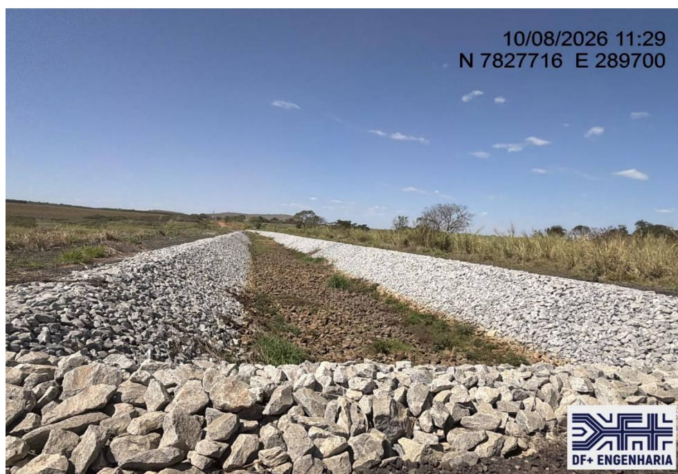
Figura 8 – Vista para montante do canal periférico na região da transposição provisória (10/08/2026).
