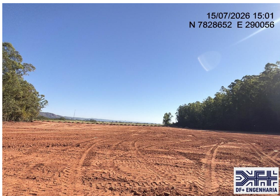
Figura 20 – Regularização do reservatório área 02, vista para jusante da Barragem B5 (15/07/2026).
