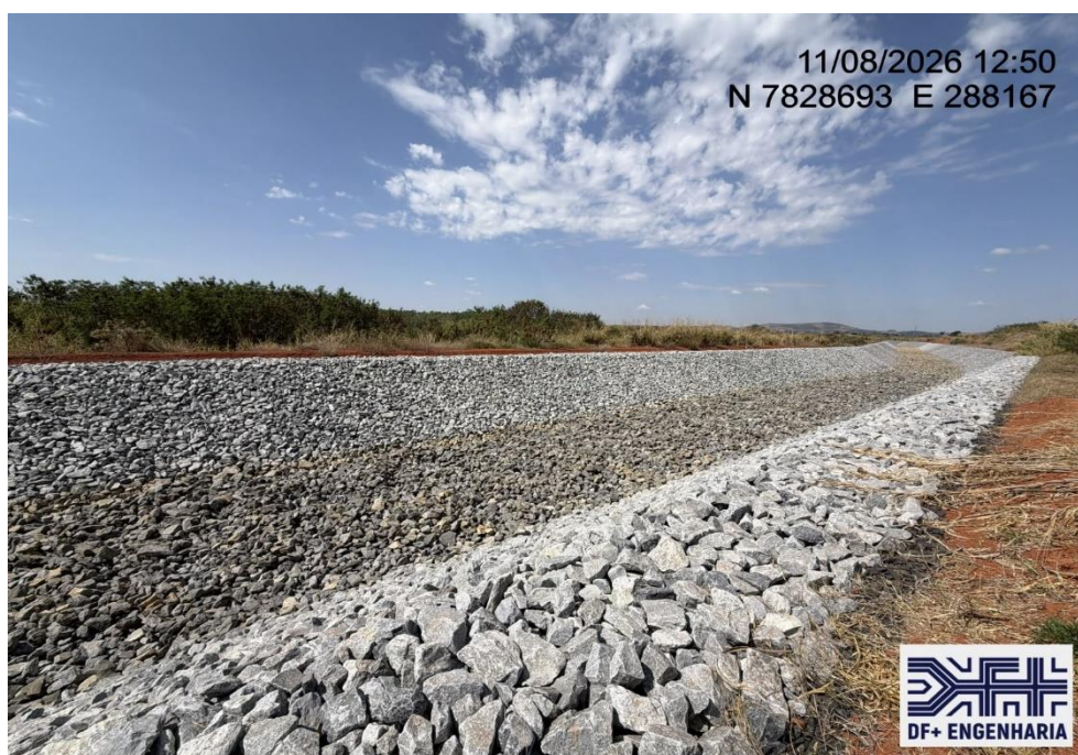
Figura 10 – Vista para montante do canal periférico, na região do dique (11/08/2026).
