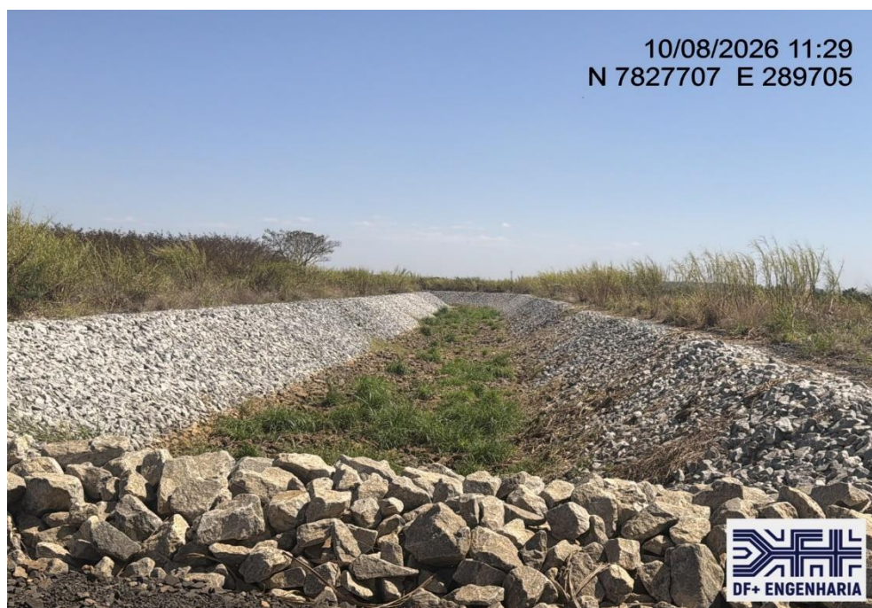
Figura 9 – Vista para jusante do canal periférico, após a saída da transposição (10/08/2026).
