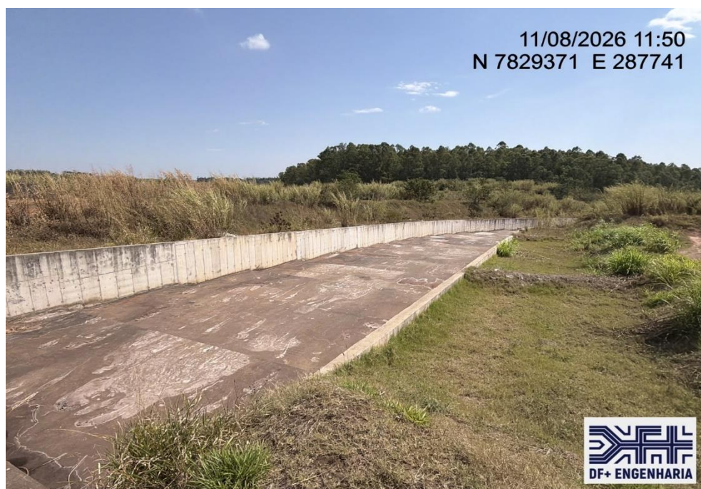
Figura 17 – Vista interna para jusante do canal rápido (11/08/2026).
