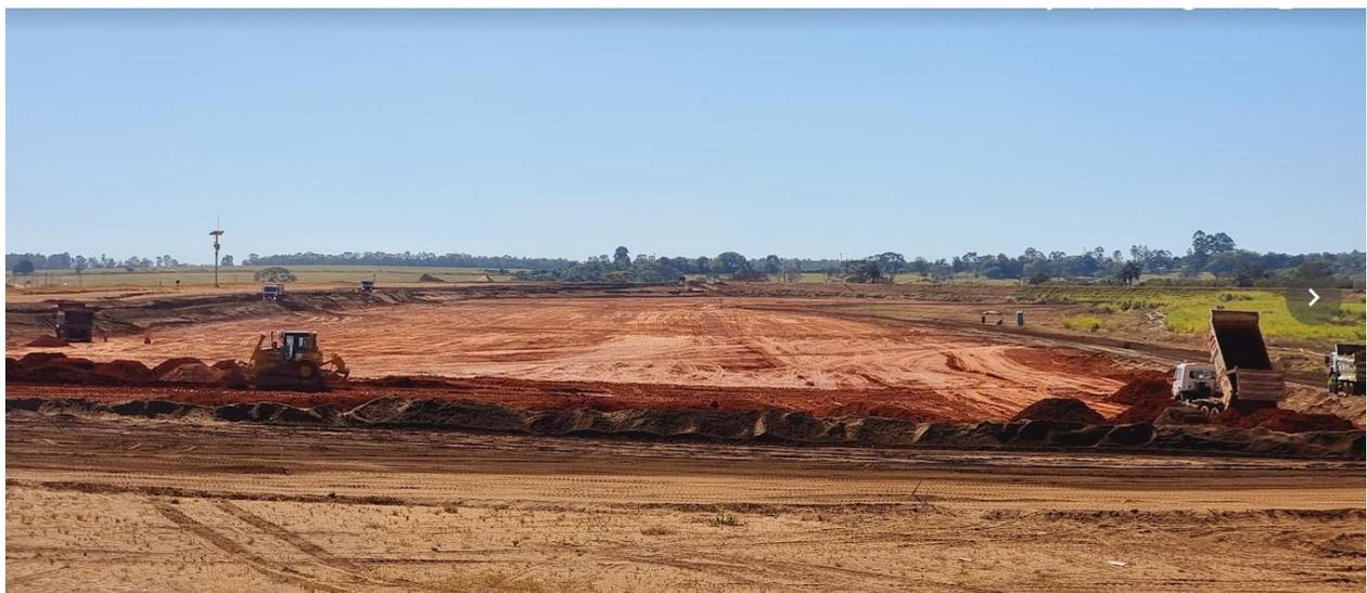
Figura 5.1.3.4 – Escavação de rejeito na praia em substituição por silte (08/06/2022).
