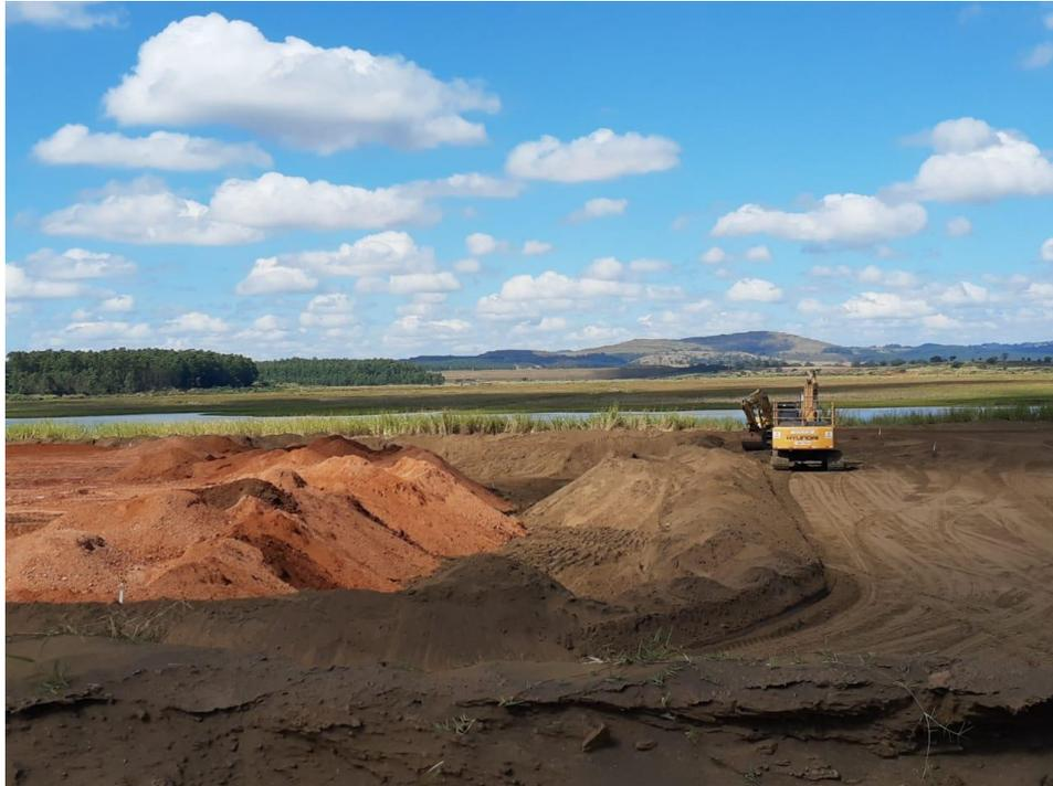
Figura 5.1.3.1 – Escavação para substituição de rejeito na praia da barragem (15/06/2022).
