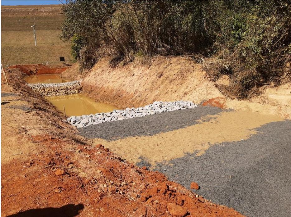
Figura 5.1.2.5 – Filtro da bacia de sedimentação da água proveniente da escavação da região do reforço (24/06/2022).
