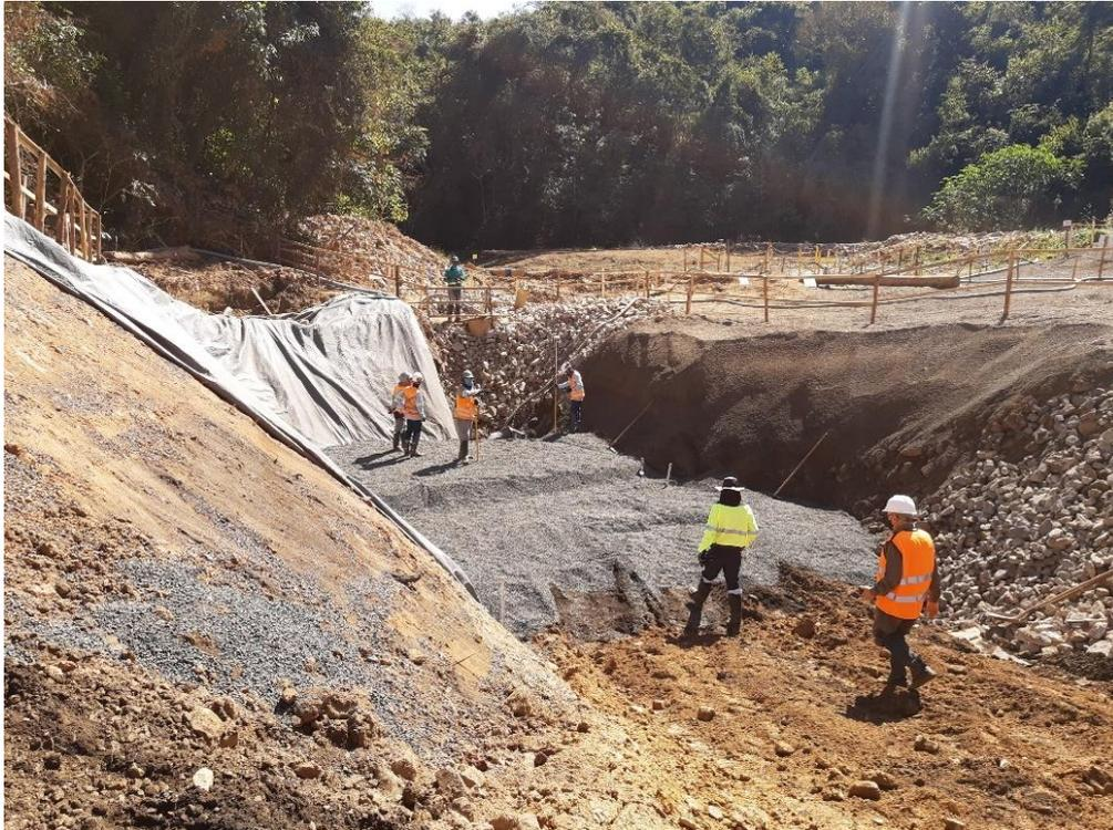
Figura 5.1.2.7 – Lançamentos de materiais na fundação, após escavação (01/07/2022).
