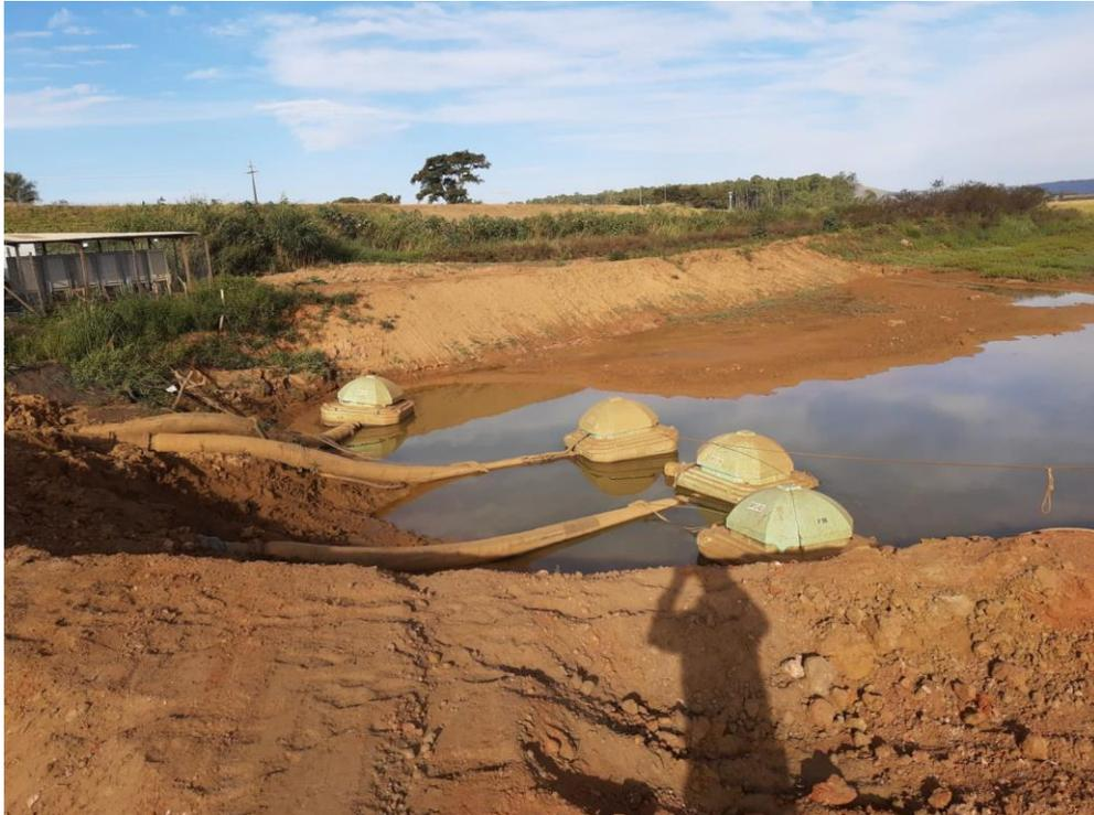
Figura 5.1.4.1 – Sistema de bombeamento instalado no reservatório da B5 (14/06/2022).
