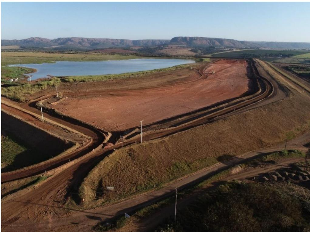
Figura 5.1.3.5 – Conformação final da praia após a substituição de rejeito por silte (04/07/2022).
