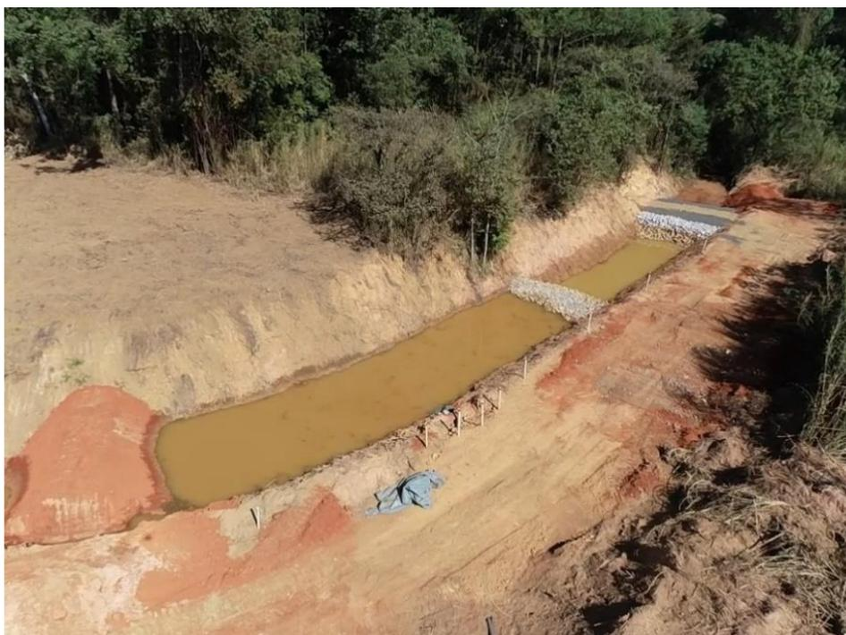
Figura 5.1.2.4 – Construção de bacia de decantação de sedimentos para garantir a qualidade da água oriunda da escavação (24/06/2022).
