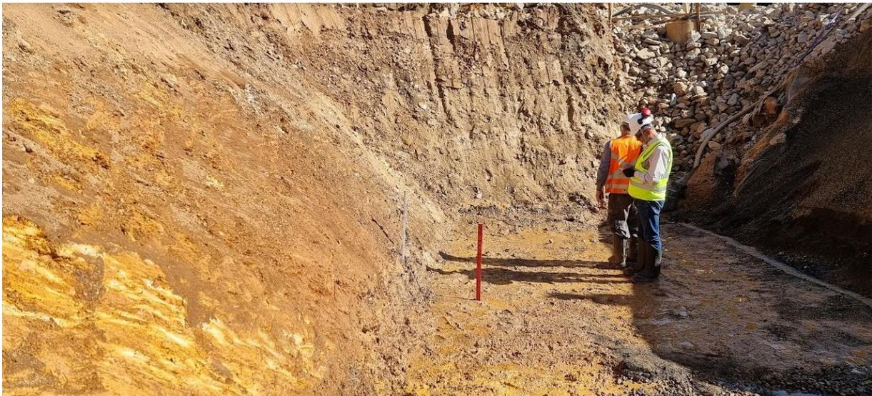
Figura 5.1.2.6 – Escavação da região de fundação liberada (28/06/2022)
