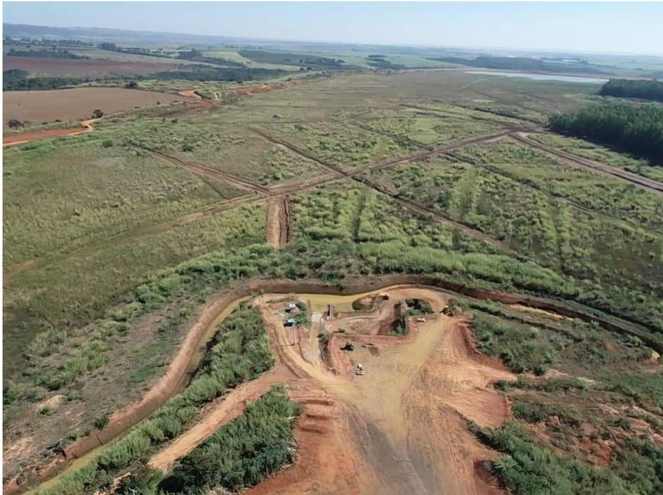
Figura 5.1.1.2 – Abertura de canais para direcionamento de água para o sistema de bombeamento (02/06/2022).
