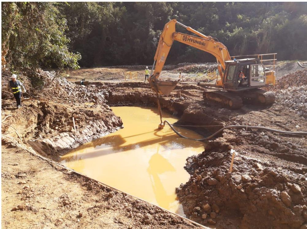
Figura 5.1.2.3 – Instalação de sistema de bombeamento na região da escavação do reforço de fundação (14/06/2022).
