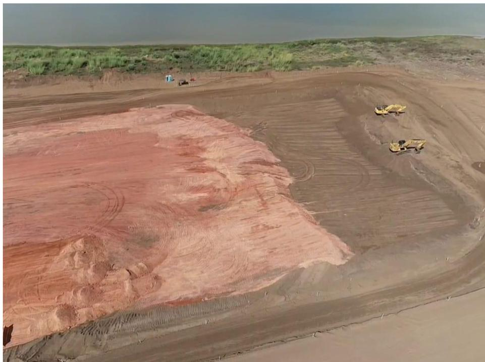
Figura 5.1.3.2 – Substituição de rejeito por silte na praia da barragem (26/05/2022).
