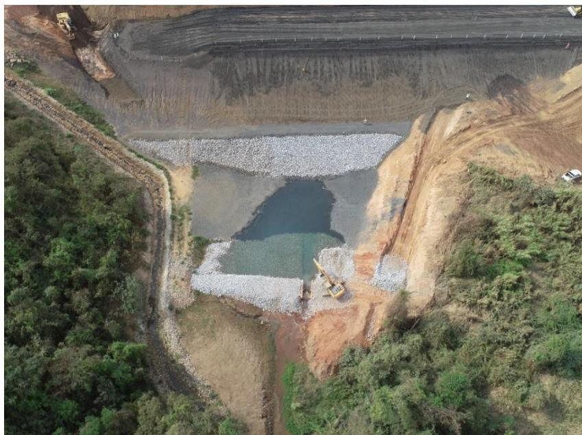
Figura 5.1.7 – Vista aérea da fundação da barragem B5
