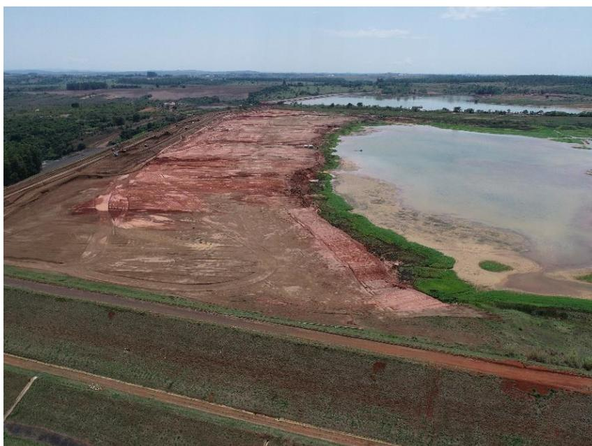
Figura 5.1.17 – Corte e regularização da praia da barragem b5 para elevação 964,50 m
