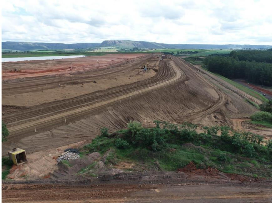
*Figura 5.1.18 – Corte e regularização da praia da barragem b5 para elevação 964,50 m*
