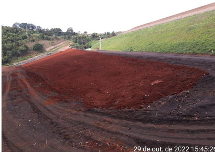
Figura 5.1.16 – Conclusão de lançamento de argila no aterro de magnetita (Argila em substituição ao top soil)
