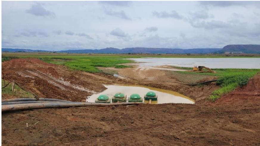
Figura 5.1.2 – Sistema de drenagem principal do reservatório da barragem B5
