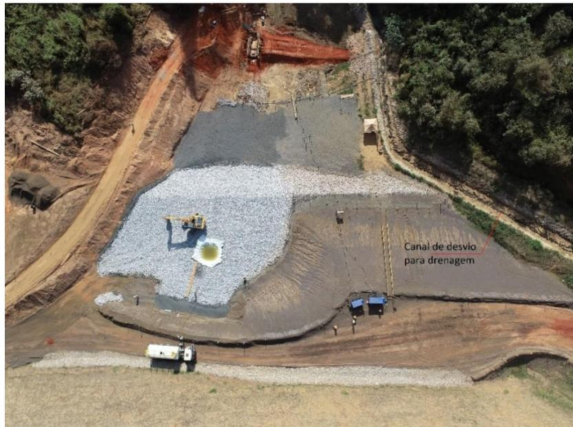
Figura 5.1.6 – Vista aérea da fundação da barragem B5
