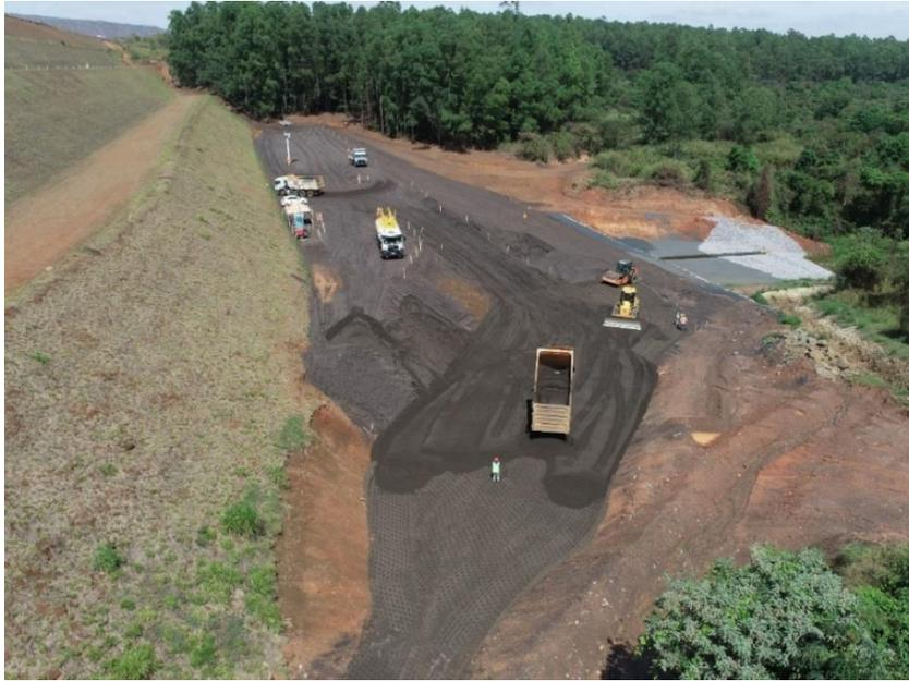
*Figura 5.1.14 – Lançamento, espalhamento e compactação de rejeito em magnetita na região da trincheira citada acima*
