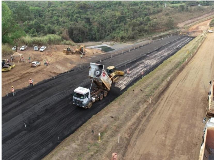
*Figura 5.1.13 – Lançamento, espalhamento e compactação de magnetita em paralelo a abertura da trincheira acima*
