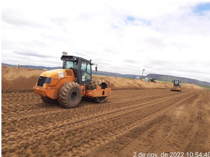
*Figura 5.1.19 – Lançamento, espalhamento e compactação de rejeito*
