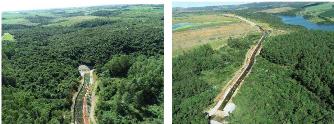
Figura 4 – Vista aérea Canal Rápido e Bacia de Dissipação
