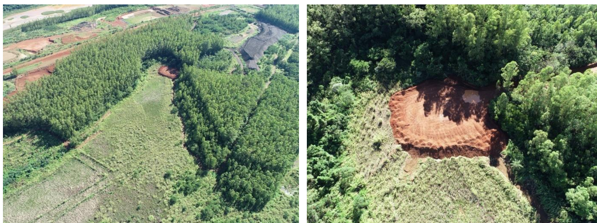
Figura 2 – Aterro de Regularização do Reservatório
