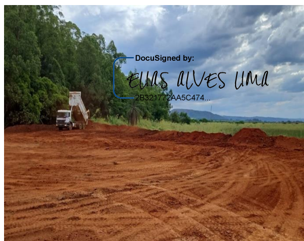
Figura 3 – Aterro de Regularização do Reservatório
