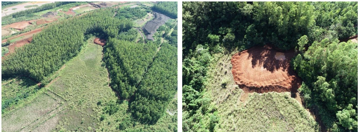
Figura 02 – Aterro de Regularização do Reservatório
