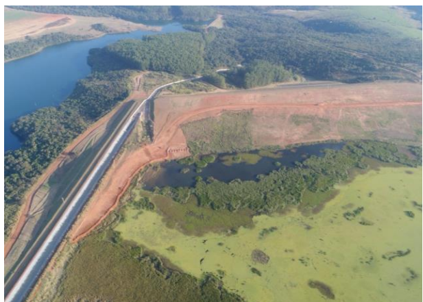
Figura 04 – Aterro de Regularização do Reservatório em Condições Atuais
