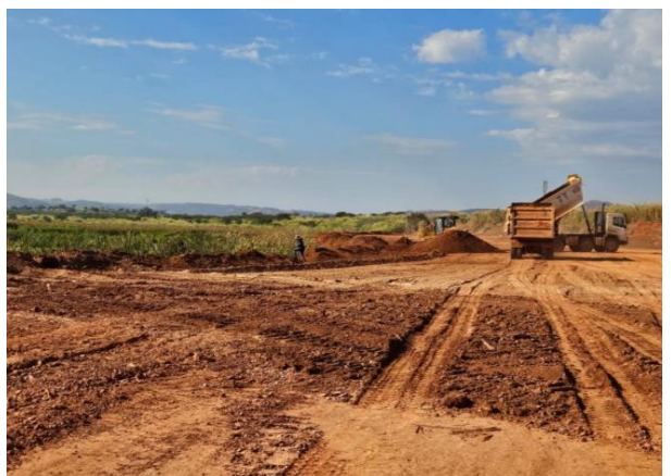
Figura 05 – Aterro de Regularização do Reservatório em Condições Atuais
