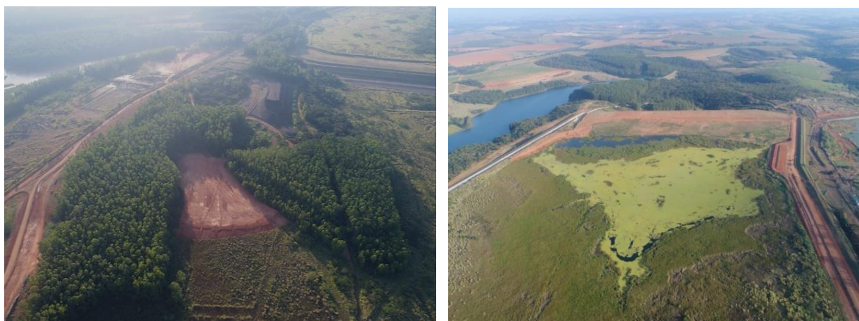
Figura 02 – Aterro de Regularização do Reservatório
