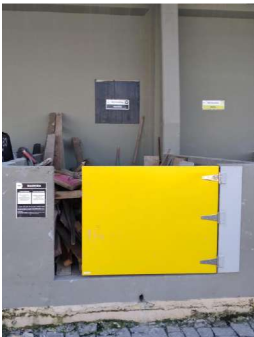
Figura 12 - Armazenamento de madeira
