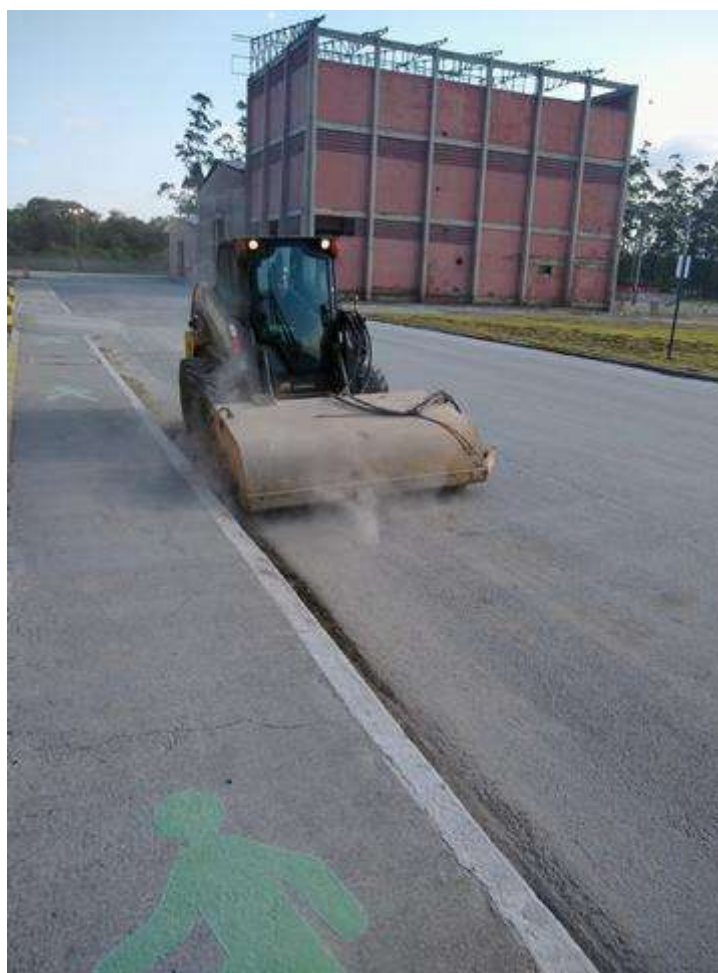
Figura 2 – Limpeza de ruas de fábrica, realizada com Bob cat com implemento de vassoura recolhadora.
