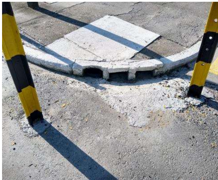
Figura 1 – Boca de lobo “Bueiro”, realização de limpeza semanal, evitando que contaminantes contamine a galeria pluvial.
