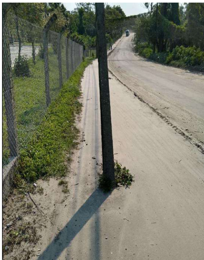
Figura 5 – Calçada com interferência do poste
