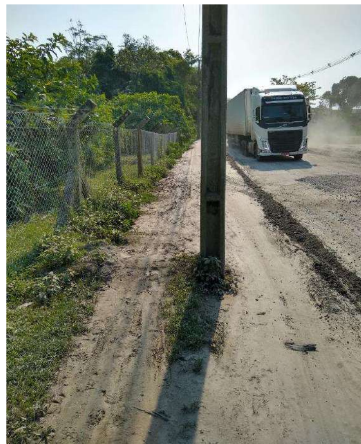
Figura 6 – Calçada com interferência do poste
