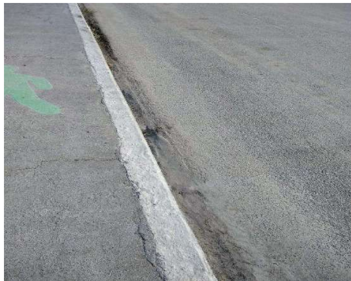
Figura 4 – Rua após passagem da máquina.
