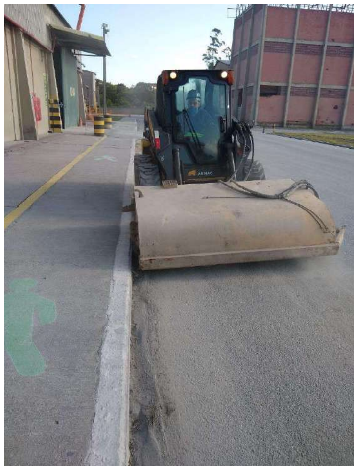
Figura 6 – Limpeza de ruas de fábrica, realizada com Bob cat com implemento de vassoura recolhadora.
