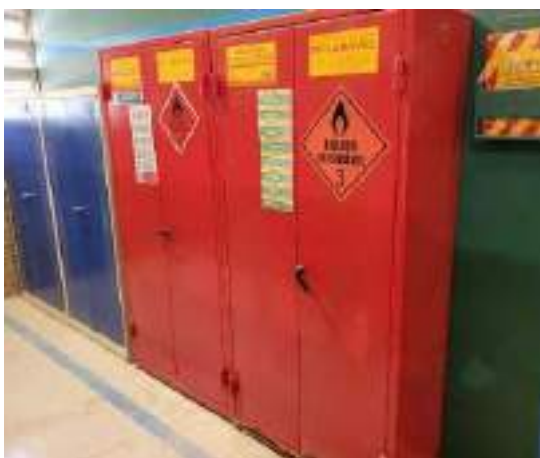
Armário para produtos inflamáveis localizado no almoxarifado (Dez-2023)
