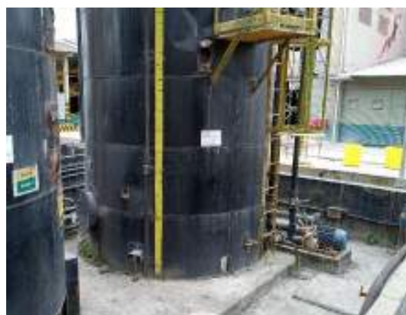
Tanques aéreos de aditivos localizados internamente a bacia de contenção (Dez-2023)
