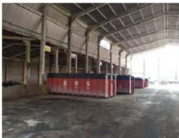
Central de resíduos não perigosos (atualmente desativada) (Dez-2023)
