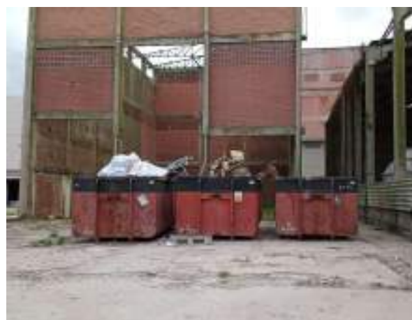
Central de resíduos não perigosos (provisória) (Dez-2023)
