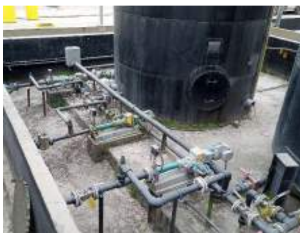
Tanques aéreos de aditivos localizados internamente a bacia de contenção (Dez-2023)
