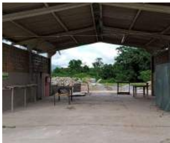
Área da Caldeiraria (Dez-2023)
