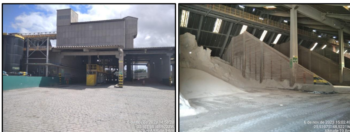
Figura 3 – Vistas da área industrial.
