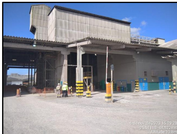
Figura 4 – Vista da área industrial.
