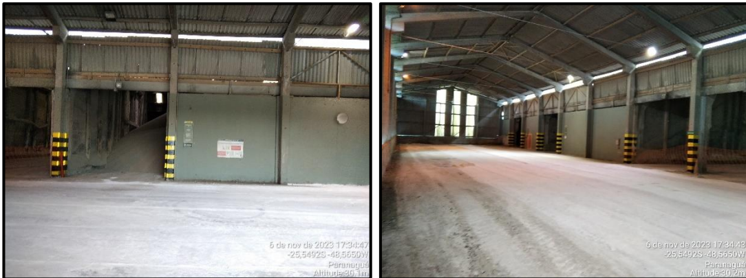
Figura 17 – Portas com fechamento e local coberto para evitar lançamento de material particulado no ambiente.
