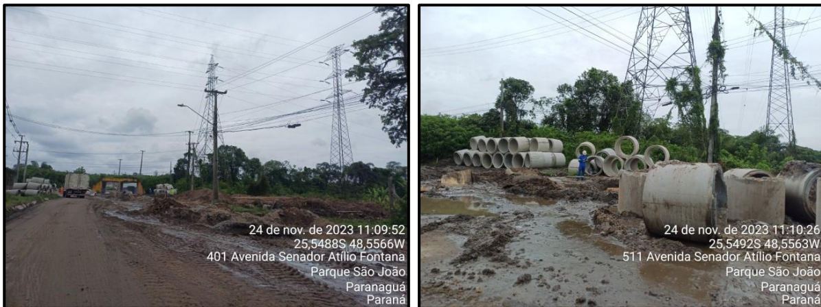
Figura 19 – Obras na Avenida Senador Atílio Fontana em novembro de 2023.
