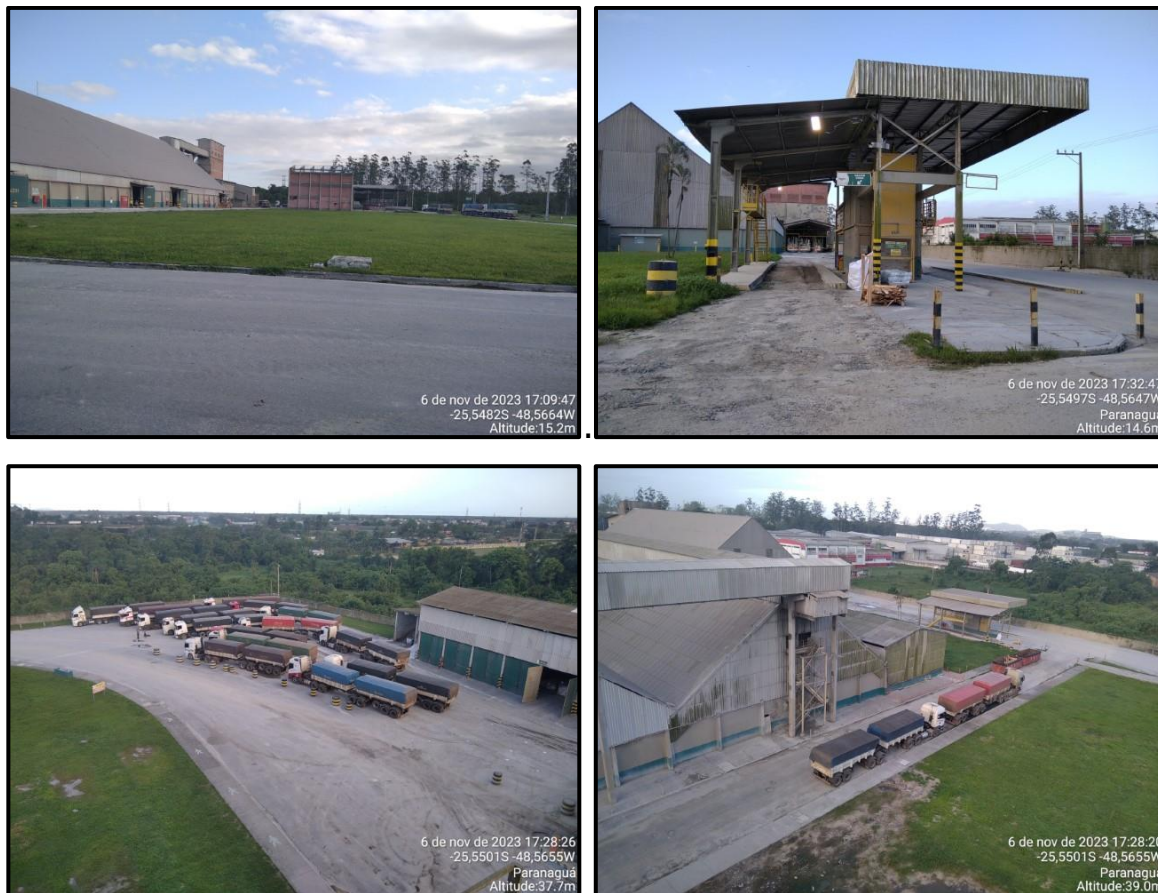
Figura 4 – Vistas da área industrial.
