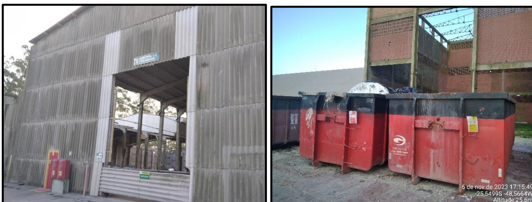
Figura 18 – Central e baias para separação de resíduos.
