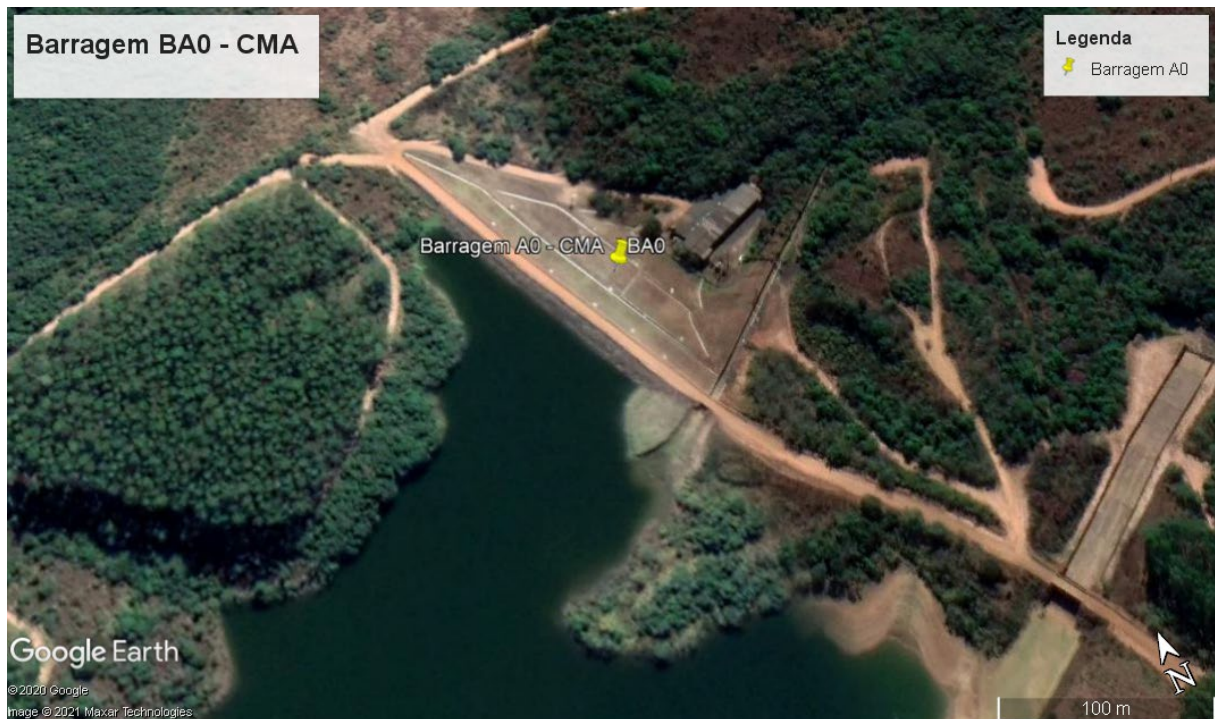
Figura 3.1 - Vista geral aérea da Barragem A0 (Google Earth, 2020).
