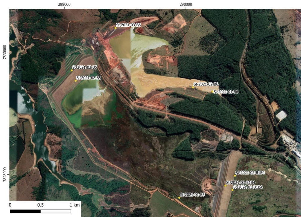
Figura 10.3 - Localização das amostras realizadas nas barragens B1/B4, B5 e B6 no Complexo de Mineração de Araxá
