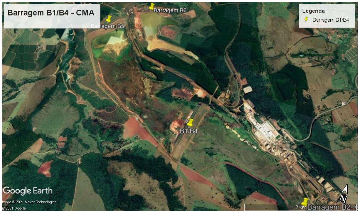
Figura 3.1 - Vista geral aérea da Barragem B1B4.
