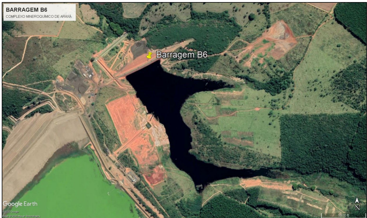
Figura 3.1 - Vista geral aérea da Barragem B6
