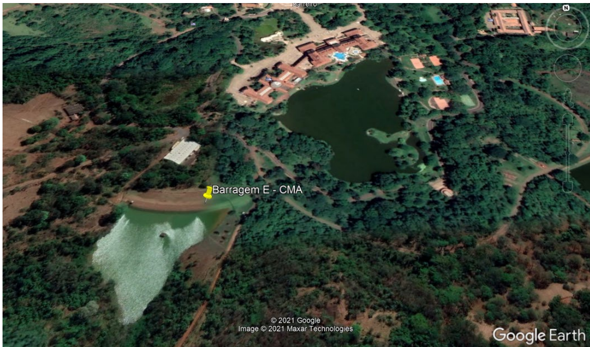
Figura 3.1 - Vista geral aérea da Barragem E
