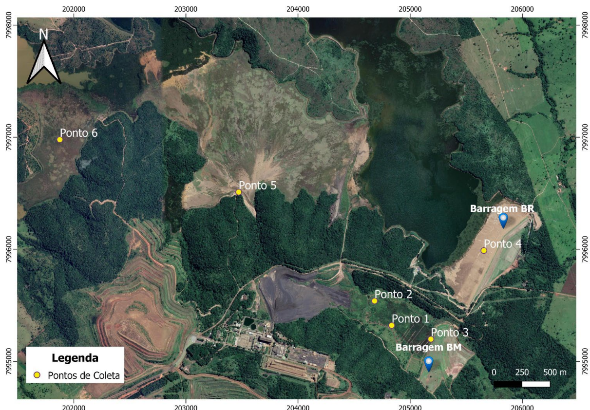
Figura 10-1 - Localização dos pontos de amostragem (fonte: WA06621000-1-GT-RTE-0157 – Walm, 2022)
